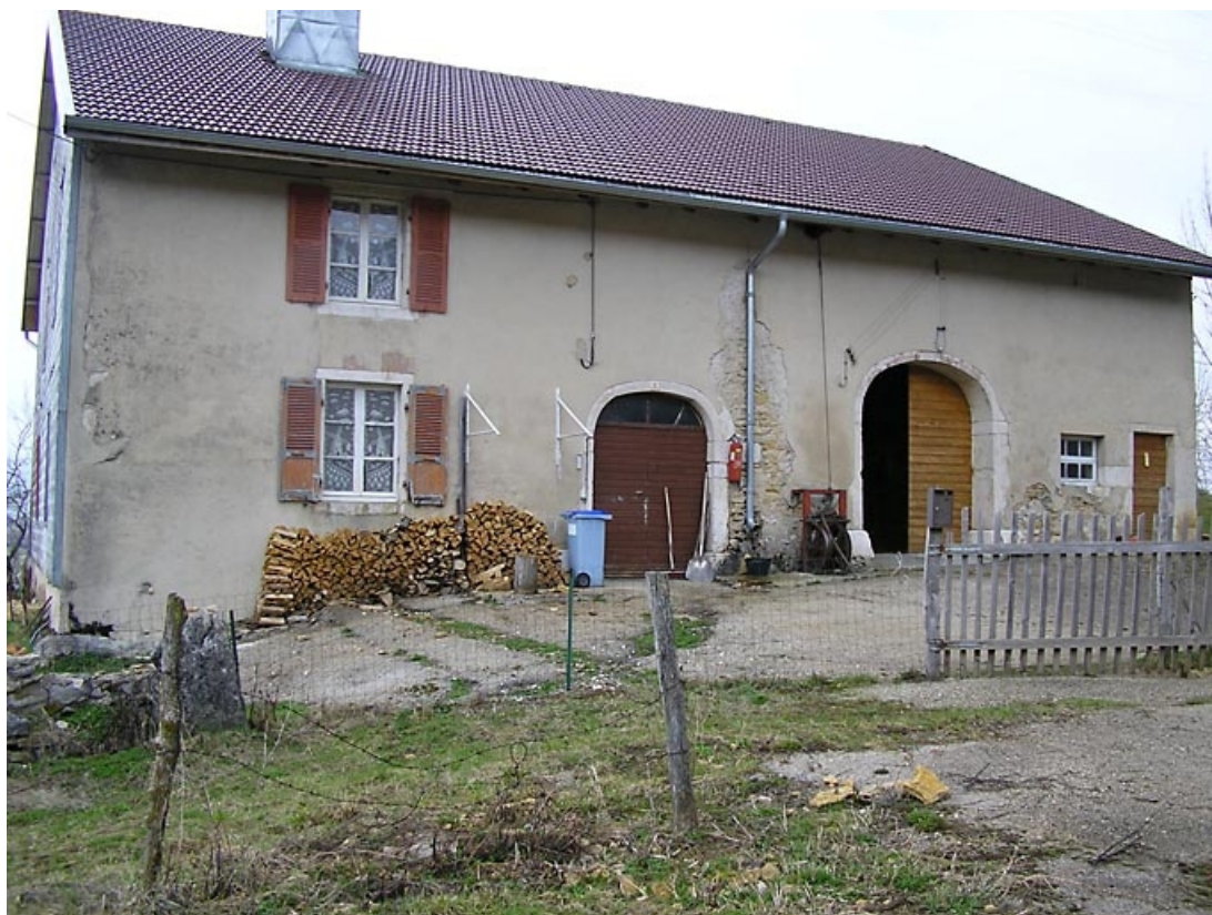
Façade antérieure et une partie du pignon sud-ouest vues de trois quarts. 39, Grande-Rivière
