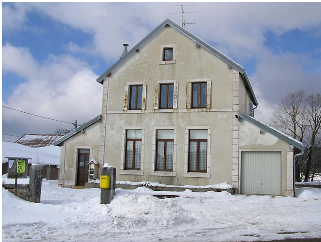
Façade antérieure. 39, Grande-Rivière
