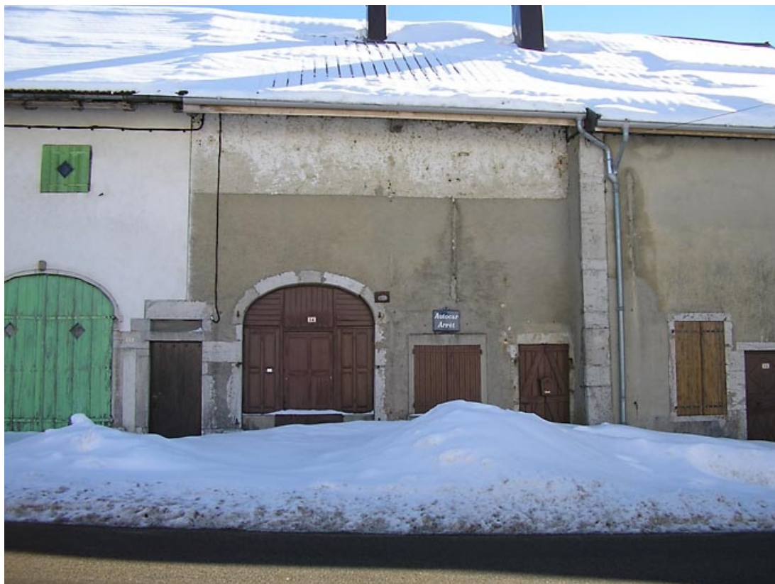
Façade antérieure. 39, Grande-Rivière
