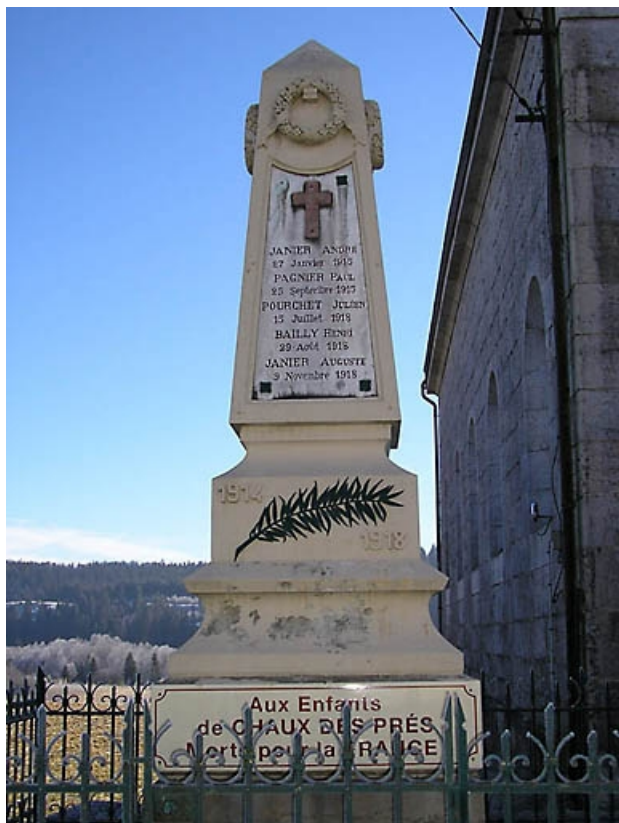
Vue de la partie du monument dédié à 1914-1918. 39, Chaux-des-Prés
