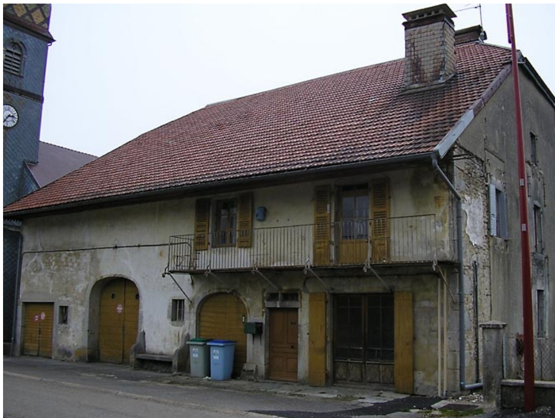
Vue de trois quarts sur façade antérieure.
