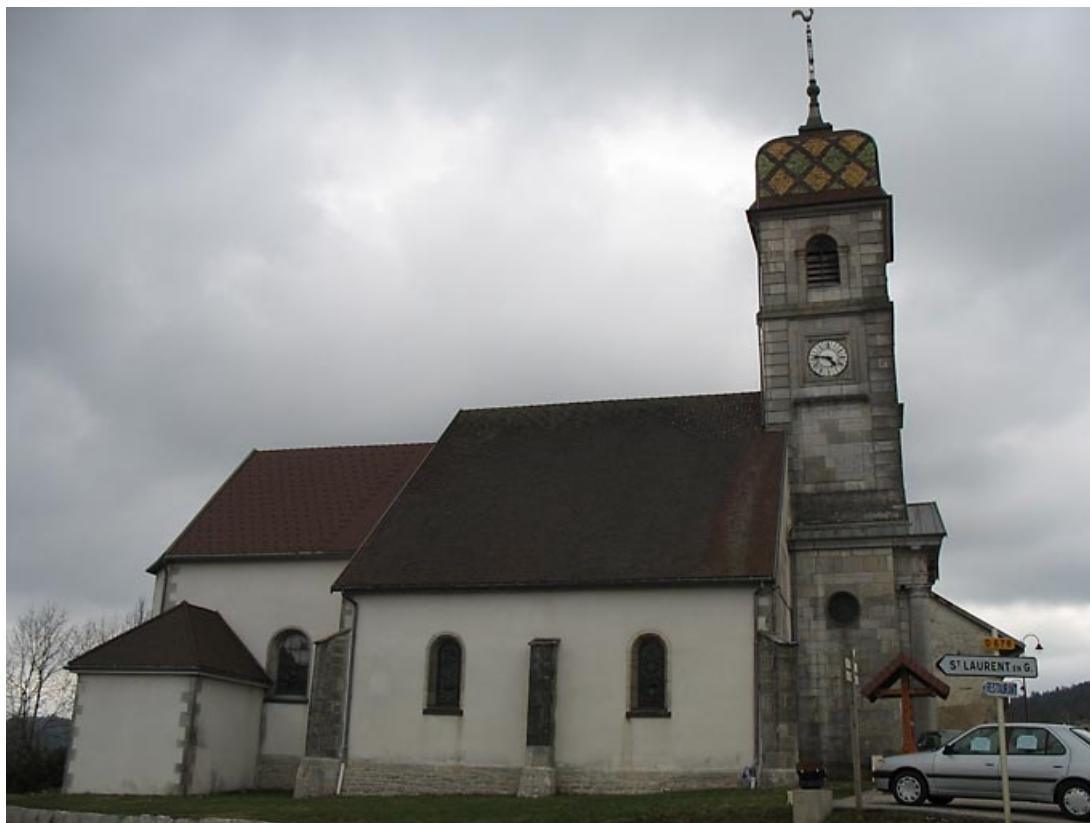
Vue générale sur la façade latérale et le clocher.
