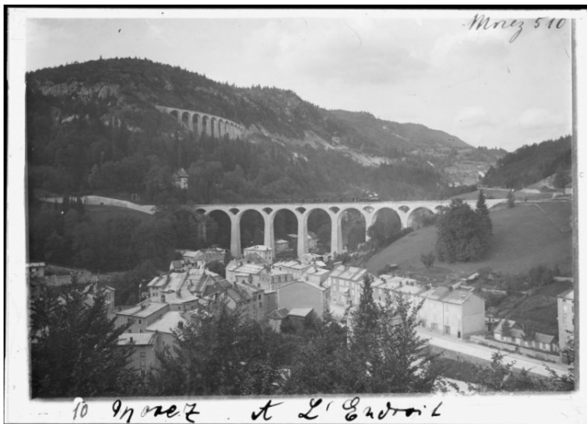
[Le bas de Morez et le grand viaduc, en avant de la vallée de l'Evalude], après 1912. 39, Morez
