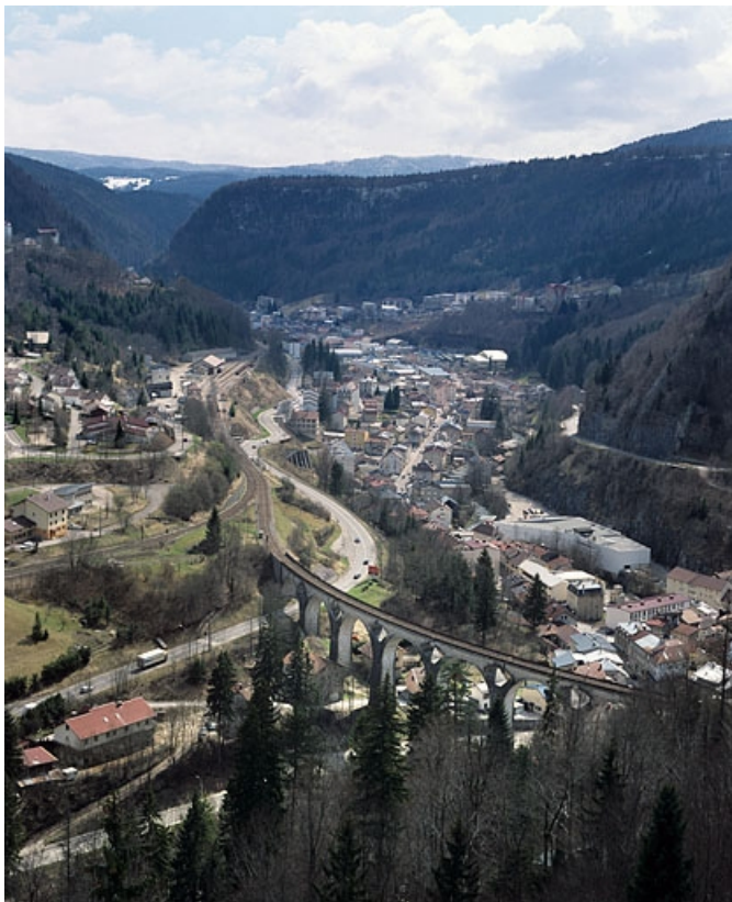
La vallée depuis le viaduc des Crottes, au nord. 39, Morez
