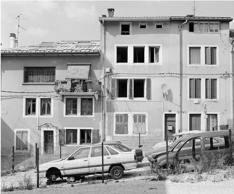
Maison et immeuble (18e et 19e siècles) aux n° 1 et 3 rue de la Paix. Bâtiments (AD 82 à 85) avec ateliers signalés par des fenêtres multiples et des fenêtres lunetières (sous le toit à droite). Le linteau de la porte de droite (3 rue de la Paix) porte l'inscription : C 1726 M.
