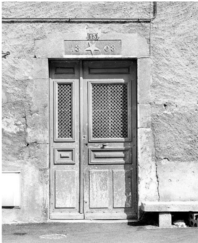
Maison avec atelier (19e siècle) au n° 13 rue de la Concorde : porte d'entrée. Maison (AD 77). 39, Morez
