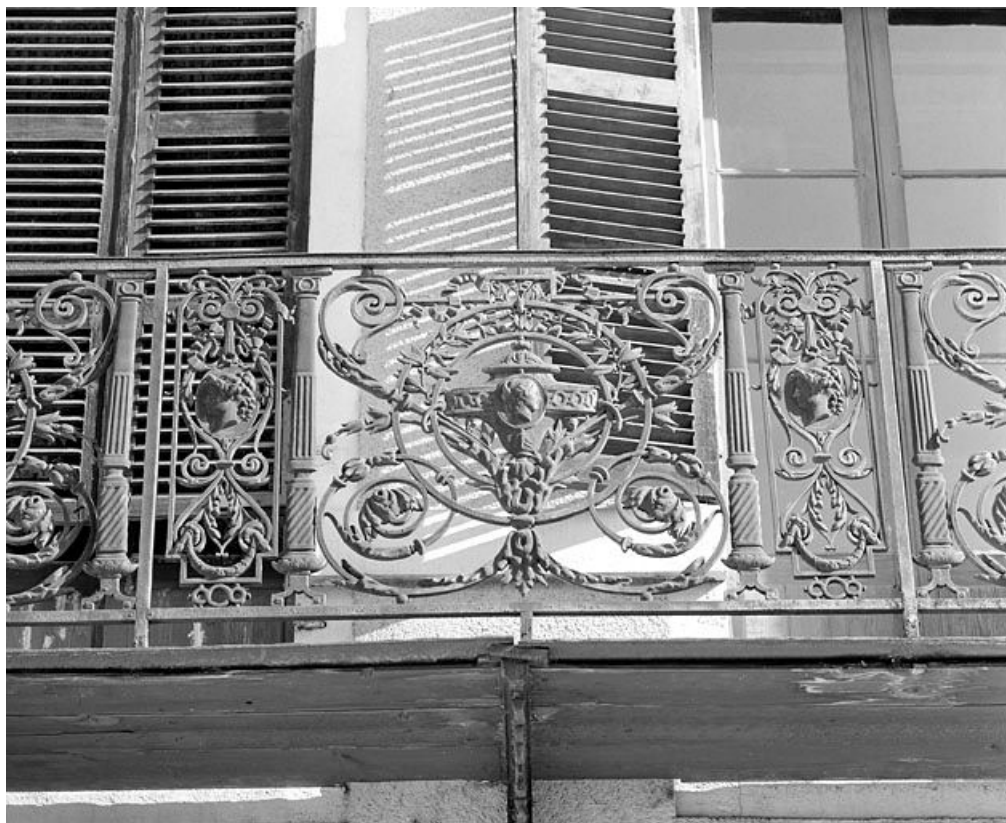
Immeuble (19e siècle) au n° 21 quai Aimé Lamy : motif central du garde-corps du balcon. Immeuble (AI 371). 39, Morez
