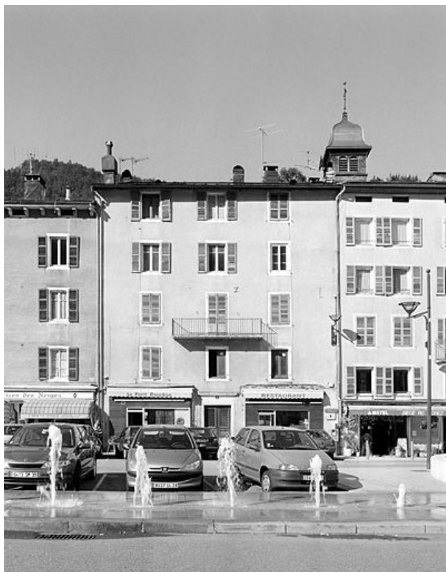
Maison (18e siècle) devenue immeuble avec atelier au n° 3 place Lissac. Maison (AI 210) portant la date 1771. 39, Morez
