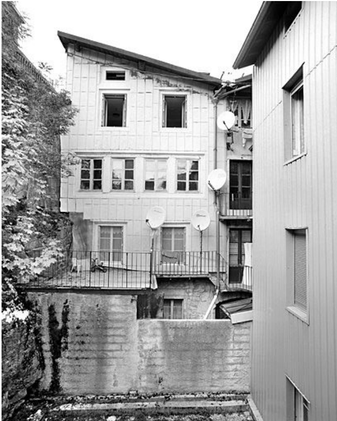
Immeuble avec atelier (18e siècle) au n° 3 place Henri Lissac : fenêtres multiples. Immeuble (AI 210) : élévation sud du corps en retour contre la façade postérieure.
