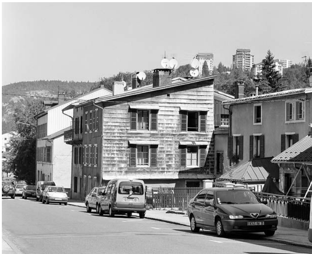
Maison (19e siècle) au n° 211 rue de la République. Maison (AK 100) avec essentage de tôle sur le mur sud. 39, Morez
