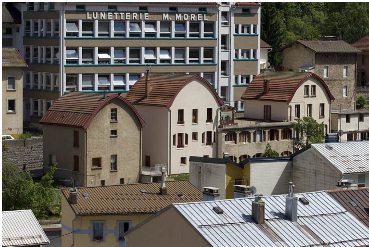
Maisons (20e siècle) aux n° 6, 8 et 12 rue de la Paix : toits en carène. Maisons (AE 44, 51 et 52). 39, Morez
