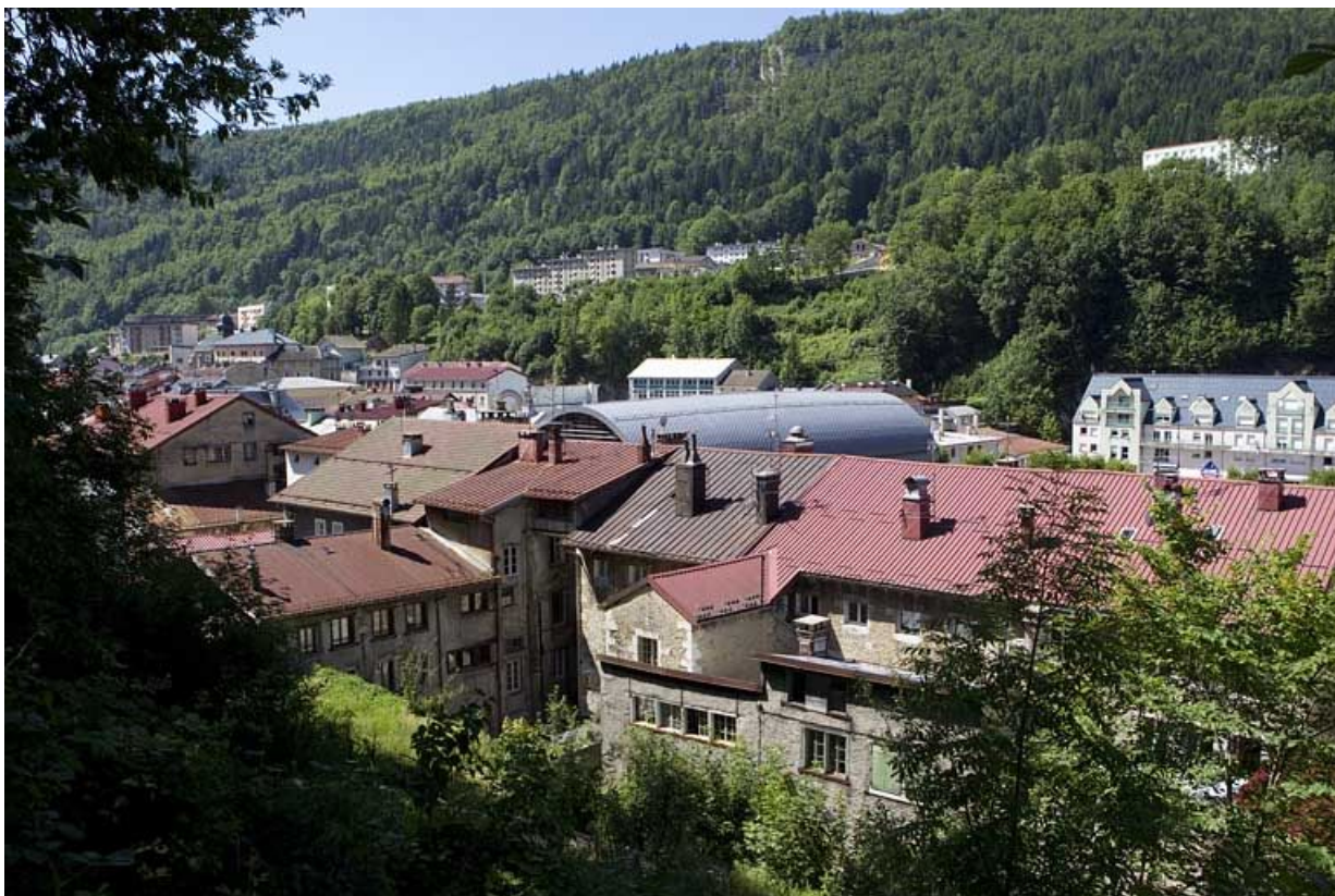
Immeubles (19e siècle) aux n° 129 à 135 rue de la République : élévation postérieure. Immeubles (AE 104 à 106) vus depuis leurs jardins, au nord-est.
