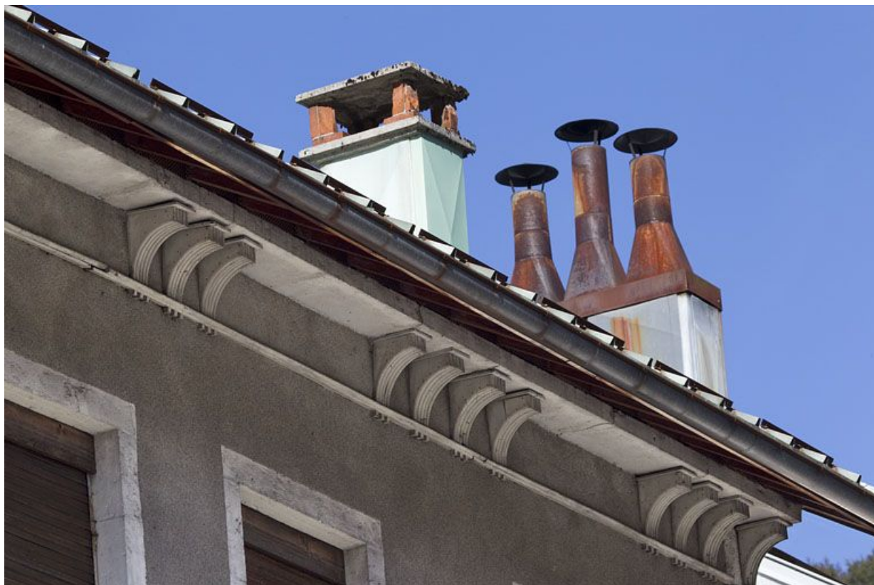
Immeuble (19e siècle) au n° 120 rue de la République : détail de la corniche. Immeuble (AI 28) de la décennie 1860, à l'angle de la rue Ernest Merlin.
