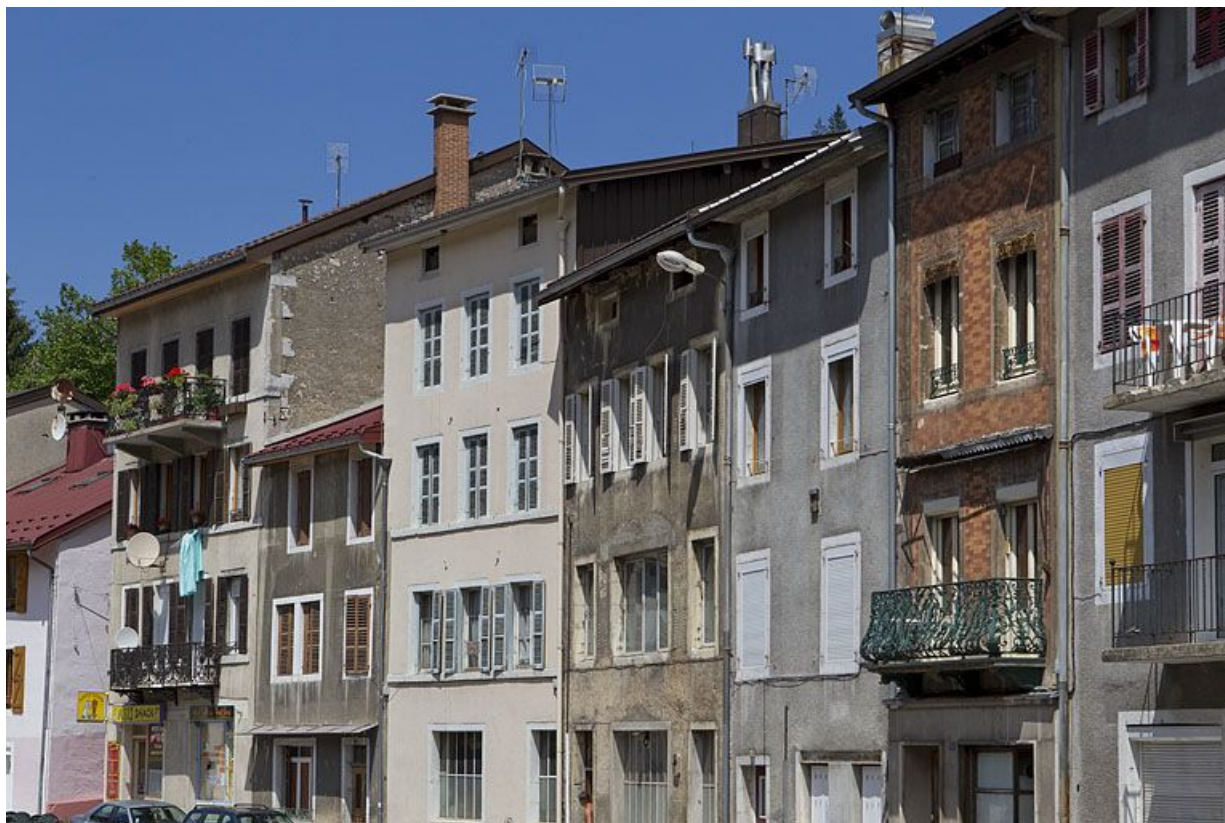
Immeubles (19e siècle) aux n° 21 à 33 quai Aimé Lamy : fenêtres. Immeubles (AI 120, 121, 123 à 125, 371 et 489). 39, Morez
