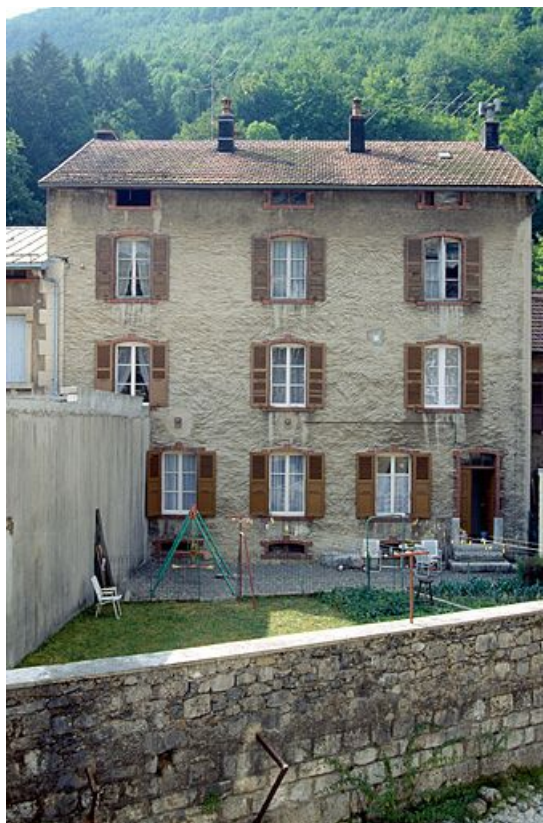
Maison (20e siècle) au n° 13 rue de l'Industrie : élévation postérieure. Maison (AE 20) avec des baies en arc segmentaire à encadrement en briques.
