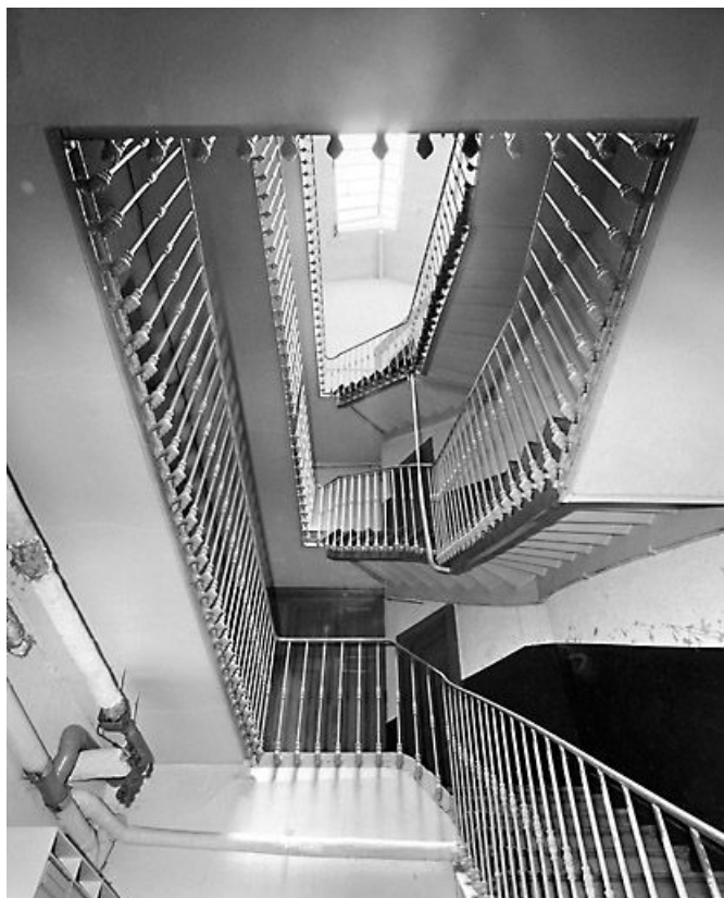
Immeuble (19e siècle) au n° 14 rue des Promenades : l'escalier et sa verrière. Immeuble (AI 44). 39, Morez
