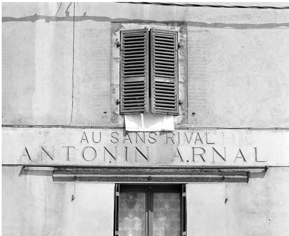
Immeuble (19e siècle) au n° 33 rue de la République : partie centrale de l'enseigne en béton. Immeuble (AD 41). 39, Morez
