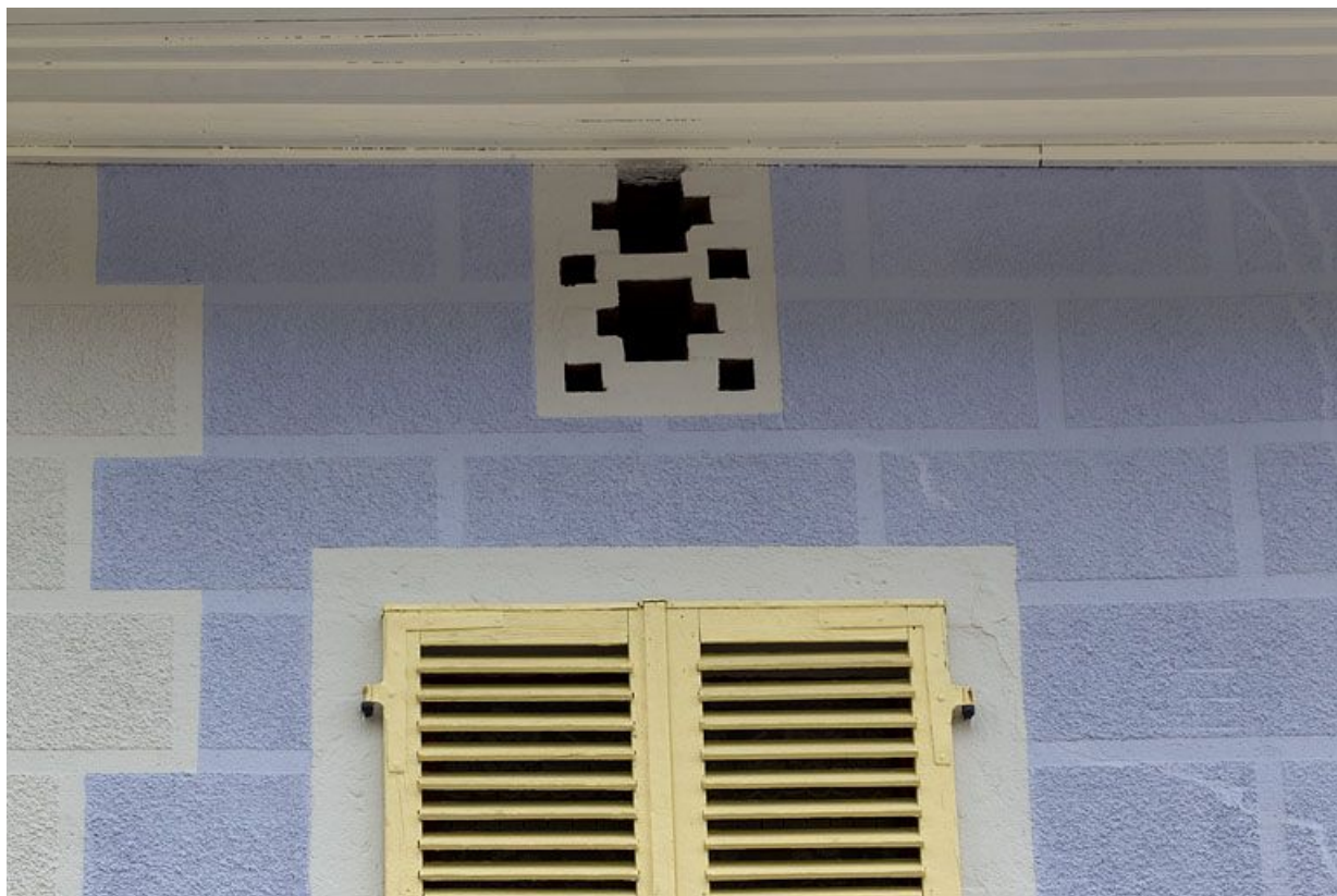
Immeuble (19e siècle) au n° 224 rue de la République : fenêtre du dernier étage et baie aérant le comble. Immeuble (AK 125). 39, Morez
