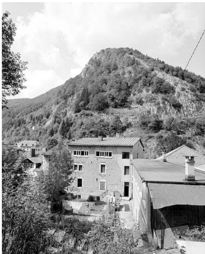
Immeuble avec atelier (19e siècle) au n° 39 rue de la République : fenêtres lunetières. Immeuble (AD 47) : façade postérieure. 39, Morez
