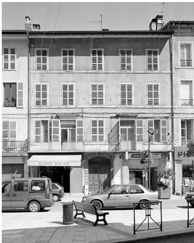
Immeuble avec atelier (19e siècle) au n° 155 rue de la République. Immeuble (AI 76) avec porte cochère et, à l'étage, un balcon filant accessible par deux portes-fenêtres, chacune surmontée d'une corniche. 39, Morez
