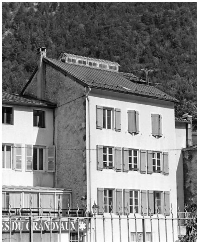
Immeuble (19e siècle) au n° 14 rue des Promenades : corps de bâtiment secondaire donnant sur le n° 10 Petit Quai. Immeuble (AI 44) avec verrière éclairant la cage d'escalier.
