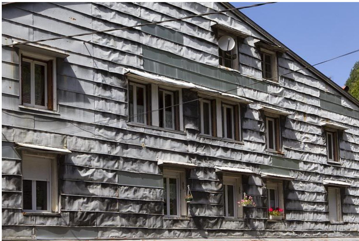
Immeuble avec atelier (19e siècle) au n° 21 rue Emile Zola : essentage de tôle. Immeuble (AK 85). 39, Morez
