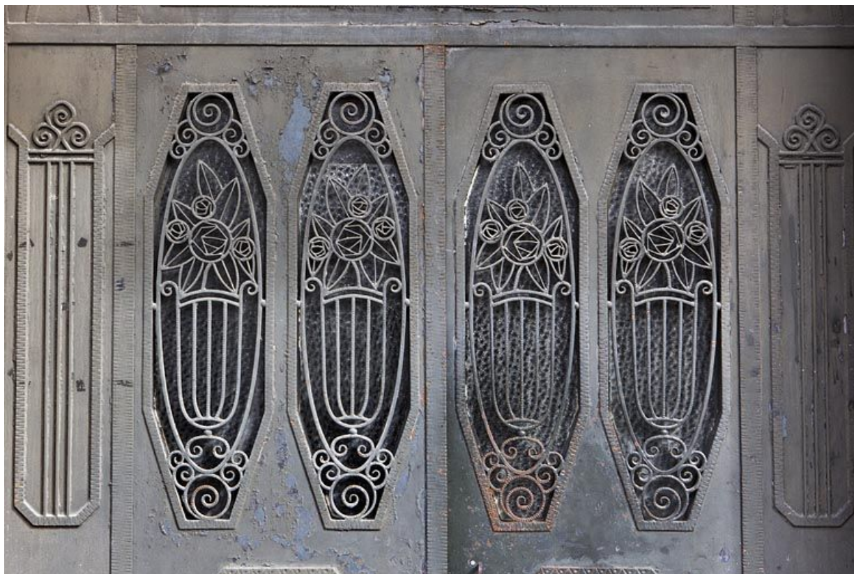
Immeuble avec atelier (18e siècle) au n° 13 quai Aimé Lamy : décor de ferronnerie Art déco. Immeuble (AI 134). 39, Morez
