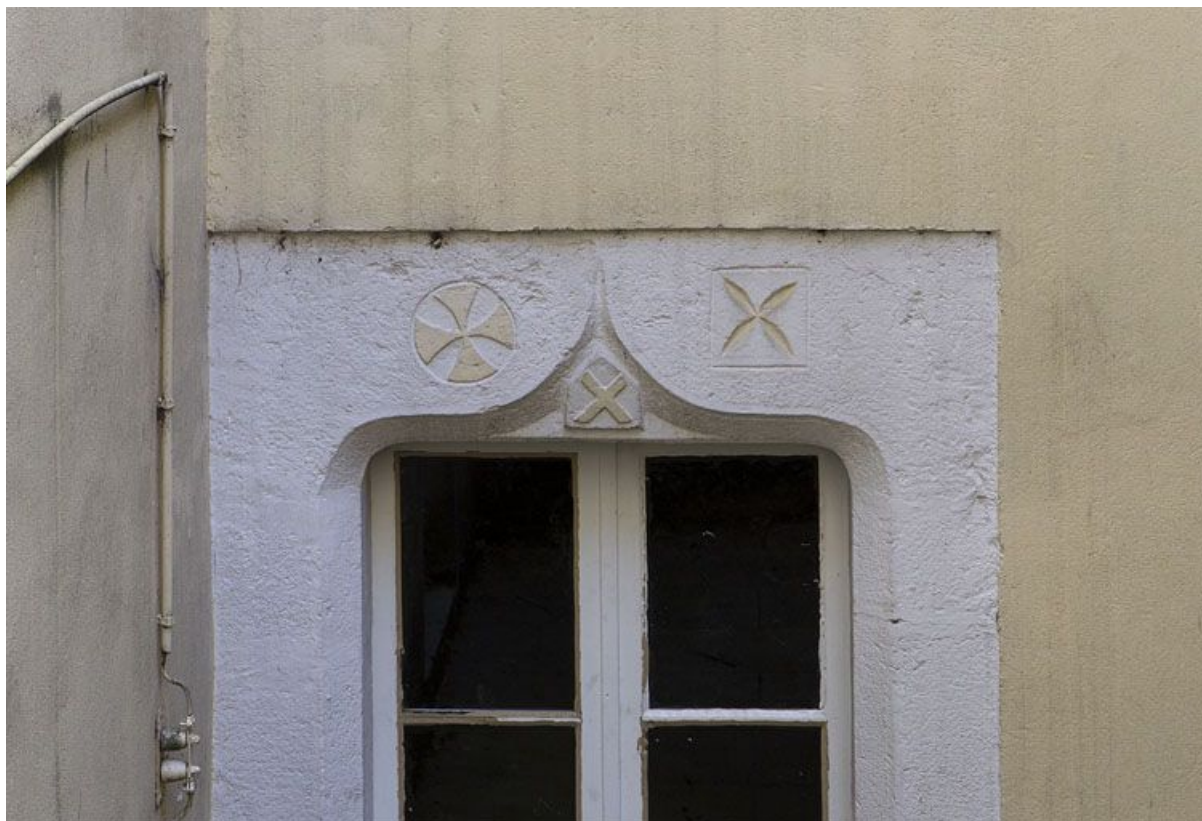
Maison avec atelier (18e siècle ?) au n° 150 rue de la République : linteau coiffé d'un arc en accolade. Maison (AI 525). L'arc en accolade se trouve sur la façade postérieure.
