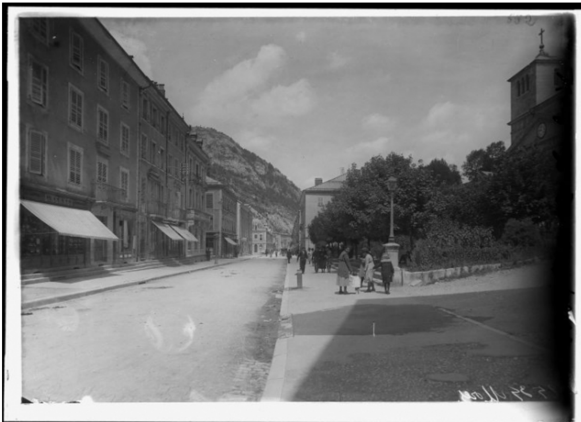
[La rue de la République au niveau de la place Notre-Dame], 1er quart 20e siècle. 39, Morez
