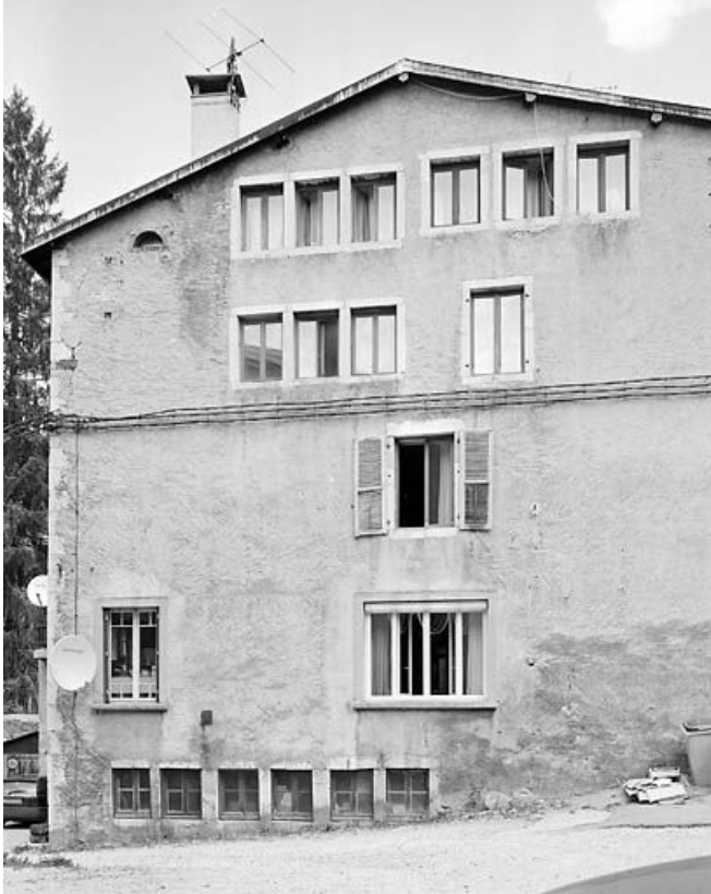
Ancienne usine d'horlogerie Bailly-Comte (80 rue de la République). 39, Morez
