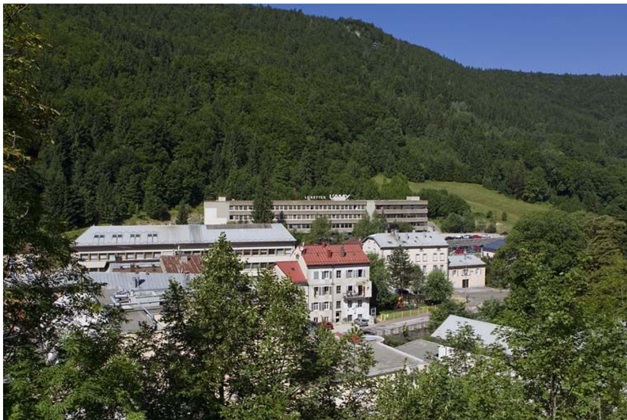
Usine de lunetterie L'Amy : vue d'ensemble du site récent (216 à 220 rue de la République).
