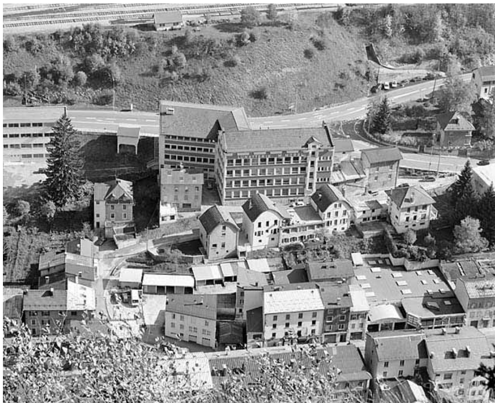
Anciennes usines de lunetterie Marius Morel (18 à 22 avenue Charles de Gaulle) et Cok et Cie (8 à 12 rue de la Paix). L'usine Cok était composée des deux maisons coiffées d'un toit en carène (au centre) et de l'atelier qui les réunit. 39, Morez
