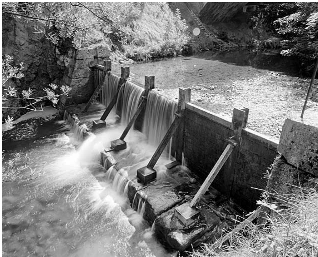
Barrage de l'ancienne usine de l'Abbaye (23 à 31 rue Emile Zola), en aval du pont des Douanes. 39, Morez
