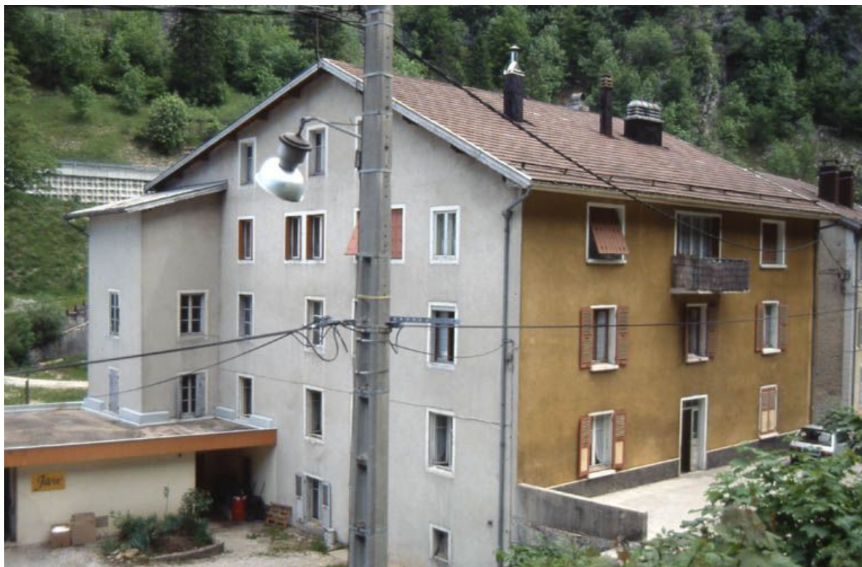
Bâtiment 21 rue Emile Zola : élévation antérieure. Signalé en 1859 comme " Usine François Granger ", ce bâtiment abrite dans la seconde moitié du 20e siècle une partie de la fabrique de branches de lunettes Raoul Girod et Fils. 39, Morez
