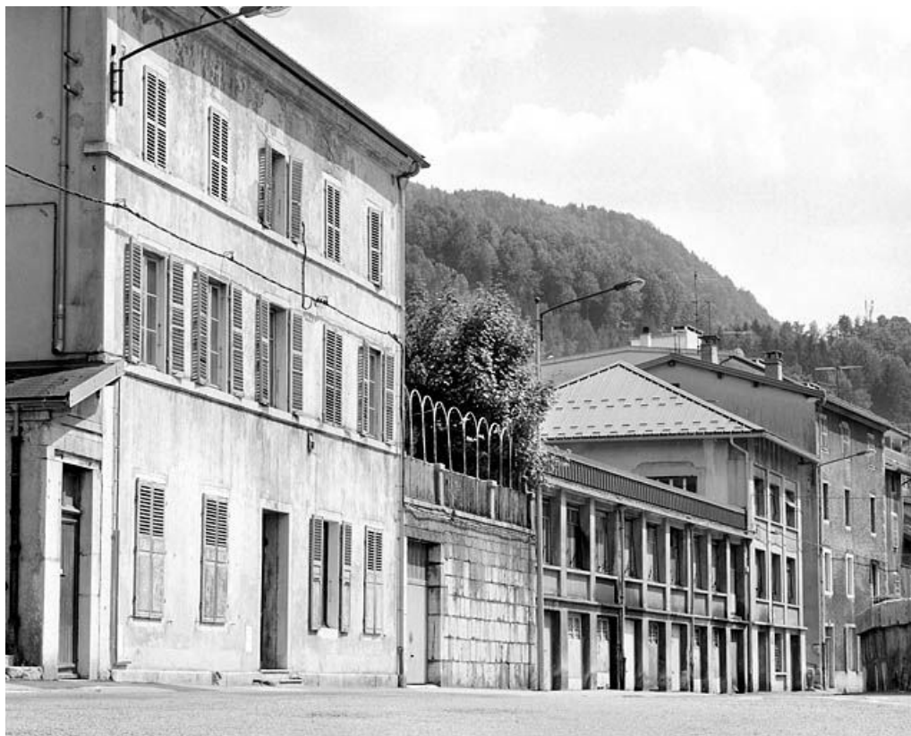
Anciennes usines : atelier d'émaillage à gauche (35 et 35 bis rue de la République), usine de lapidairerie Buffard puis de décolletage des Ateliers mécaniques du Haut-Jura à droite (n° 37 et 37 bis). 39, Morez
