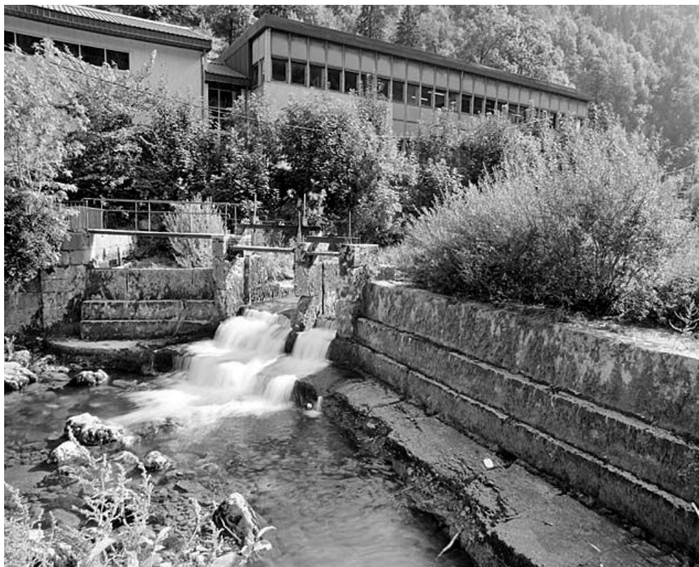
Barrage de l'ancienne usine Cochet (28 à 45 rue Wladimir Gagneur), depuis l'aval. 39, Morez
