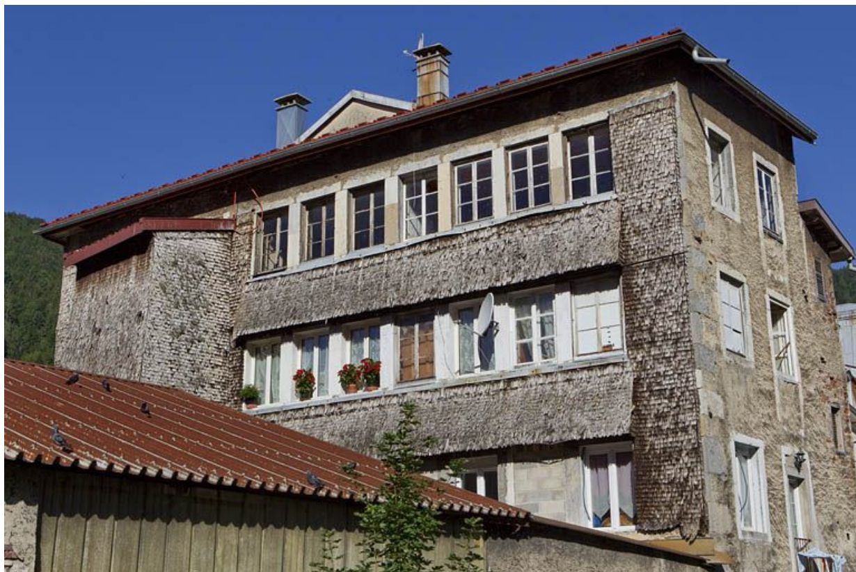
Ancien atelier de lunetterie (5 rue du Docteur Regad) : baies multiples et essentage de tavillons. 39, Morez, 5 rue du Docteur Regad
