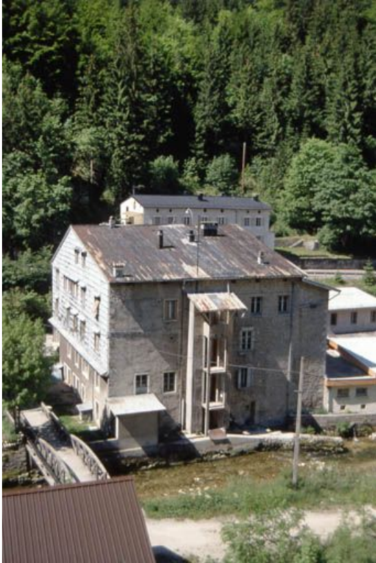
Bâtiment 21 rue Emile Zola : vue plongeante sur l'élévation postérieure. 39, Morez
