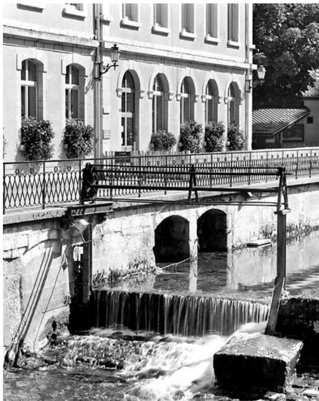
Barrage et prise d'eau de l'ancien site Paul Odobey Fils (1 à 13 cours Paul Odobey). Le canal d'amenée passe sous la mairie. 39, Morez
