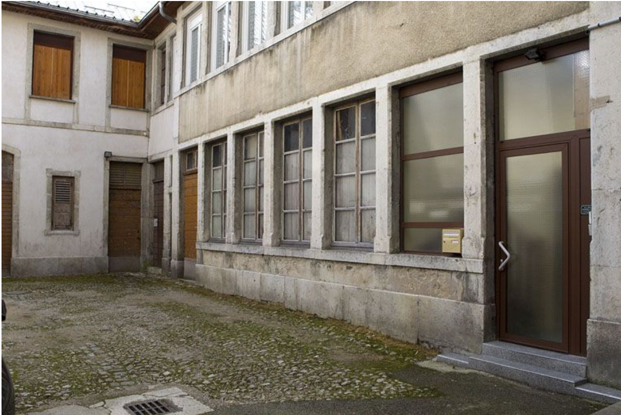
Immeuble (157 rue de la République) : atelier (à baies multiples) dans la cour. 39, Morez, 157 rue de la République
