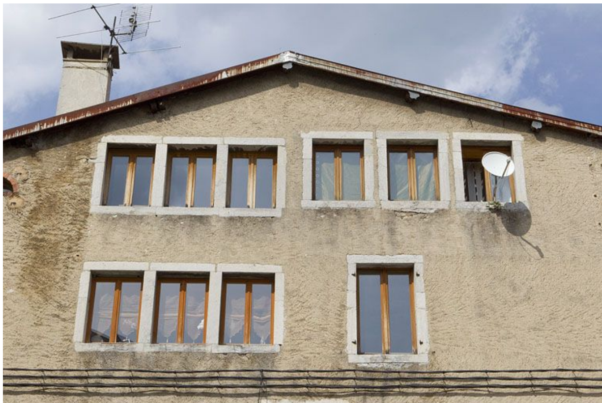
Fenêtres multiples de l'immeuble au 80 rue de la République (AE 33). Les fenêtres multiples de cet immeuble, qui a abrité l'usine d'horlogerie Bailly-Comte, sont d'un module intermédiaire entre la fenêtre courante et la fenêtre lunetière. 39, Morez
