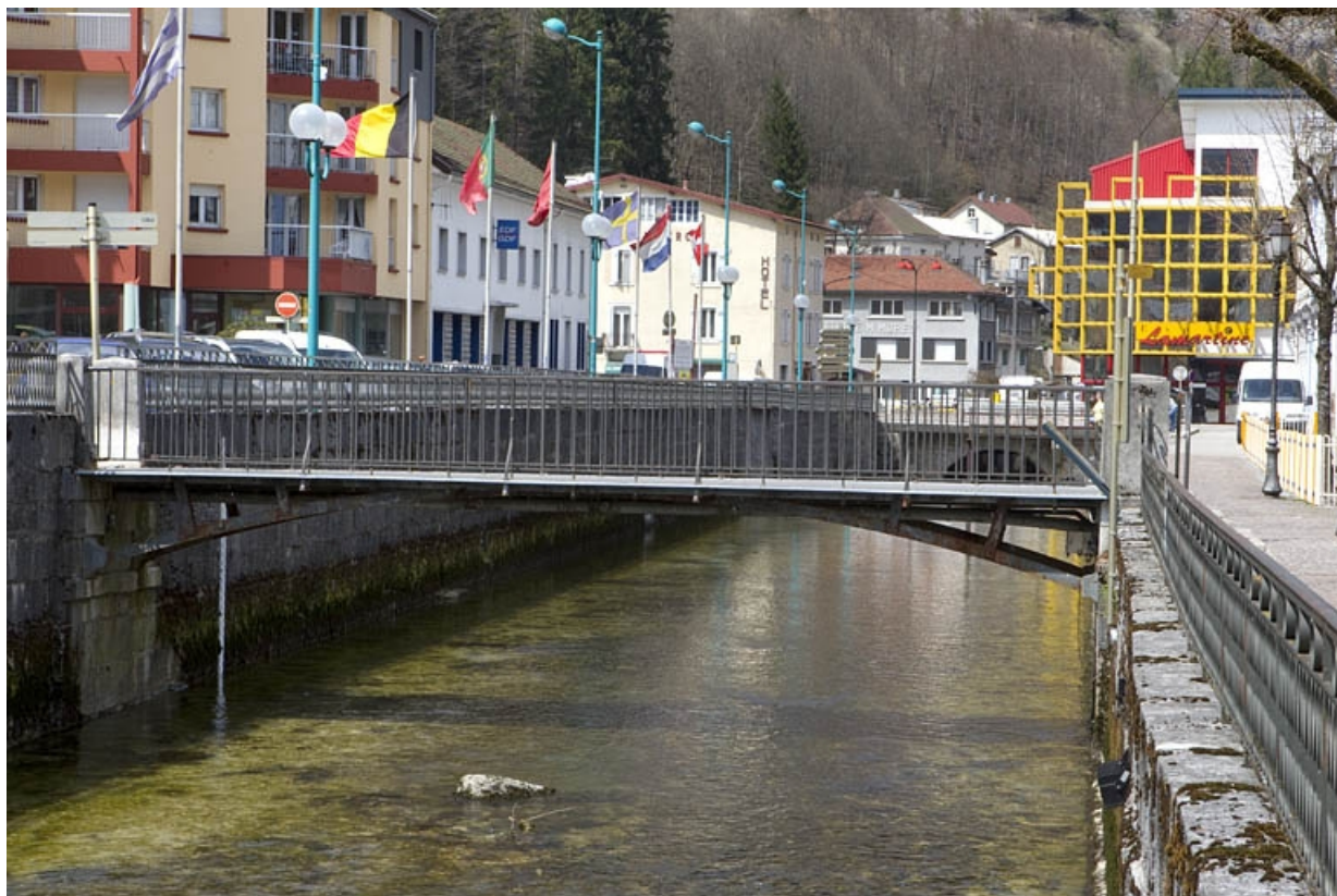
Passerelle aval, vue de l'amont.
