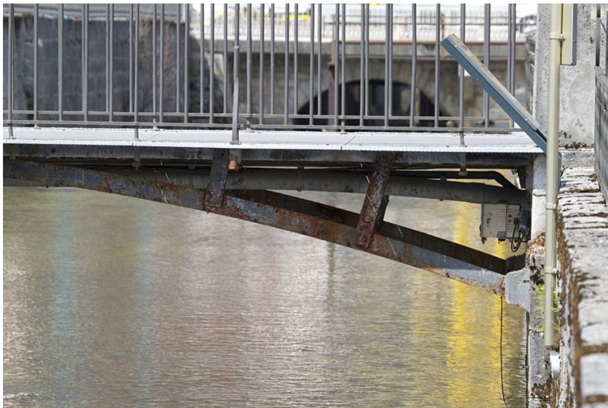
Passerelle aval : détail de l'extrémité rive droite.
