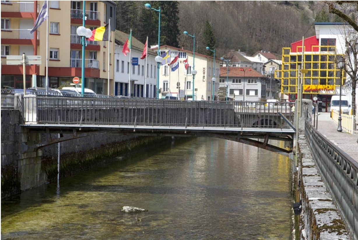
Passerelle aval, vue de l'amont.
