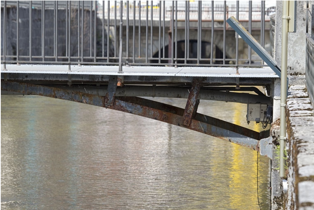
Passerelle aval : détail de l'extrémité rive droite. 39, Morez quai Jobez
