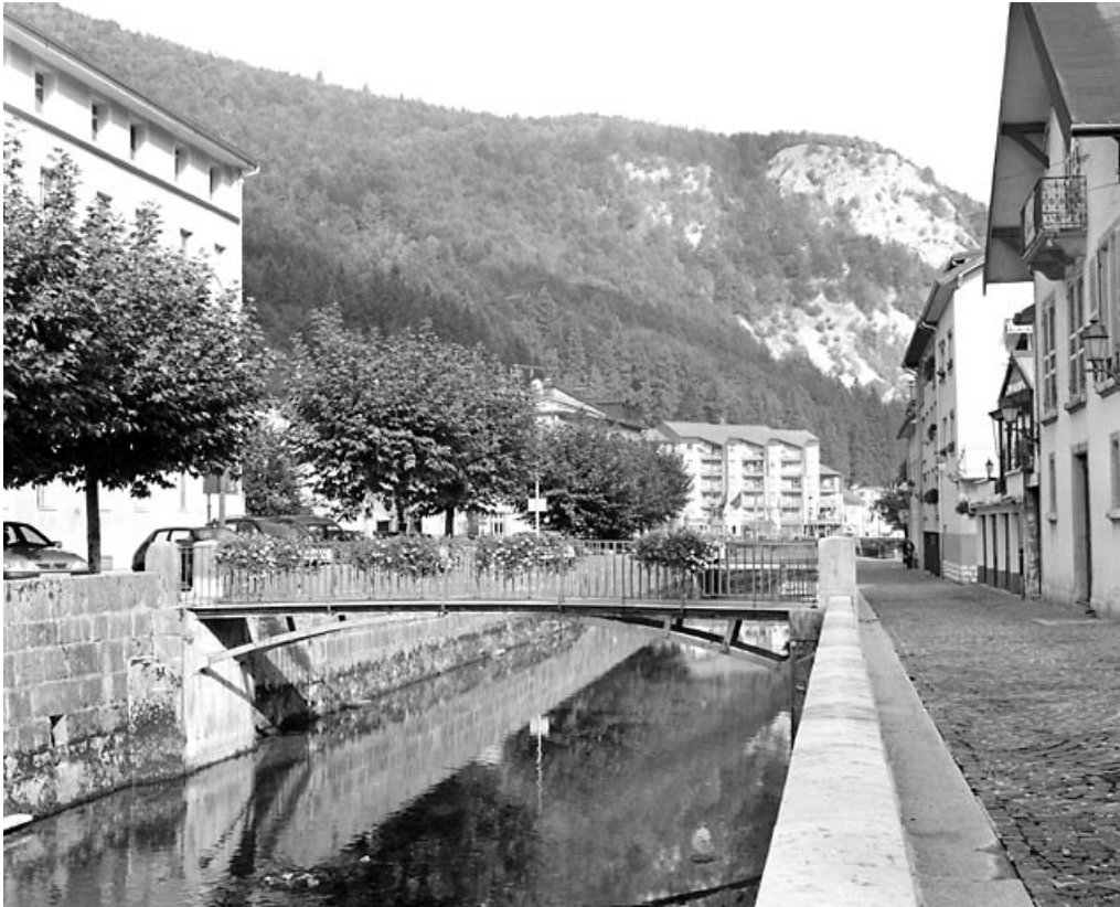
Passerelle amont, vue de l'amont.
