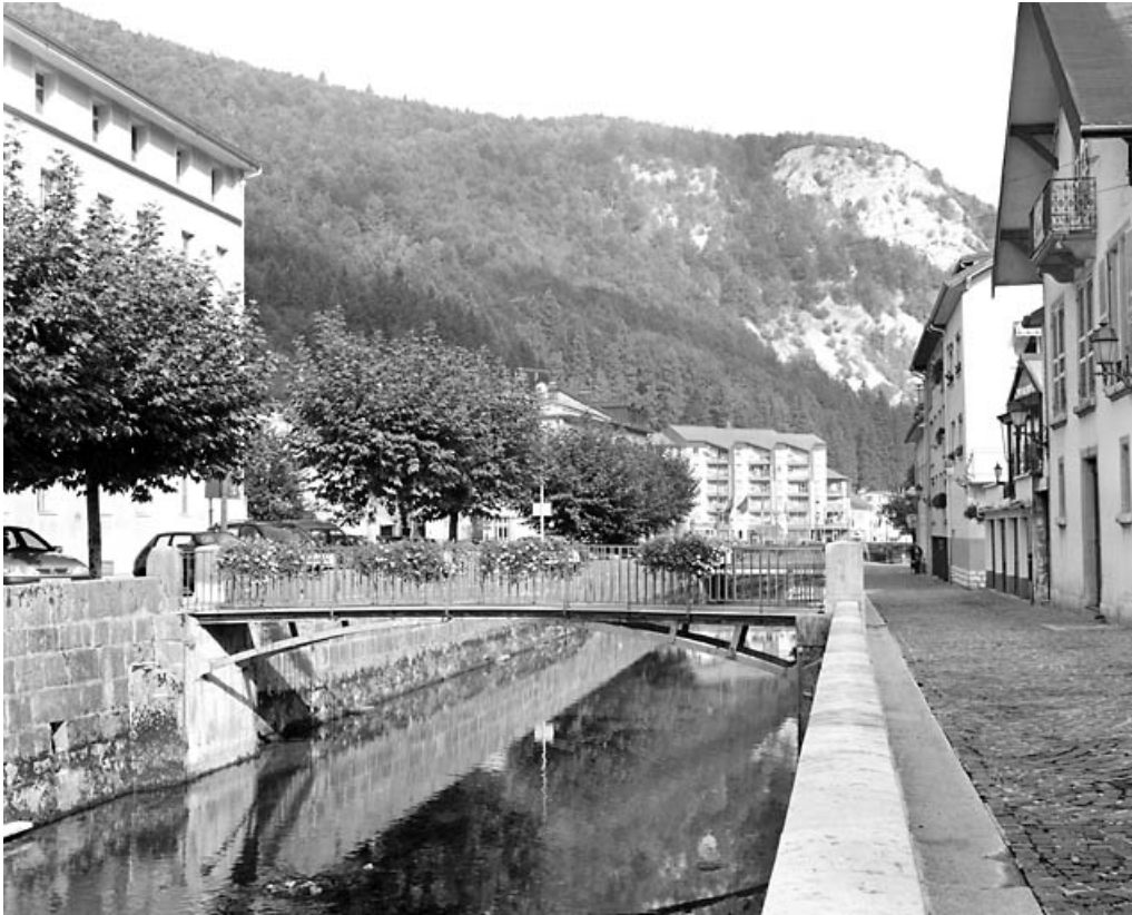
Passerelle amont, vue de l'amont.
