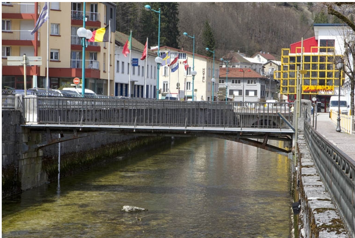
Passerelle aval, vue de l'amont.
