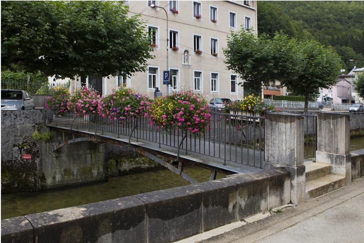
Passerelle amont, vue de trois quarts droite. 39, Morez quai Jobez
