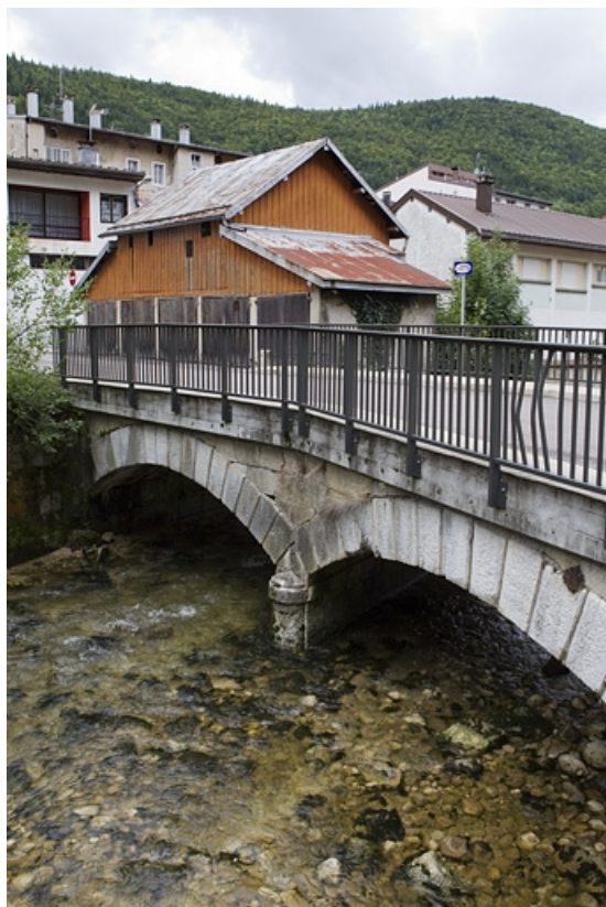
Vue d'ensemble, depuis la rive droite en amont. 39, Morez rue Victor Poupin
