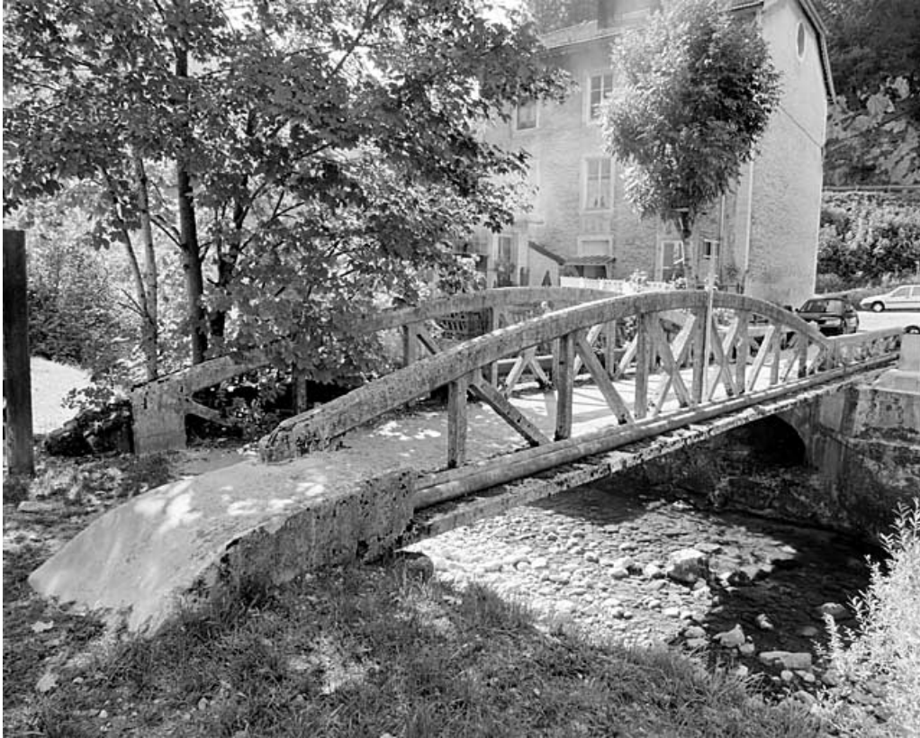
Vue d'ensemble, depuis la rive droite en aval.
