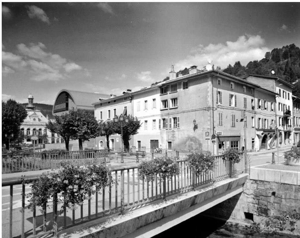
Pont du Curé : tablier et rambardes, depuis la rive gauche en amont. 39, Morez
