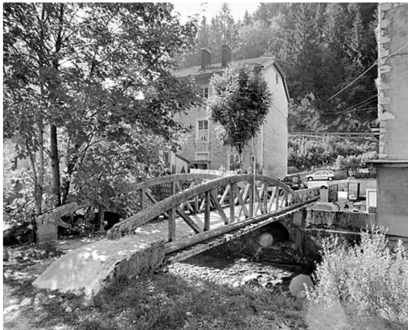
Passerelle de la station de captage : vue d'ensemble depuis la rive droite en aval. 39, Morez
