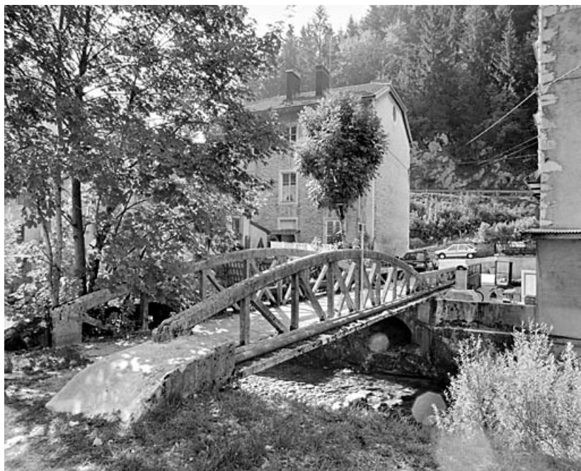
Passerelle de la station de captage : vue d'ensemble depuis la rive droite en aval. 39, Morez
