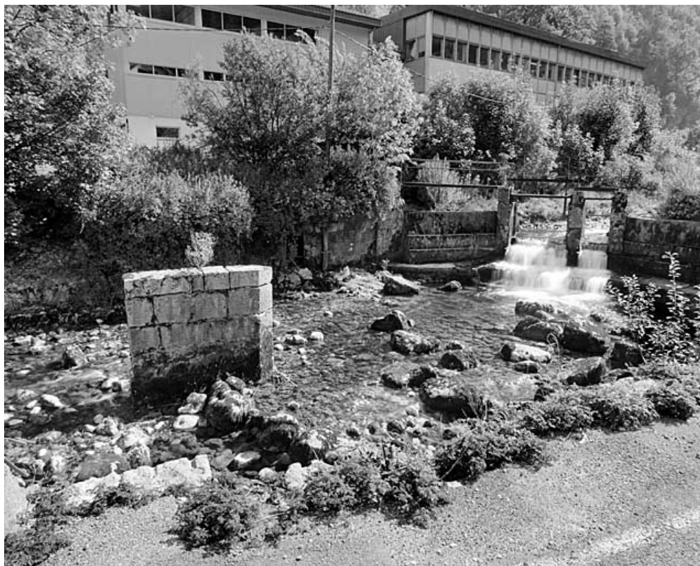
Pile en lit de rivière : vestige d'un pont ou d'une passerelle privés ? Cette pile est située en aval de la passerelle de la station de captage (et du barrage de l'ancienne usine Cochet, visible à droite) et en amont du pont Cochet. 39, Morez
