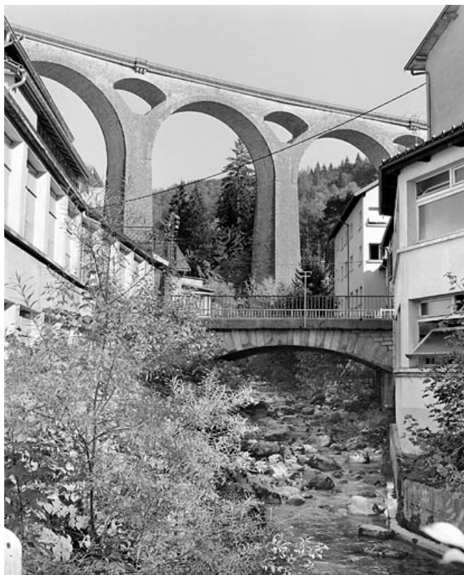
Pont de l'Evalude : vue d'ensemble, depuis la rive droite en aval. En arrière-plan, le grand viaduc de Séjourné portant la voie ferrée Morez - Saint-Claude (tronçon de la ligne Andelot - La Cluse). 39, Morez
