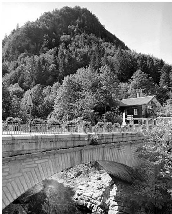
Pont des Douanes : vue de trois quarts, depuis la rive gauche en aval. 39, Morez
