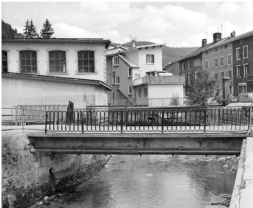
Le pont du Casino en 2000.
