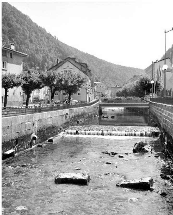
Pont du Curé : vue d'ensemble, depuis la rive gauche en aval. 39, Morez
