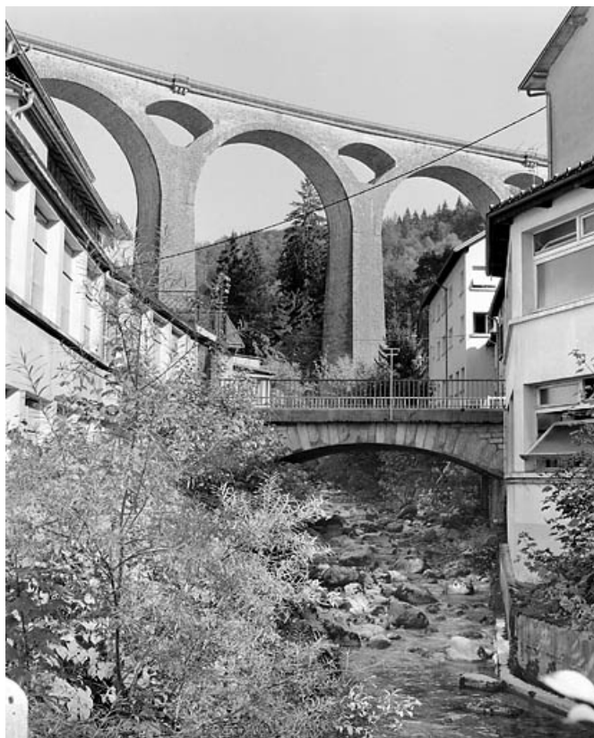
Pont de l'Evalude : vue d'ensemble, depuis la rive droite en aval. En arrière-plan, le grand viaduc de Séjourné portant la voie ferrée Morez - Saint-Claude (tronçon de la ligne Andelot - La Cluse).
