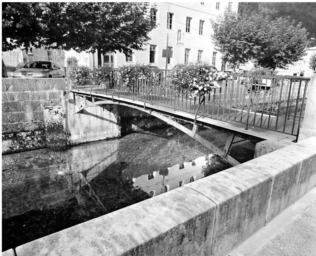
Passerelle du Petit Quai, en amont du pont du Curé. 39, Morez
