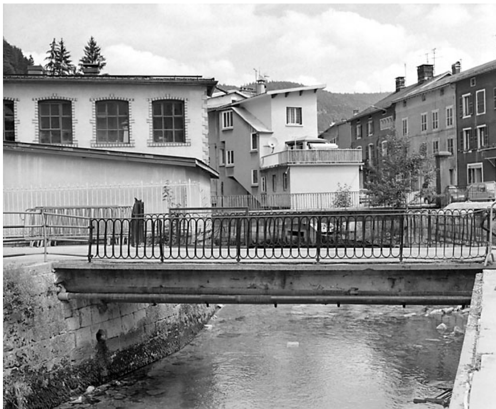
Le pont du Casino en 2000.
