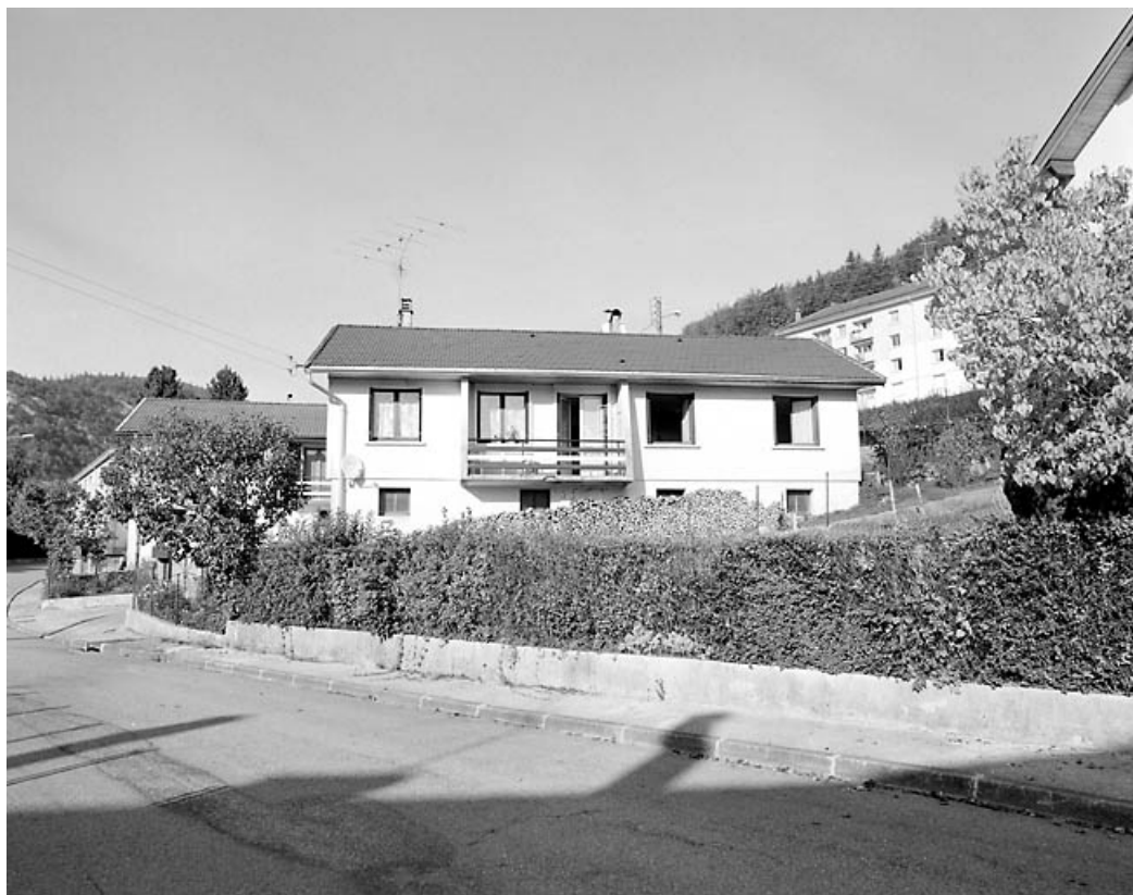
Maison 3 rue de la Die : élévation sud. Maison Duboin type F6 (variante), de 1958-1959.
