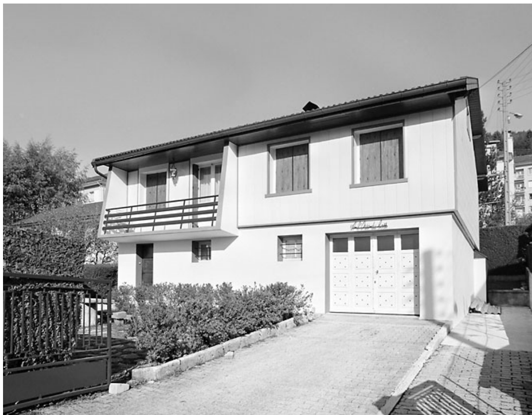
Maison 3 rue de la Verrerie : élévation ouest. Maison Duboin type F5 (variante E), de 1957-1958. 39, Morez avenue de la Libération, lieudit : Villedieu
