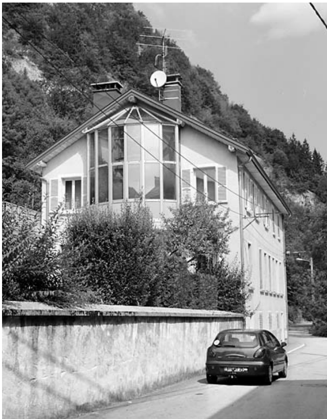
Vue d'ensemble, depuis le sud.
