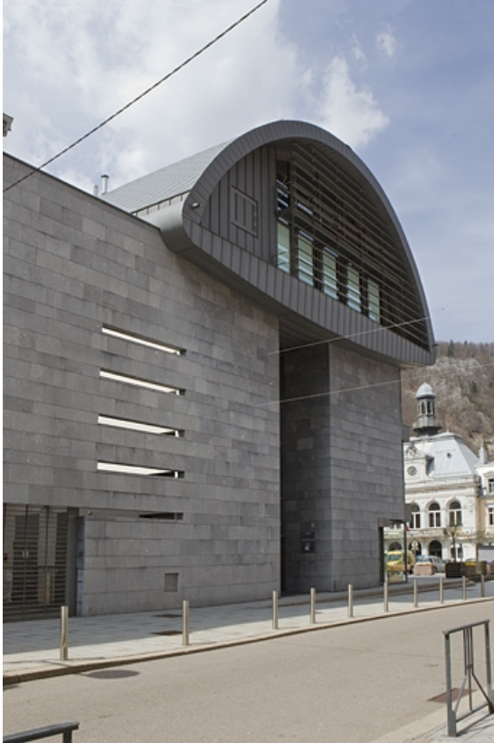
Façade latérale gauche. 39, Morez place Jean Jaurès
