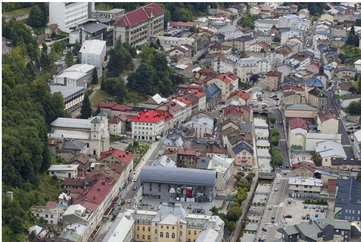
Vue d'ensemble plongeante sur le quartier du musée, depuis le nord-ouest. 39, Morez place Jean Jaurès
