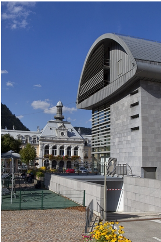
Façade latérale droite.
