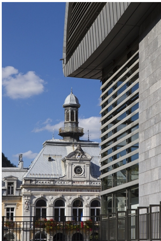
Façade latérale droite : détail.
