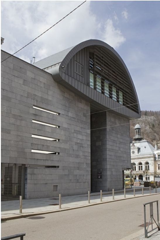
Façade latérale gauche. 39, Morez place Jean Jaurès
