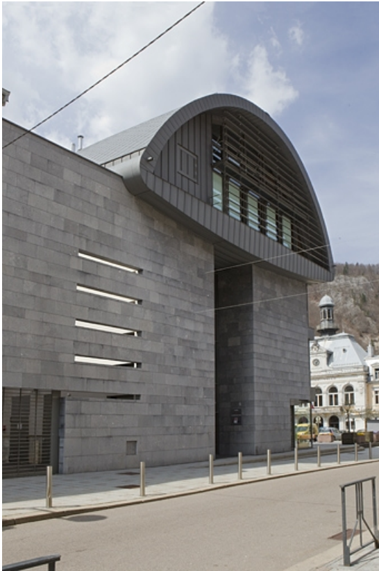
Façade latérale gauche. 39, Morez place Jean Jaurès
