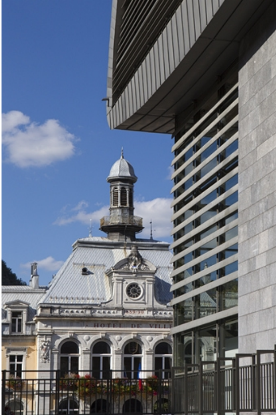
Façade latérale droite : détail.
