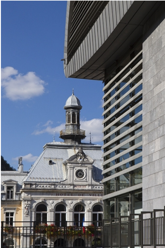
Façade latérale droite : détail.
