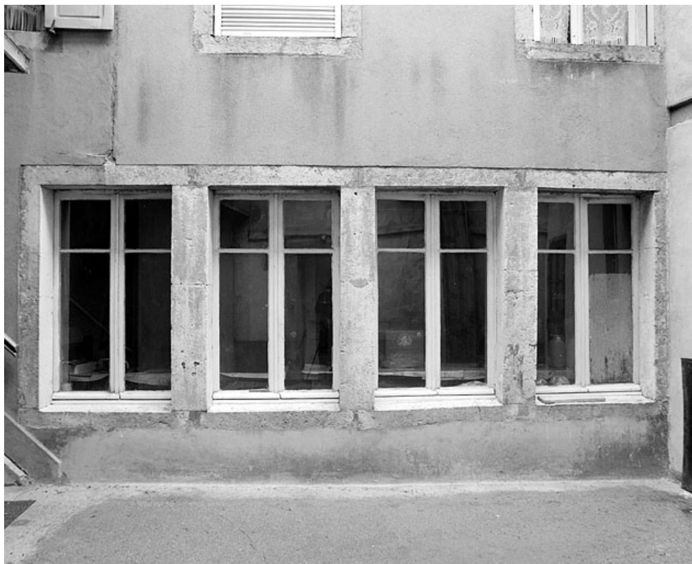
Aile sud : fenêtres jumelées.
