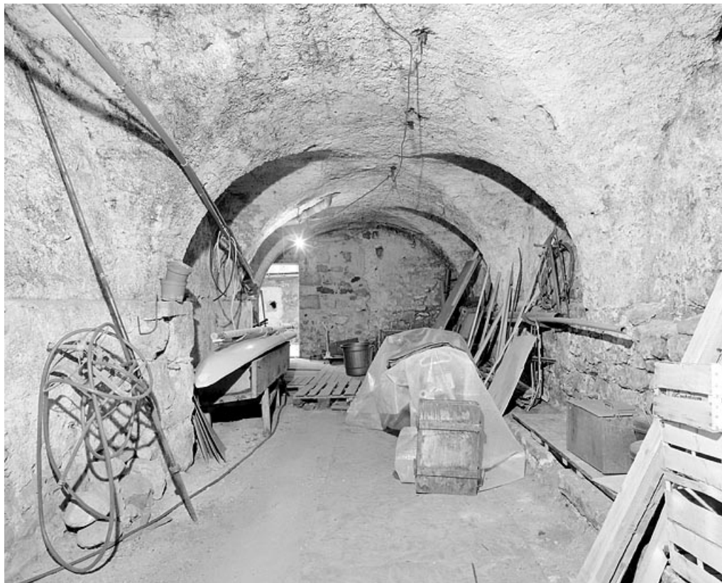
Aile est : rez-de-chaussée voûté. 39, Morez, 15 rue Wladimir Gagneur
