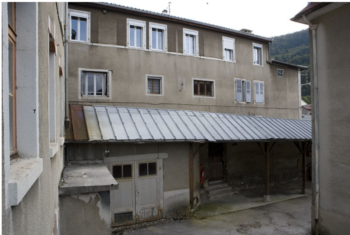
Aile nord, depuis la cour de l'usine voisine. 39, Morez, 15 rue Wladimir Gagneur
