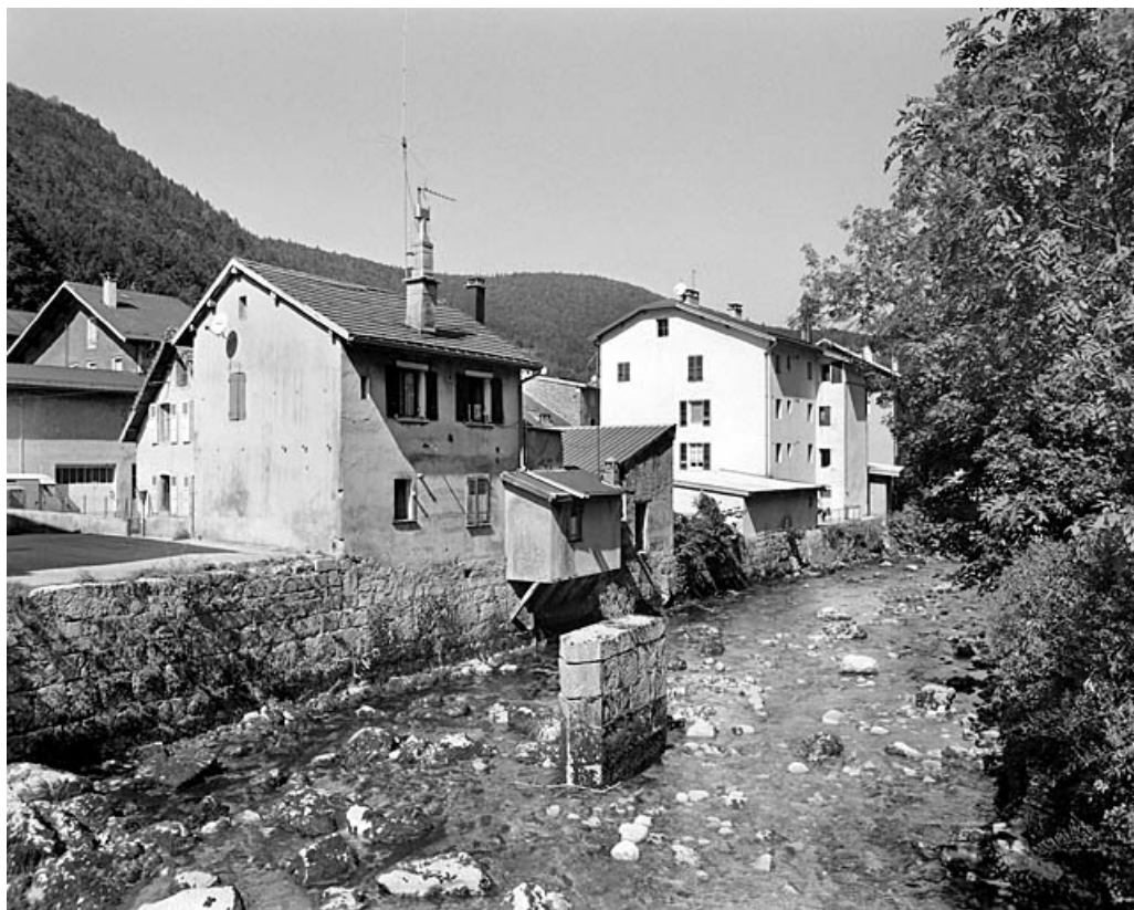
Vue d'ensemble, depuis le sud-est : élévations postérieures.
