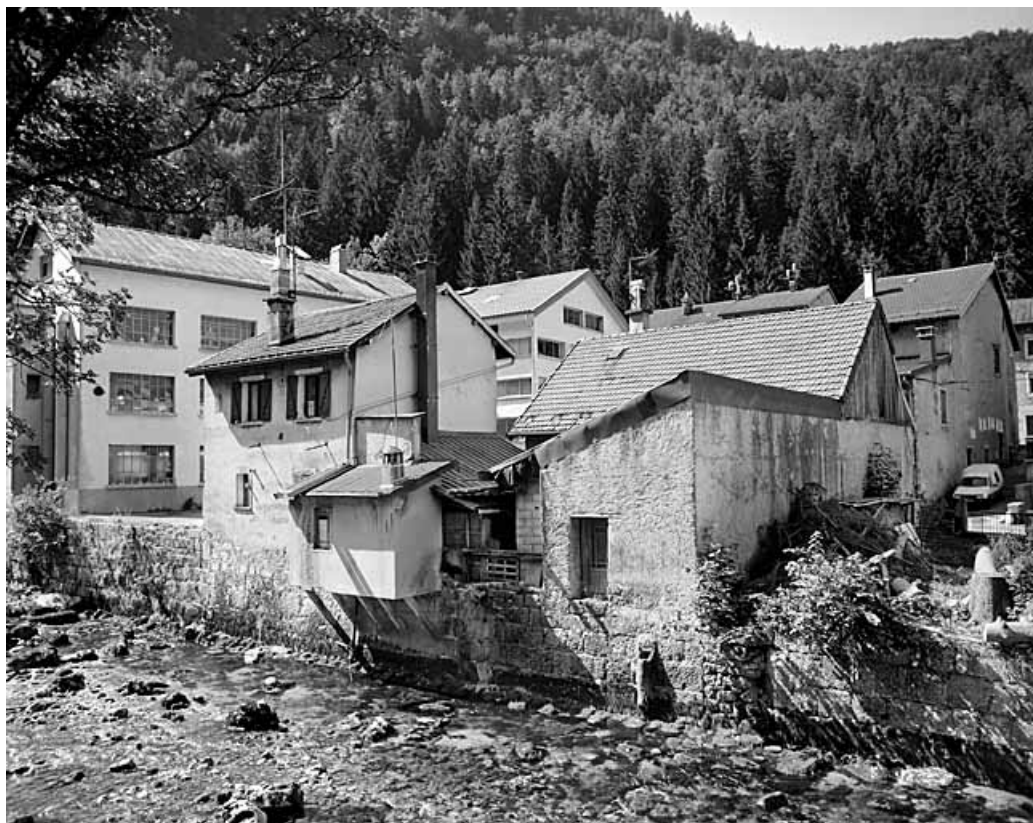
Vue d'ensemble, depuis le nord-est : élévations postérieures.
