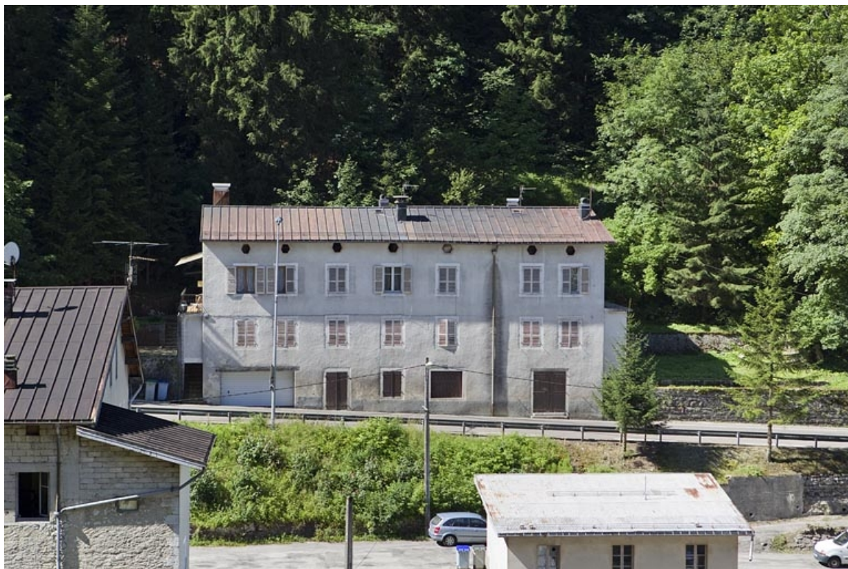
Vue d'ensemble plongeante, depuis le nord-est.
