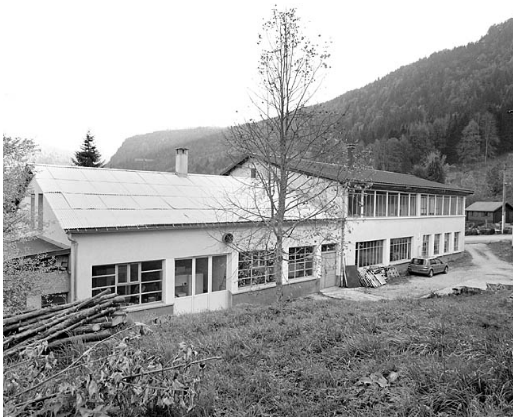
Vue d'ensemble depuis le nord : élévation postérieure.
