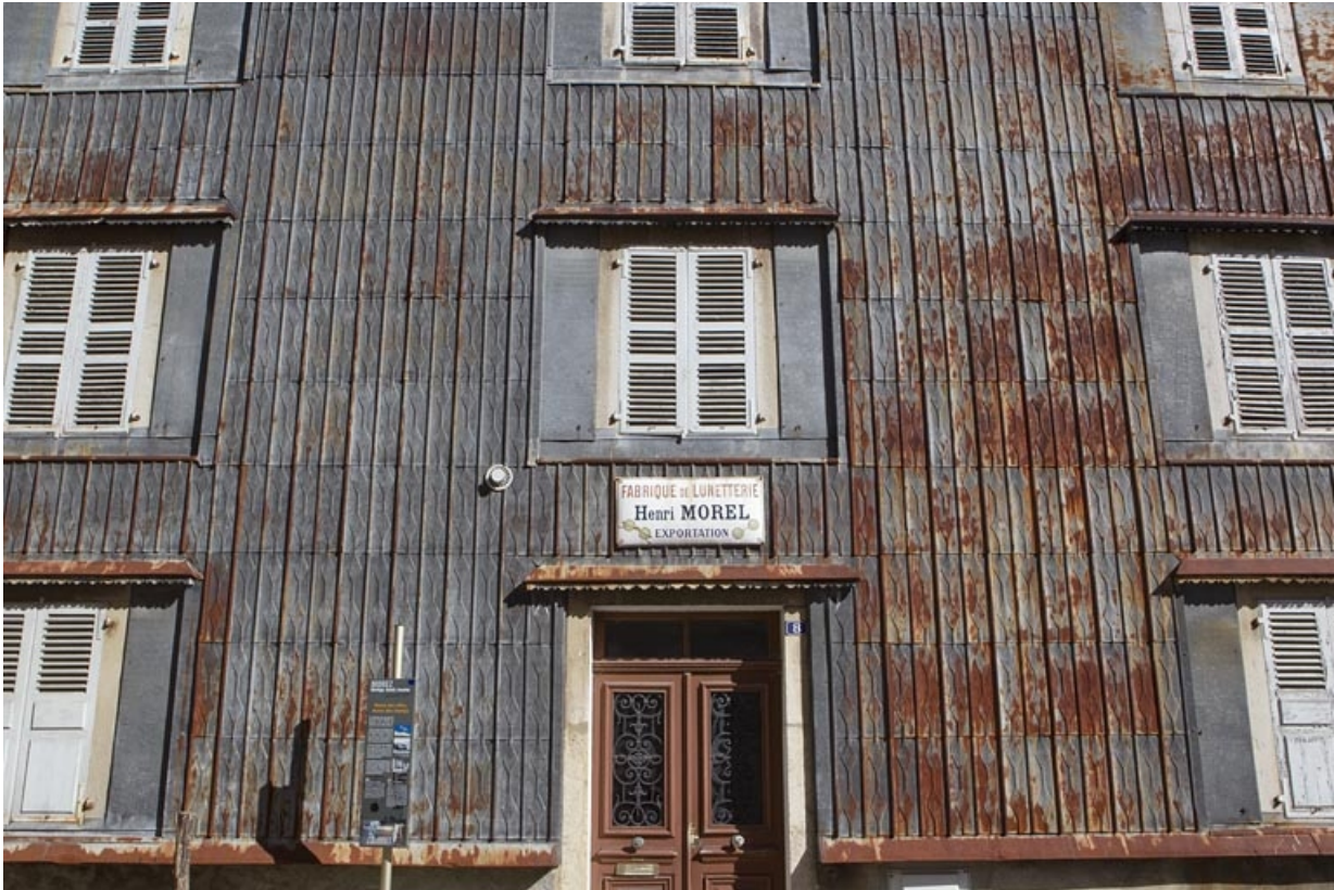
Maison : essentage de tôle sur l'élévation antérieure.
