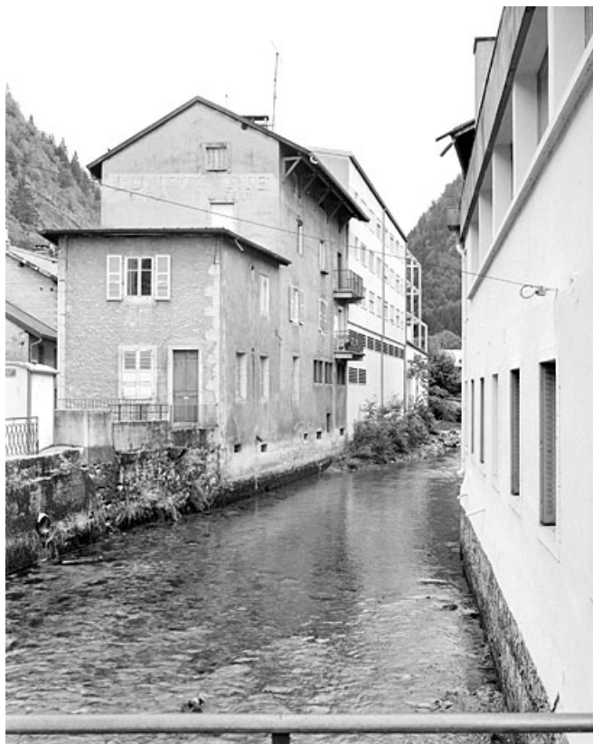
Vue d'ensemble depuis le nord-ouest : façades sur Bienne.
