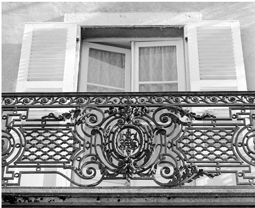
Balcon du premier étage : détail du garde-corps.
