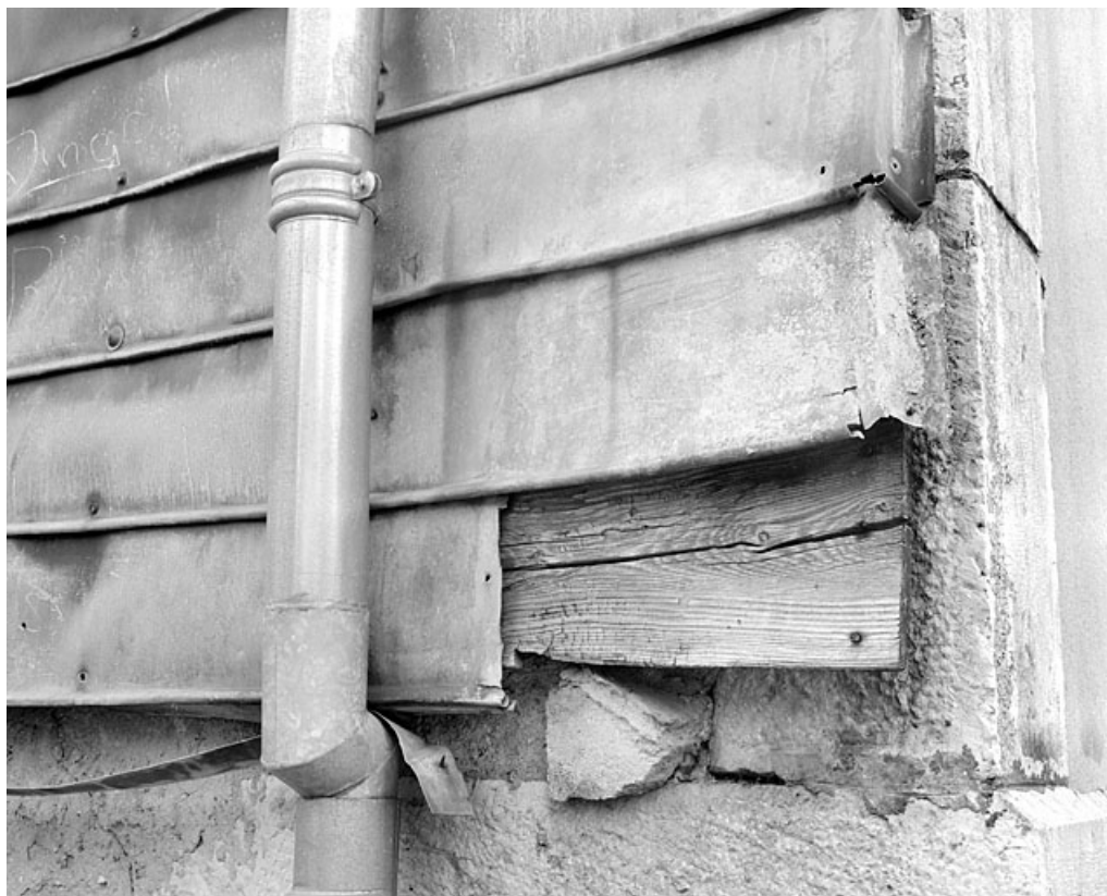
Essentage de tôle sur le mur sud : détail.
