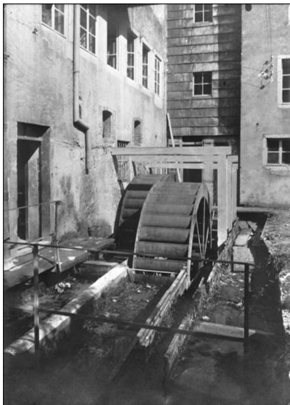
[Roues hydrauliques verticales côté cour], 2e moitié 20e siècle.
