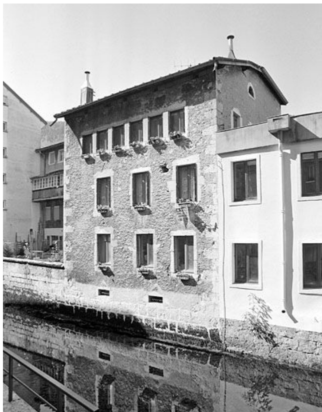
Bâtiment au n° 19, vu de l'est (façade sur la Bienne).
