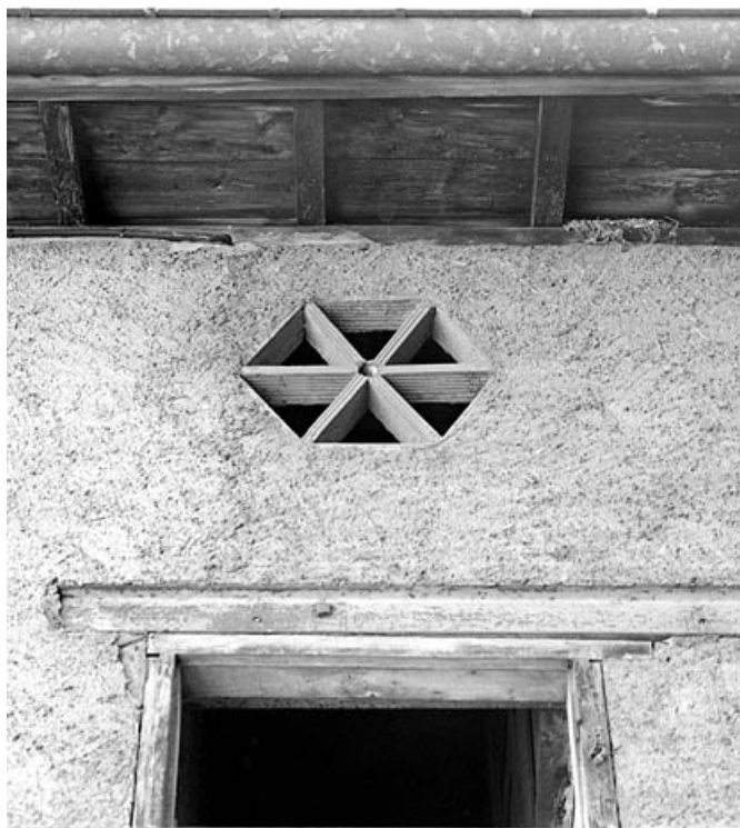
Bâtiment en fond de cour : oculus hexagonal.
