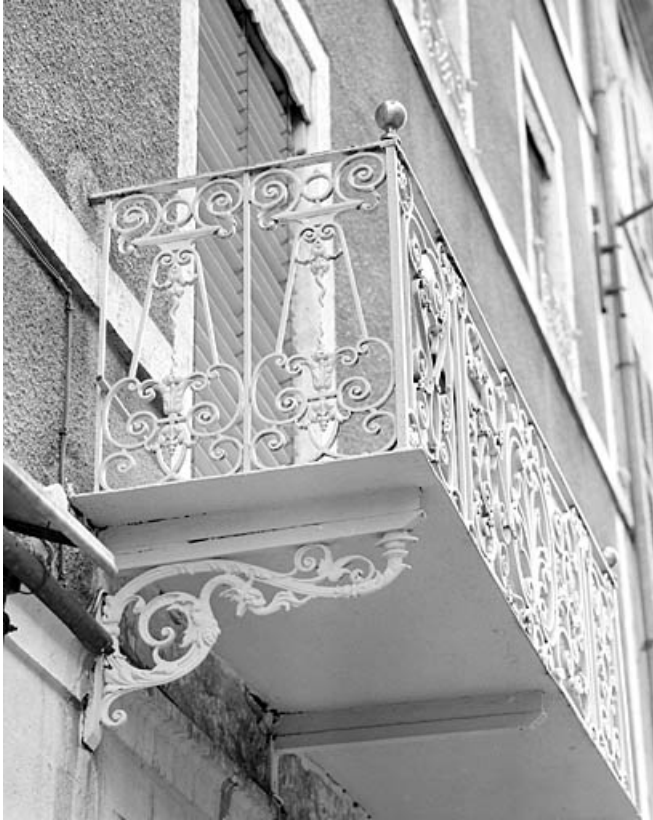
Balcon du premier étage : garde-corps et console.
