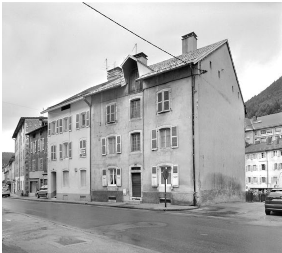
Maisons (18e siècle) aux n° 177 et 179 rue de la République.
