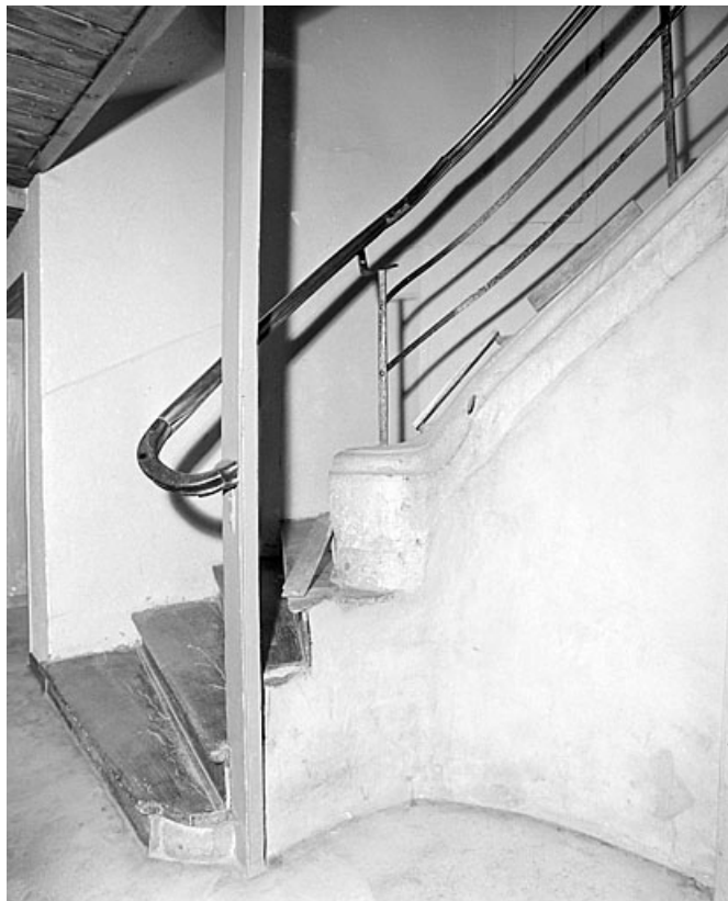
Escalier tournant : première volée.
