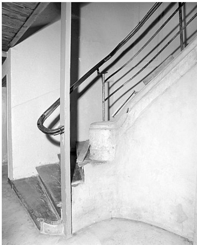
Escalier tournant : première volée.
