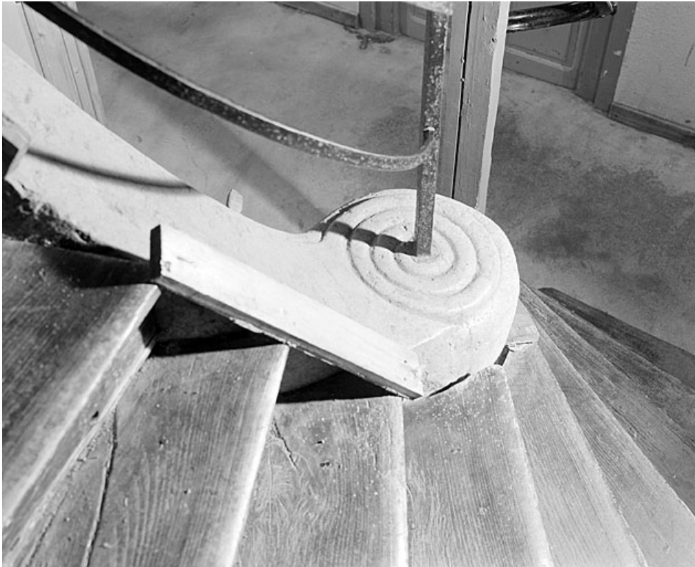
Escalier tournant : départ de la rampe d'appui.
