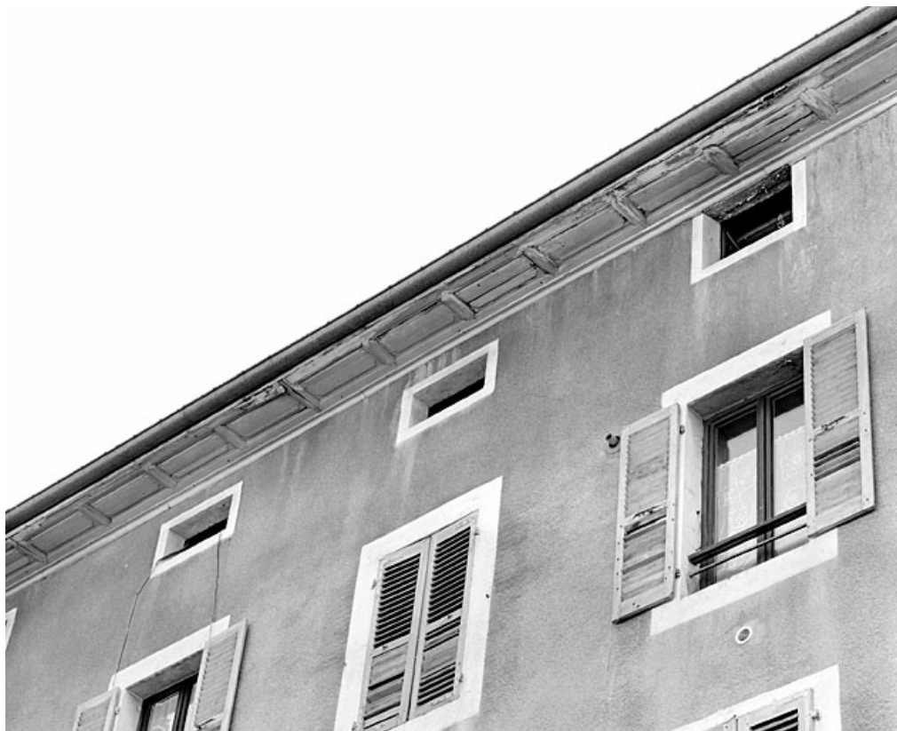
Élévation antérieure : corniche et fenêtres du comble à surcroît.
