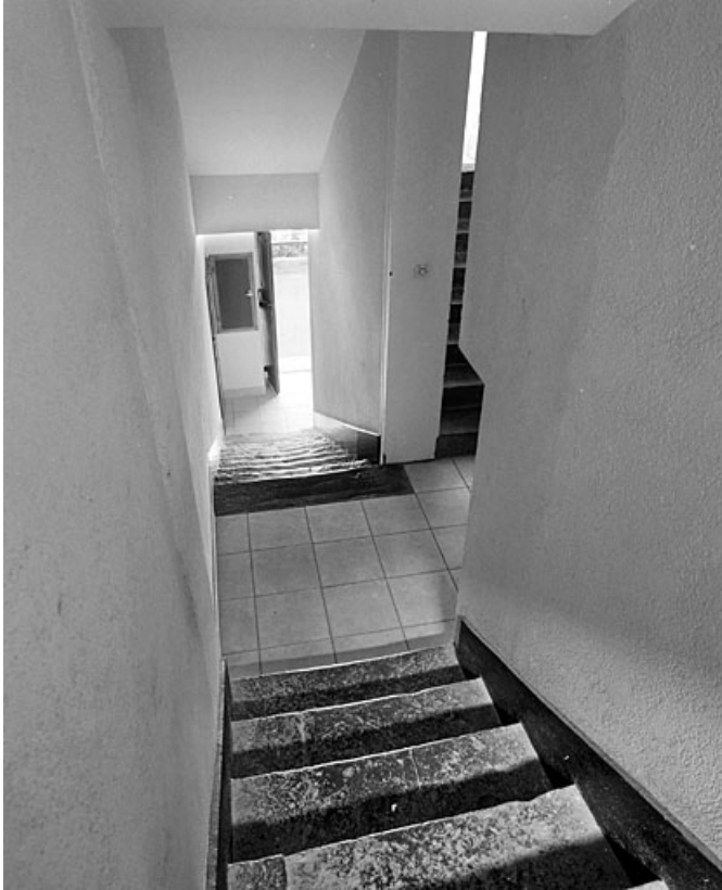
Maison au n° 32 : escalier.
