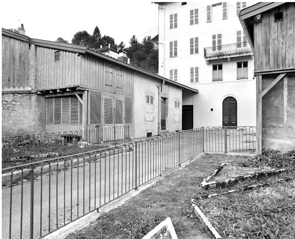
Jardin, cour et bâtiment sud.
