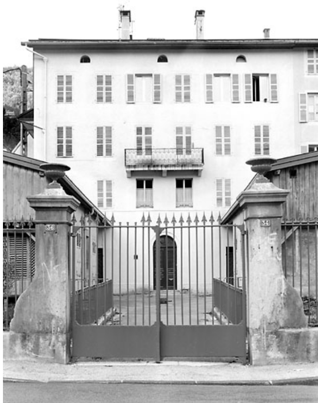
Façade postérieure (vue verticale).
