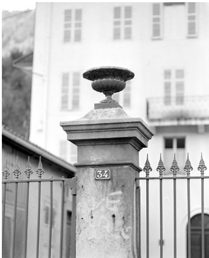
Clôture sur le quai Jobez : pilier droit et vase.
