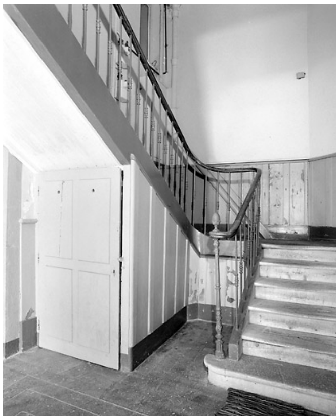
Départ de l'escalier au deuxième étage de soubassement.
