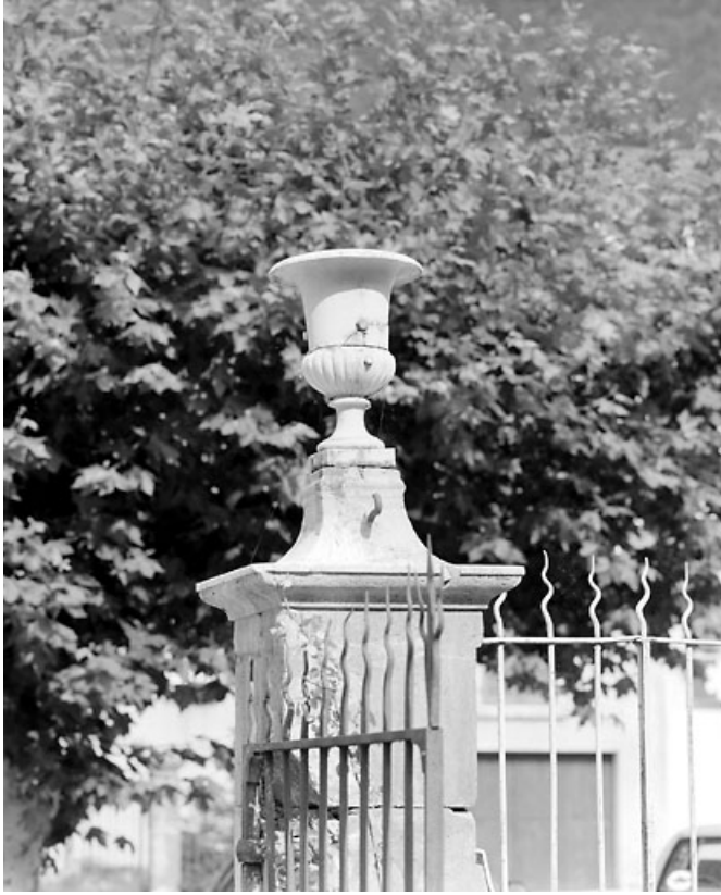
Clôture sur le quai Jobez : un vase.
