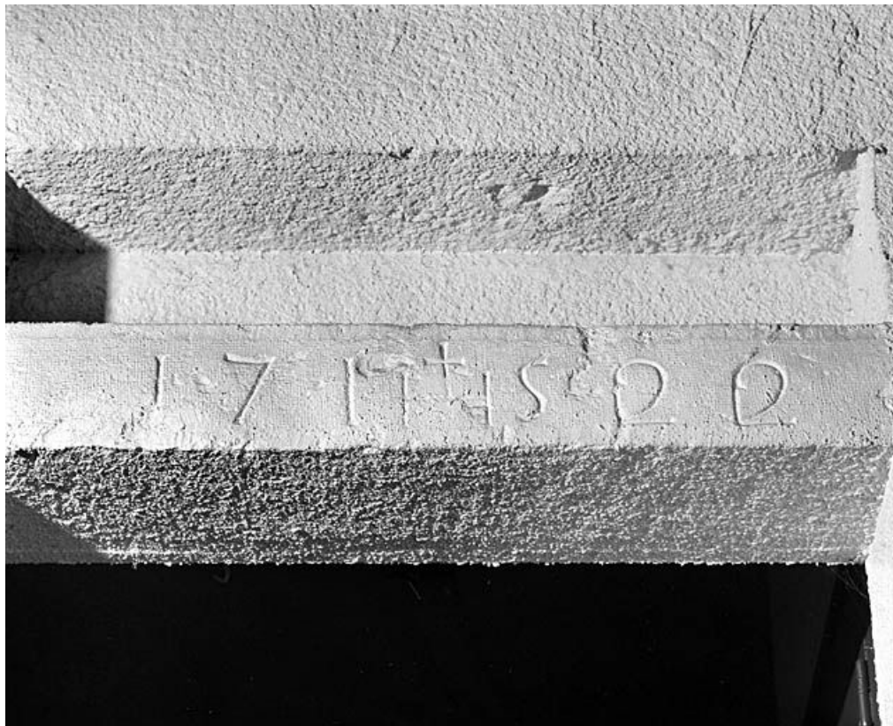
Date sur le linteau d'une porte de l'élévation postérieure.
