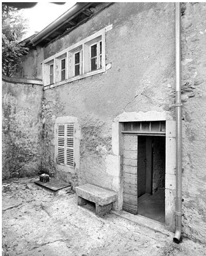
Façade postérieure du bâtiment oriental.
