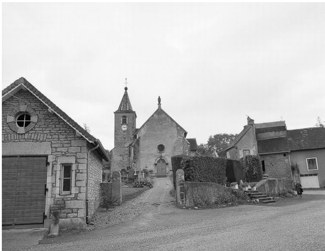
Façade antérieure depuis l'entrée du cimetière.
