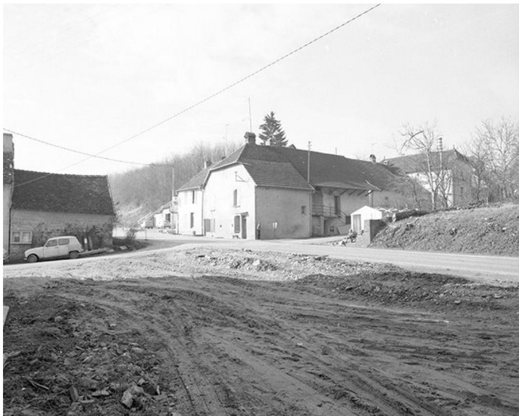
Lieudit Montchauvrot : vue prise au cours des travaux routiers de l'hiver 1974-1975. 39, Mantry
