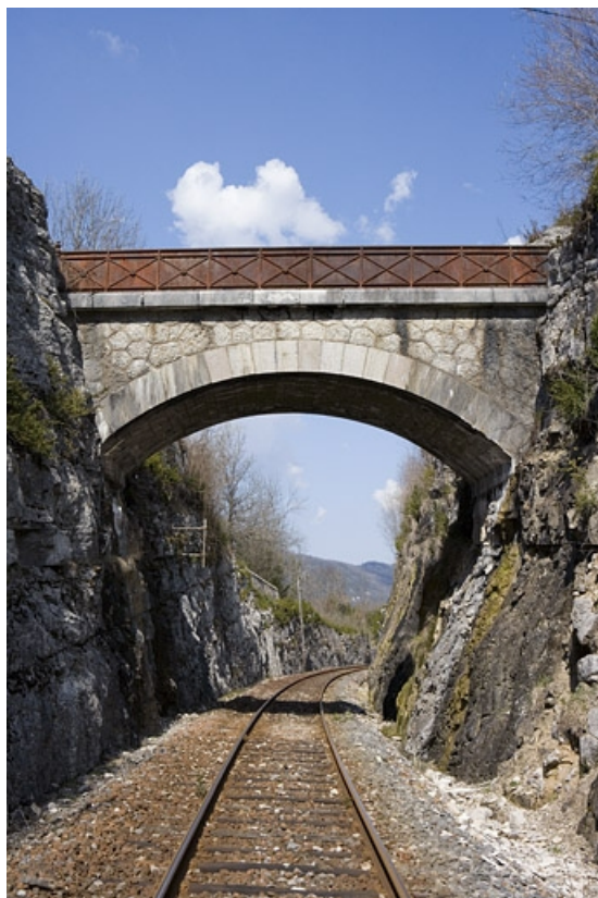
Vue d'ensemble, depuis la voie côté La Cluse (sud). 39, Lavancia-Epercy V.C. 4, lieudit : sur le Rognon
