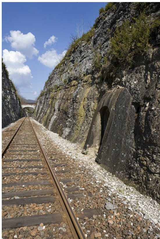
Vue d'ensemble de la tranchée, depuis le côté La Cluse (sud). A droite le cinquième abri. 39, Lavancia-Epercy, lieudit : au Champ du Ligneux
