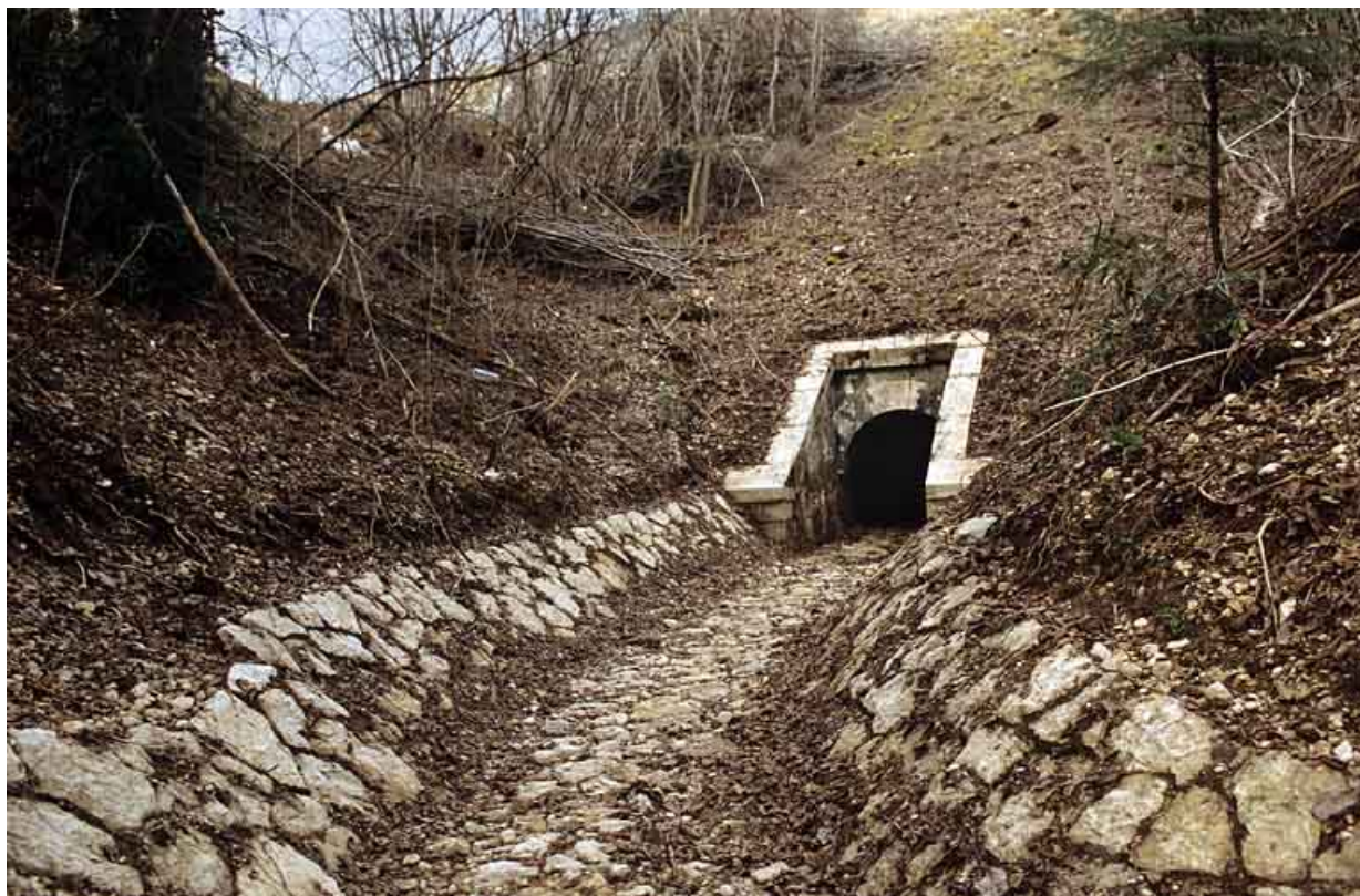
Aqueduc : tête aval et rigole (cadrage horizontal).
