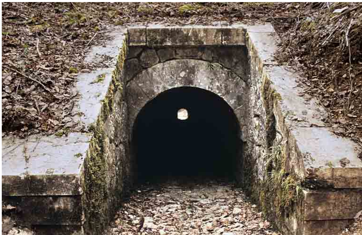
Aqueduc : tête amont (est).
