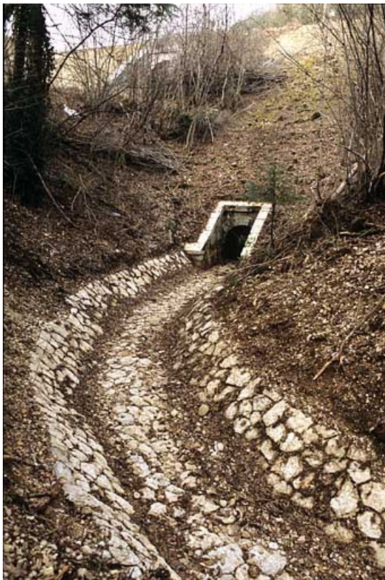
Aqueduc : tête aval (ouest) et rigole.
