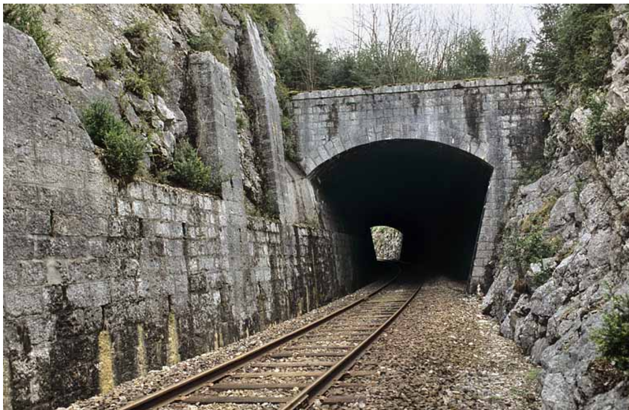
Tête côté Andelot-en-Montagne (nord). 39, Lavancia-Epercy, lieudit : la Brasselette
