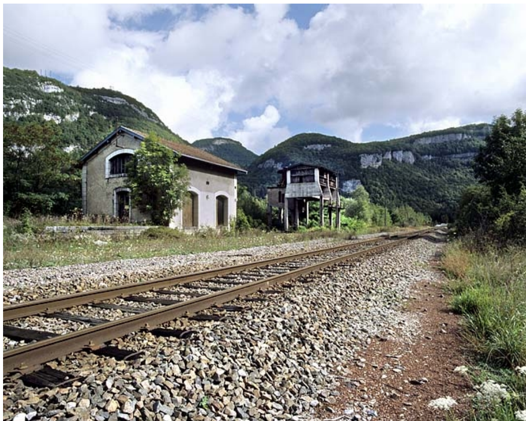
Entrepôt et silo à sciure, depuis la voie côté La Cluse (sud-ouest).
