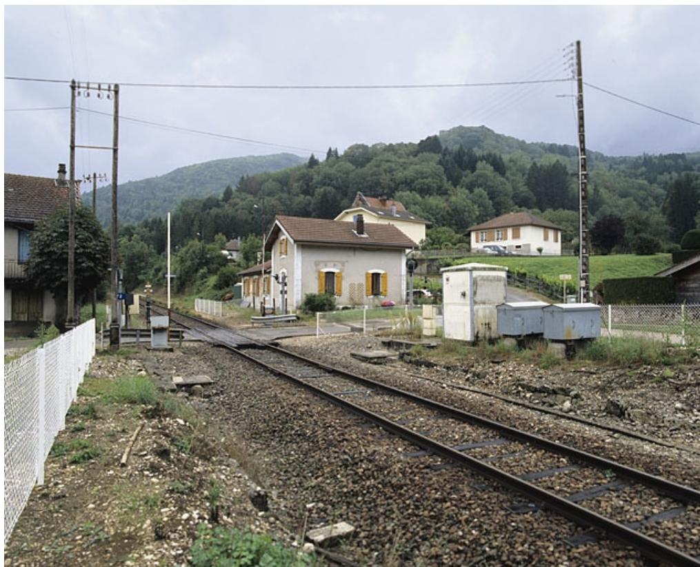
Vue d'ensemble, depuis la voie côté La Cluse (nord-ouest).
