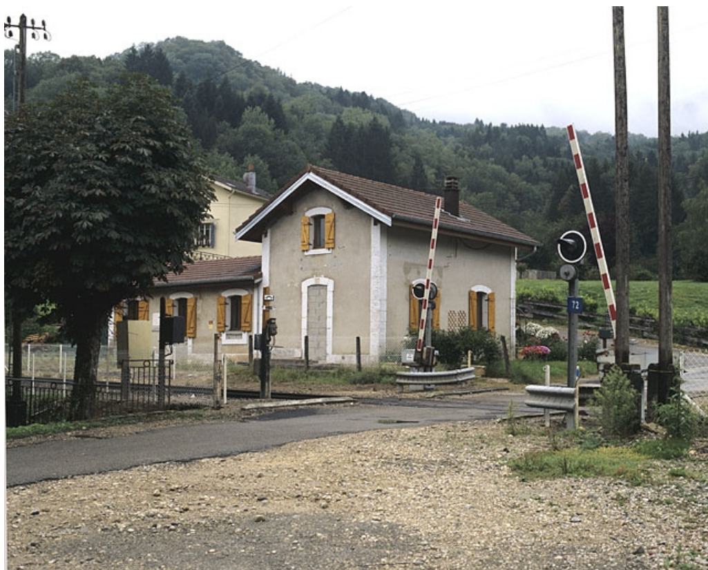
Façade est (côté voie), de trois quarts droite.
