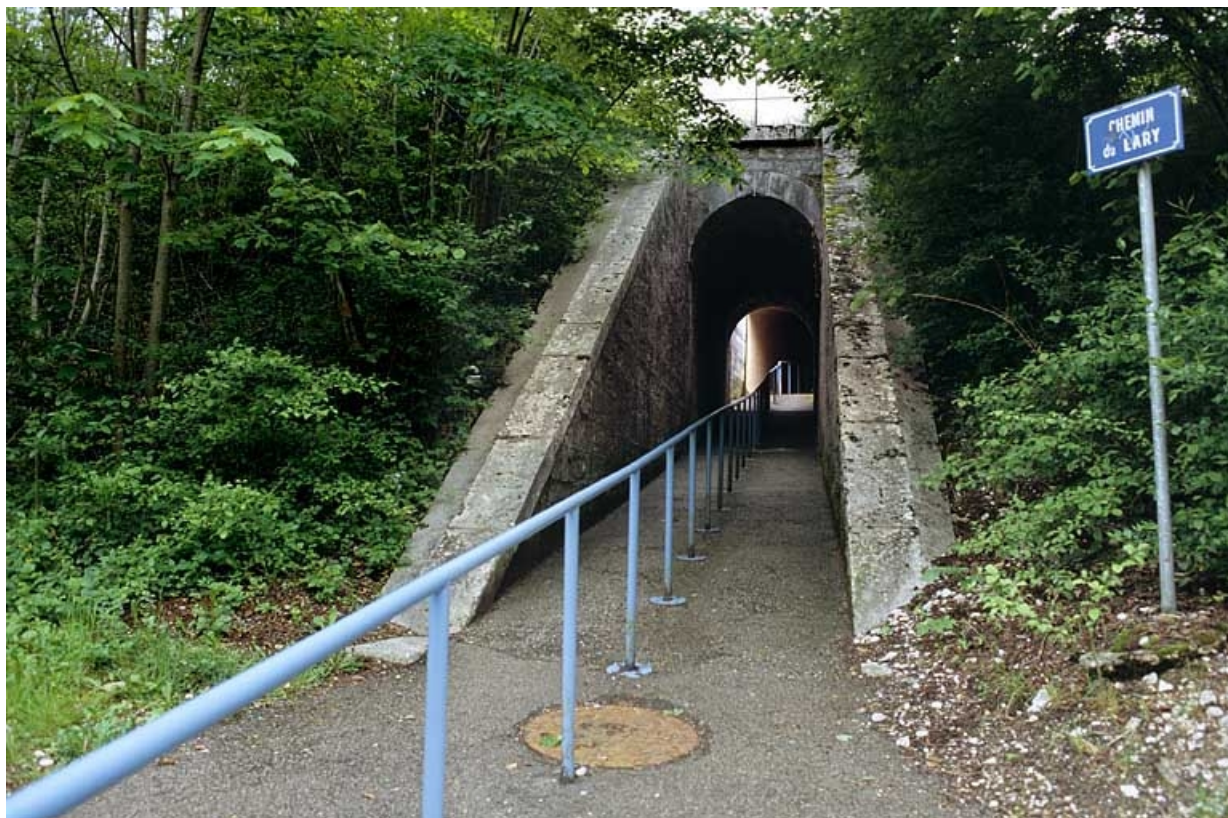
Vue d'ensemble de la tête aval (nord). 39, Molinges chemin du Lary
