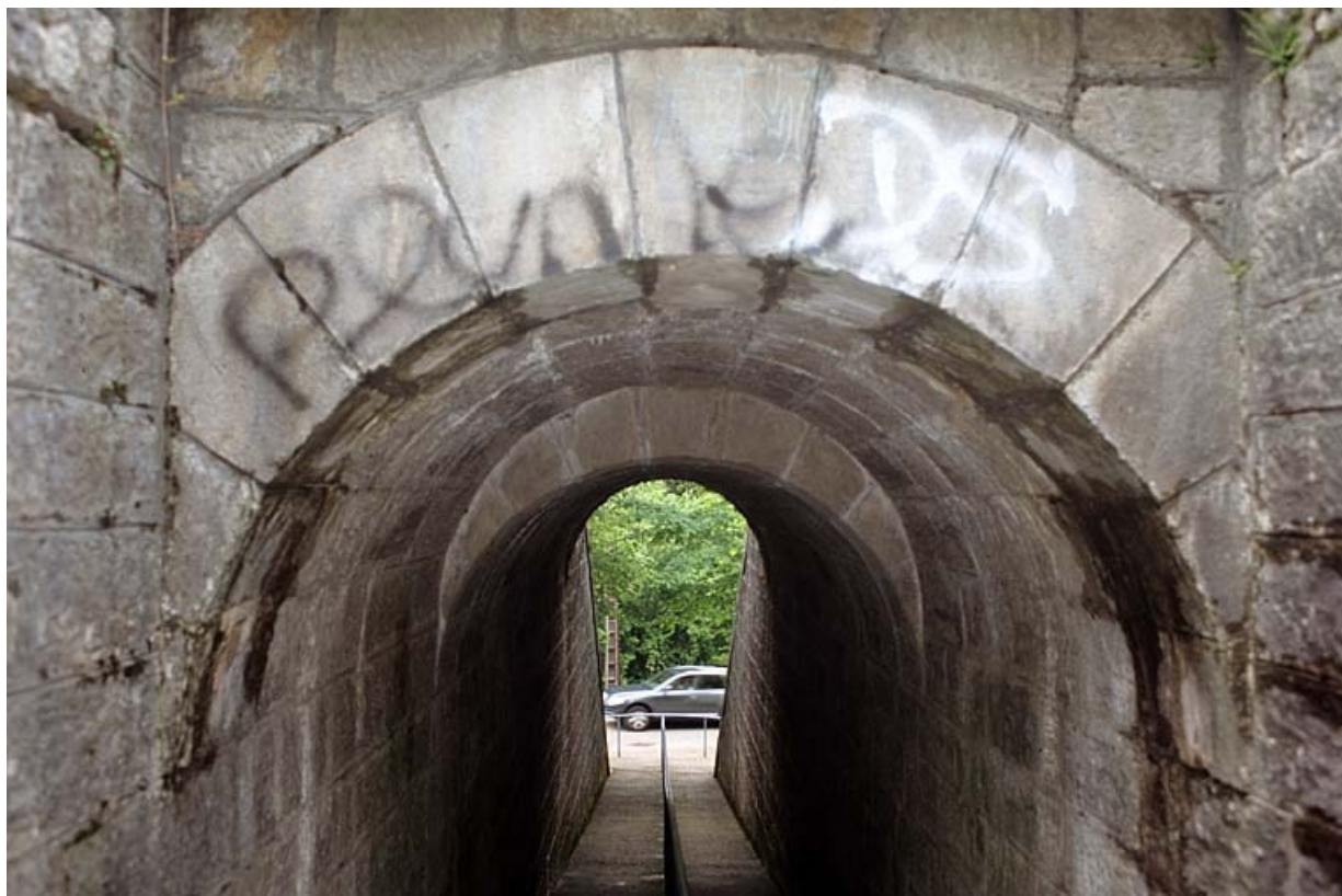
Voûte appareillée en rouleaux à ressauts, depuis l'amont (sud). 39, Molinges chemin du Lary
