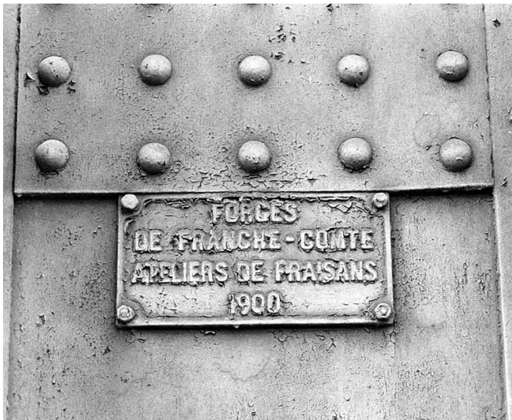
Plaque du constructeur et date. Cette plaque est fixée sur le pont, côté La Cluse. 39, Chassal, lieudit : en Risoux
