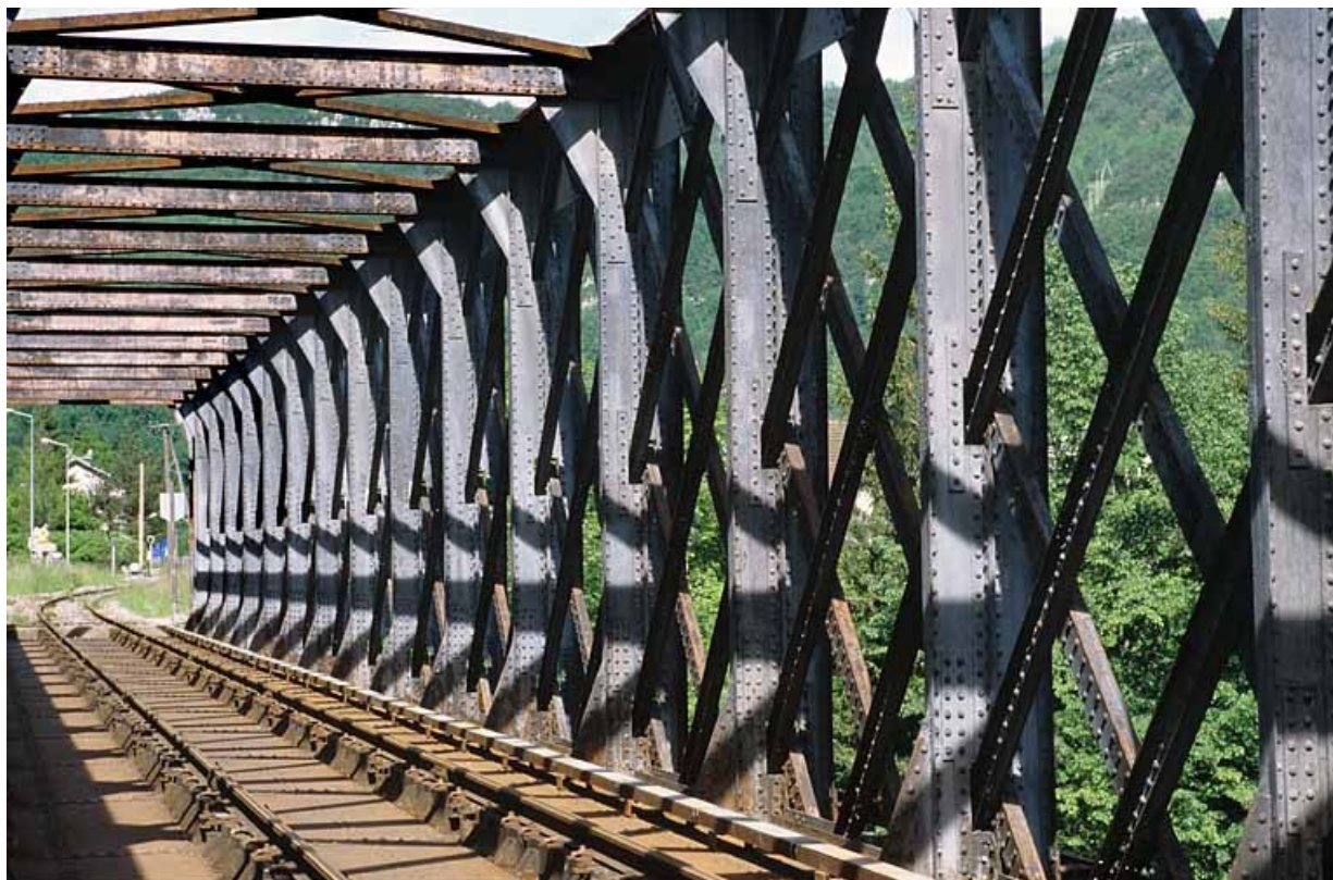
Paroi aval, depuis le tablier côté Andelot-en-Montagne.
