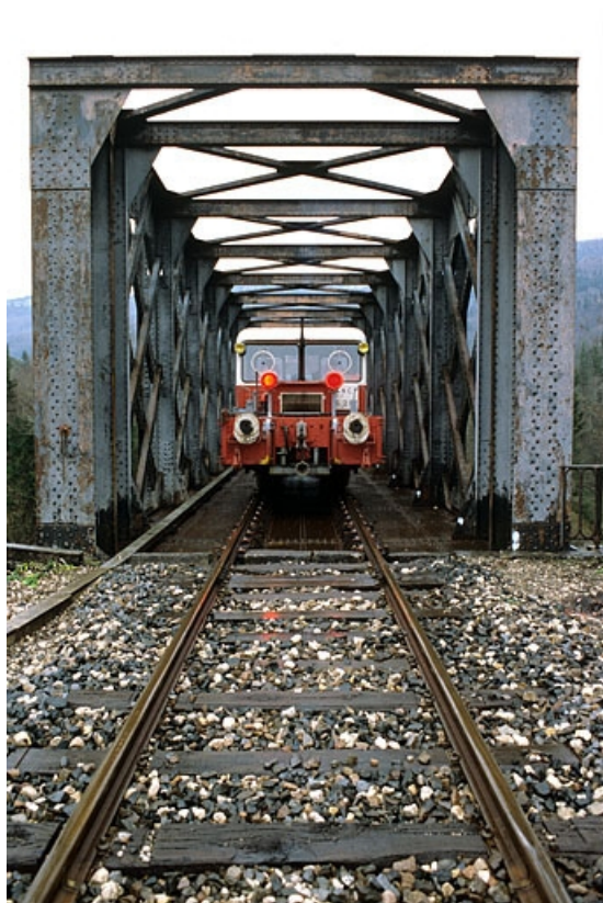
Extrémité côté La Cluse, avec draisine.
