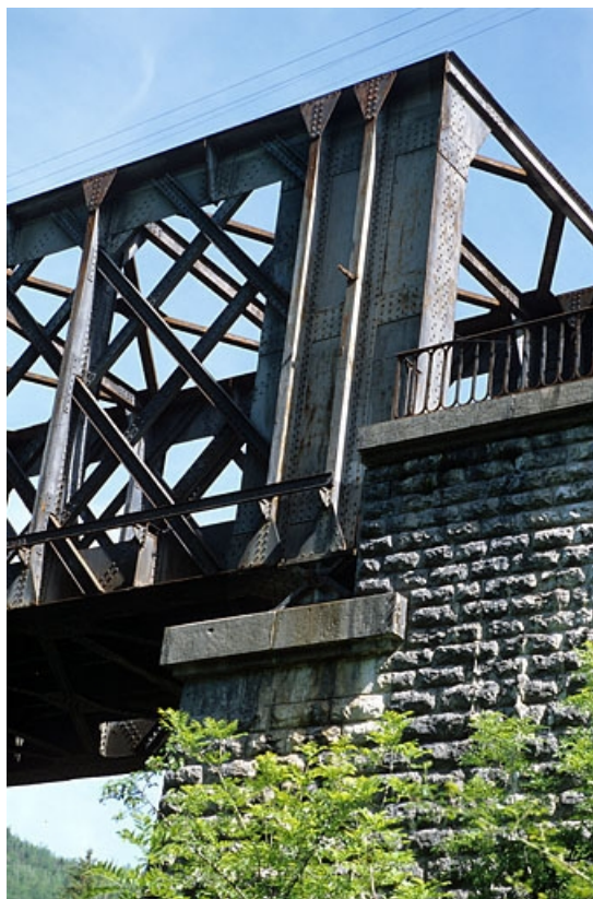
Extrémité côté Andelot-en-Montagne et culée, depuis l'amont : détail.
