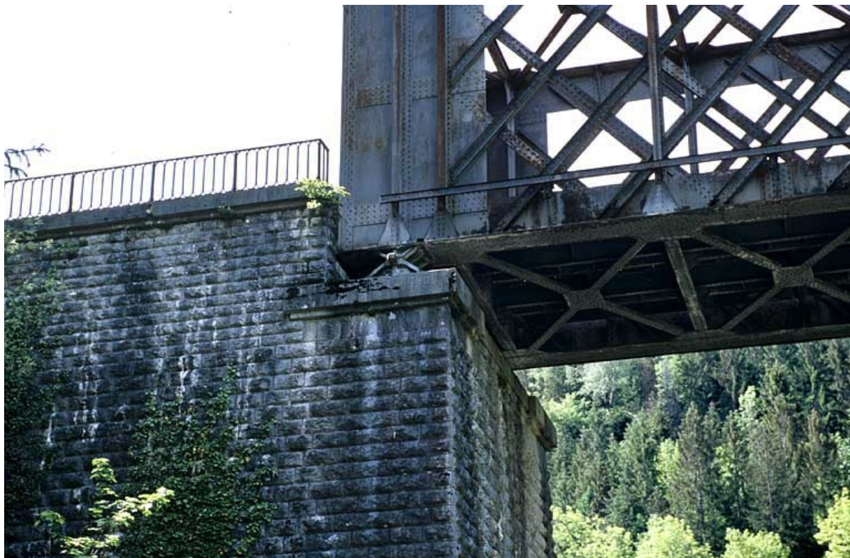
Extrémité côté La Cluse et culée, depuis l'amont : détail montrant l'appui fixe.
