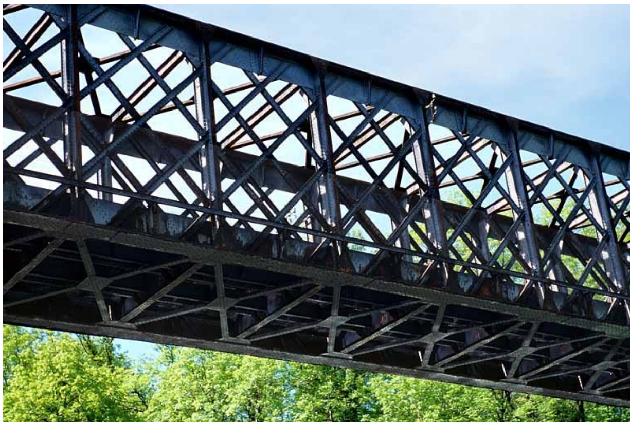
Partie inférieure du tablier et poutre latérale, côté amont.
