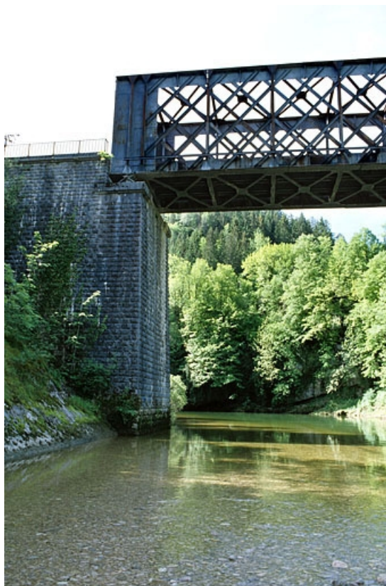
Extrémité côté La Cluse et culée, depuis l'amont.
