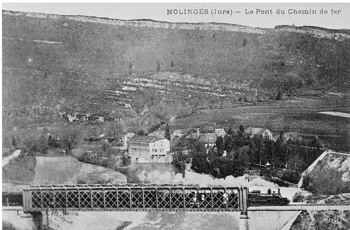
Molinges (Jura) - Le Pont du Chemin de fer, 1ère moitié 20e siècle.
