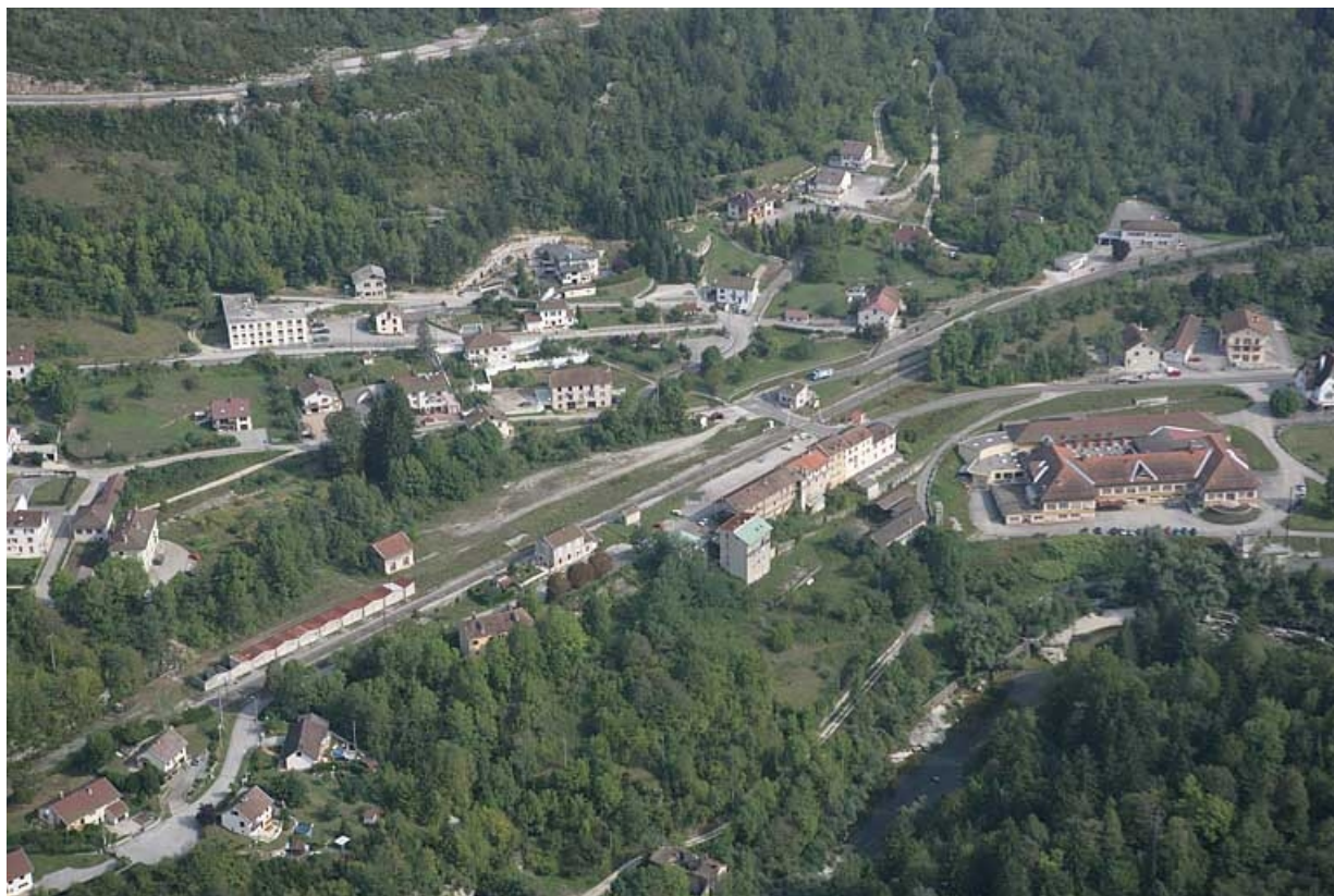
Vue aérienne du quartier de la gare, depuis le sud.
