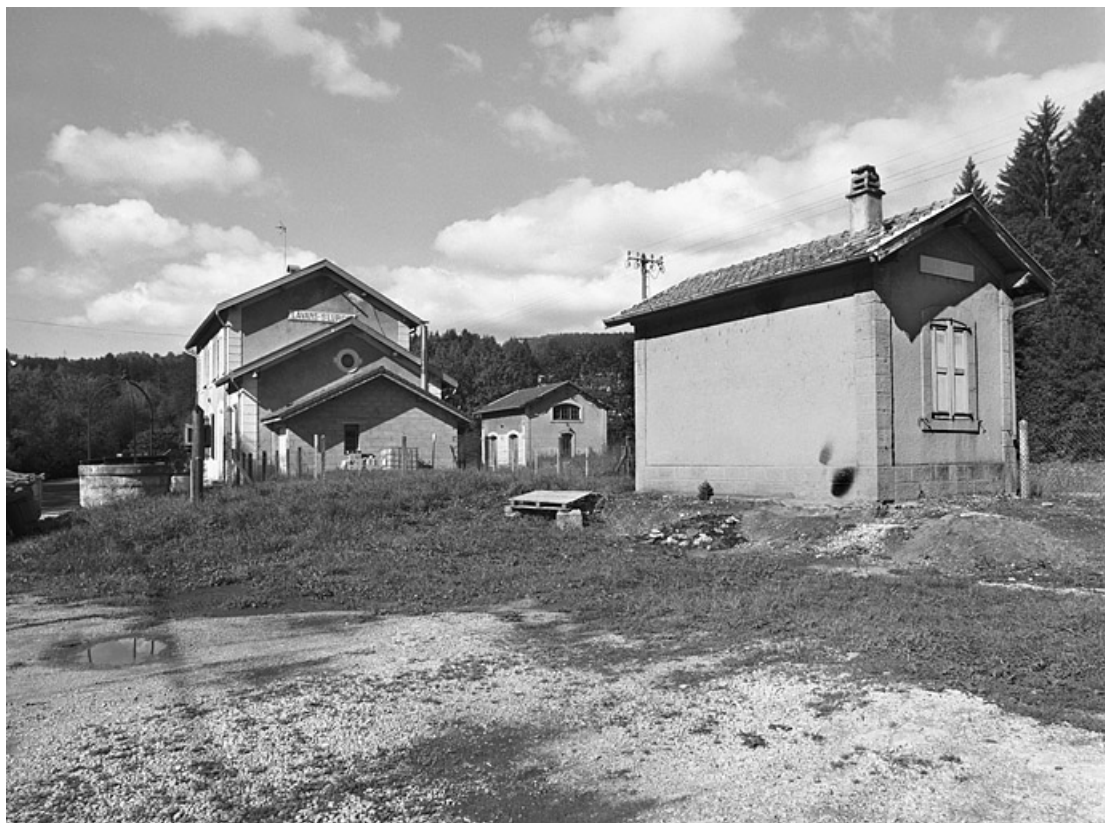
Vue d'ensemble des bâtiments, depuis le sud-est.
