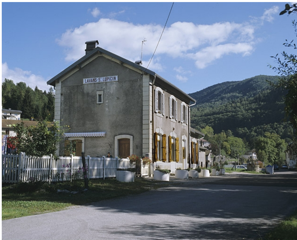
Bâtiment des voyageurs : façade antérieure, de trois quarts gauche.
