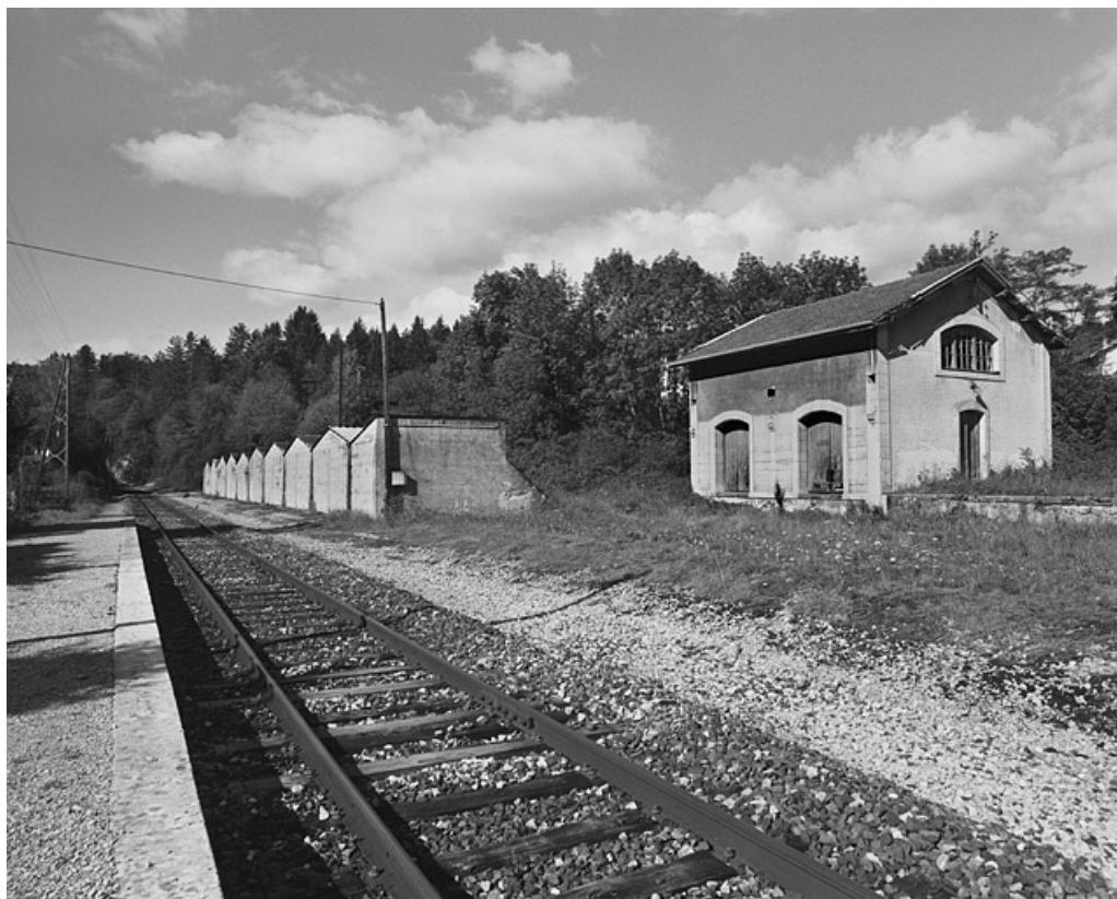
Entrepôts commerciaux : vue d'ensemble, depuis le bâtiment des voyageurs.
