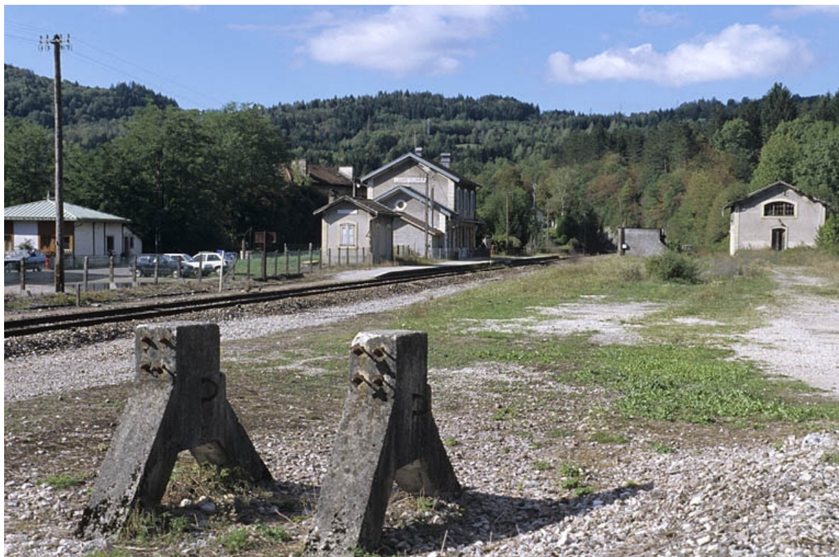
Vue d'ensemble, depuis le côté Andelot-en-Montagne (est).
