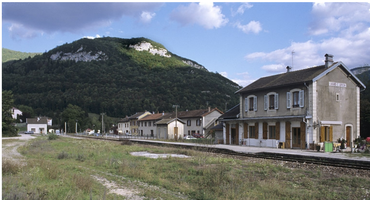
Vue d'ensemble du bâtiment des voyageurs et du " magasin ", depuis le côté La Cluse (ouest). 39, Lavans-lès-Saint-Claude, 28 quartier de Lizon, lieudit : Lizon
