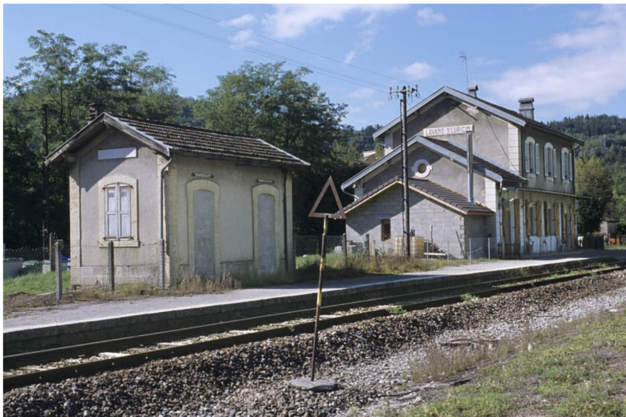
Bâtiment des voyageurs et " magasin " : façade postérieure, de trois quarts gauche.
