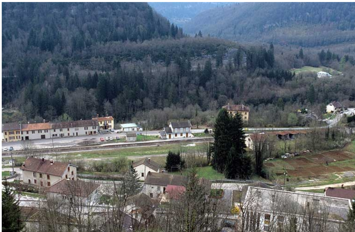
Vue d'ensemble plongeante sur la gare, depuis le nord. 39, Lavans-lès-Saint-Claude, 28 quartier de Lizon, lieudit : Lizon
