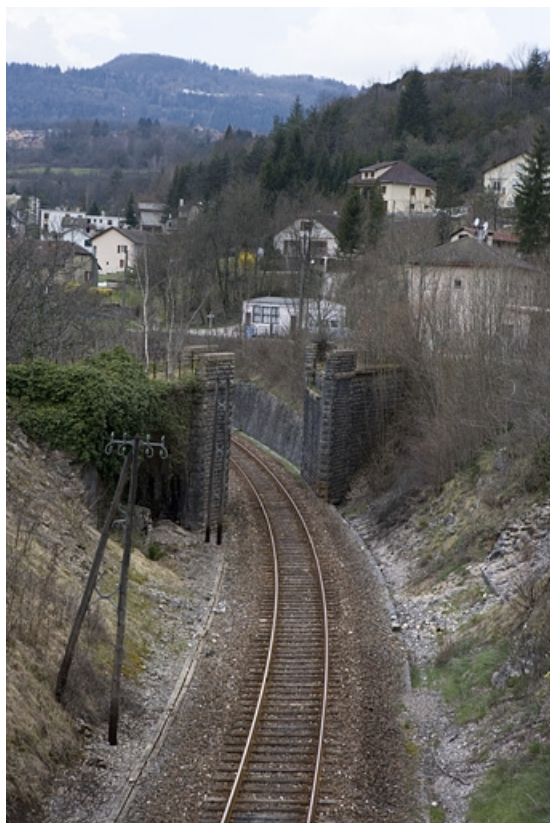
Pont du tacot : vue d'ensemble plongeante, depuis le côté Andelot-en-Montagne (est). 39, Lavans-lès-Saint-Claude R.D. 470, lieudit : Lizon
