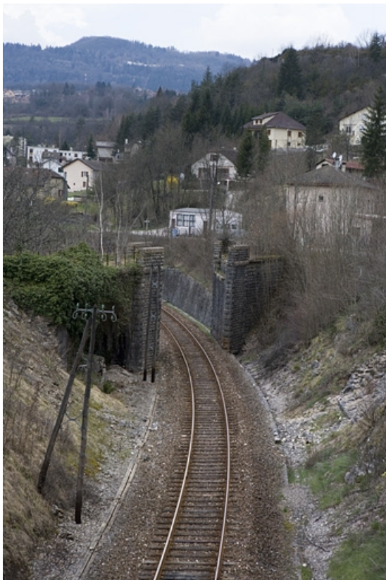
Pont du tacot : vue d'ensemble plongeante, depuis le côté Andelot-en-Montagne (est). 39, Lavans-lès-Saint-Claude R.D. 470, lieudit : Lizon
