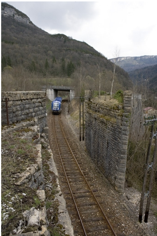
Pont du tacot et pont routier, depuis le côté La Cluse (ouest), avec autorail X 73500. 39, Lavans-lès-Saint-Claude R.D. 470, lieudit : Lizon
