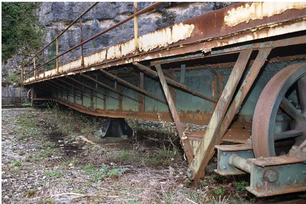
Tablier vu en enfilade.
