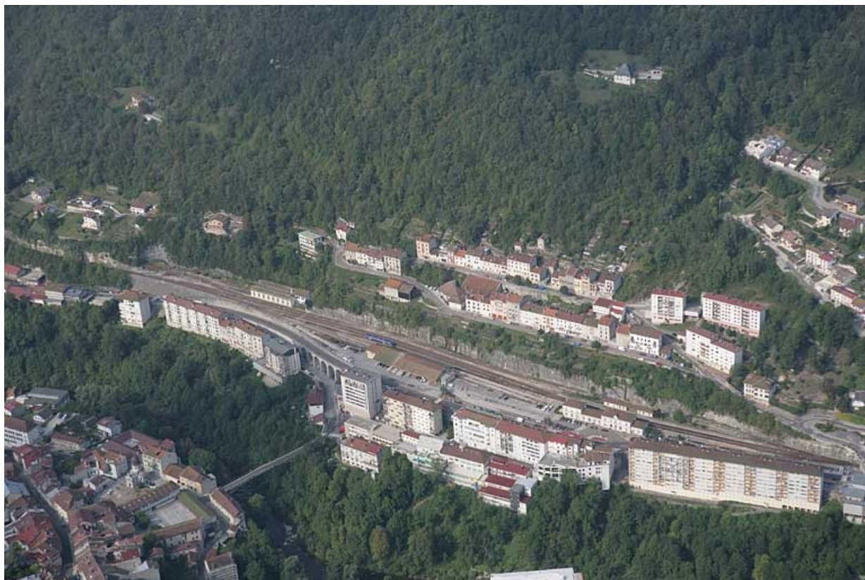
Vue aérienne, depuis le nord-est.
