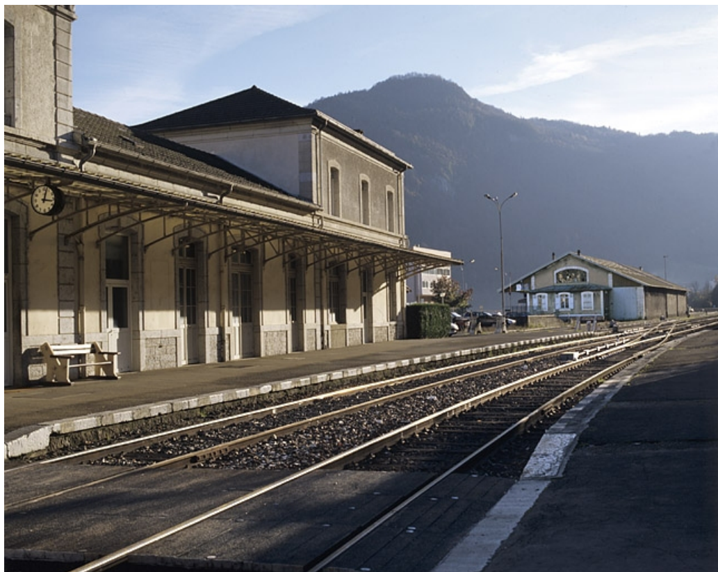
Bâtiment des voyageurs, quais et entrepôt, depuis l'abri-lampisterie. 39, Saint-Claude place de la Gare
