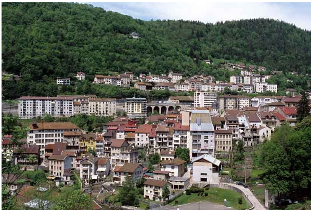
Vue d'ensemble du quartier de la gare, depuis le sud-est.
