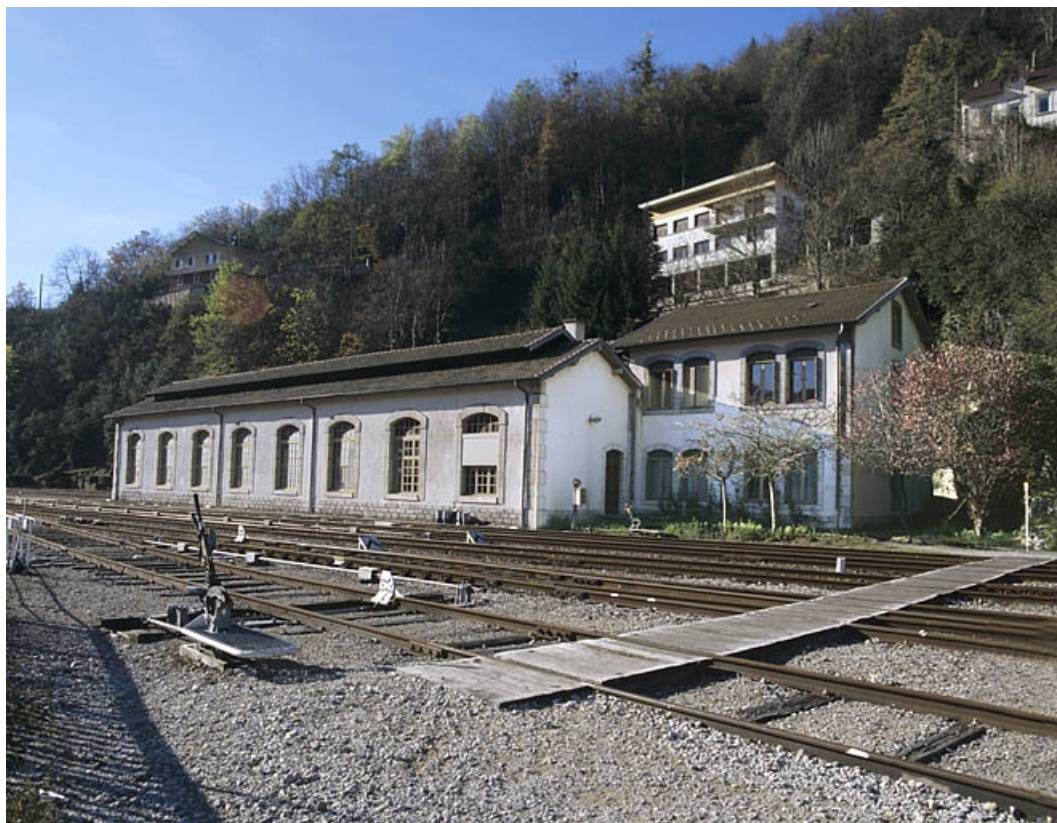
Foyer des roulants et remise ferroviaire : vue d'ensemble, depuis le nord-est. 39, Saint-Claude place de la Gare
