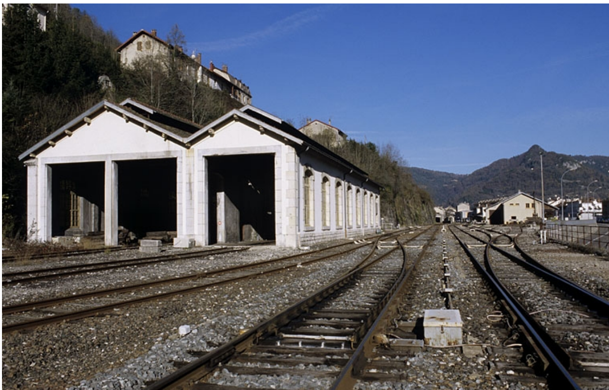
Remise ferroviaire : vue d'ensemble, depuis le sud.
