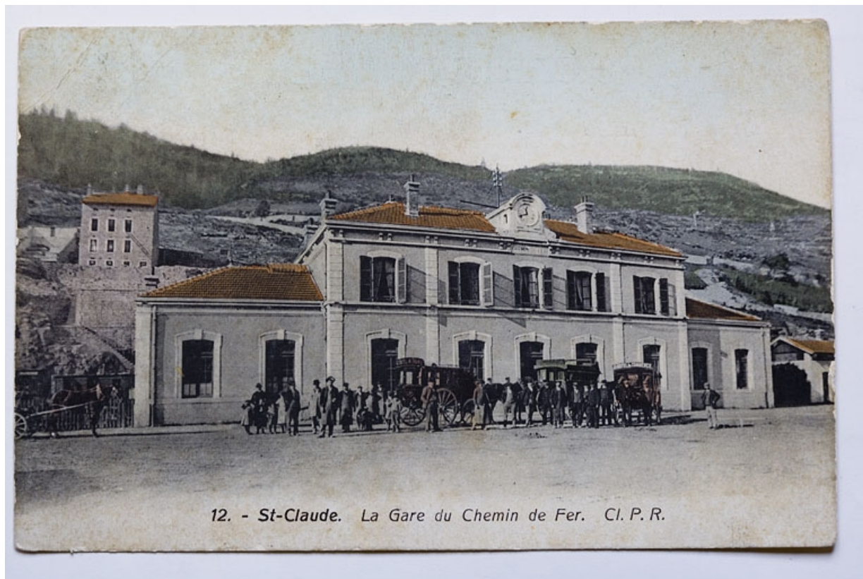
12. - St-Claude. La Gare du Chemin de Fer, limite 19e siècle 20e siècle. 39, Saint-Claude place de la Gare
