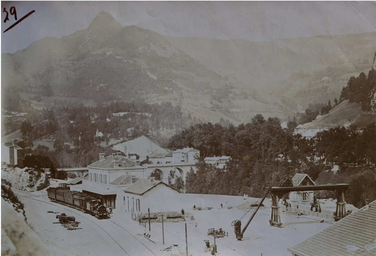
[La gare vue du sud-ouest], 1889 ou 1890. 39, Saint-Claude place de la Gare
