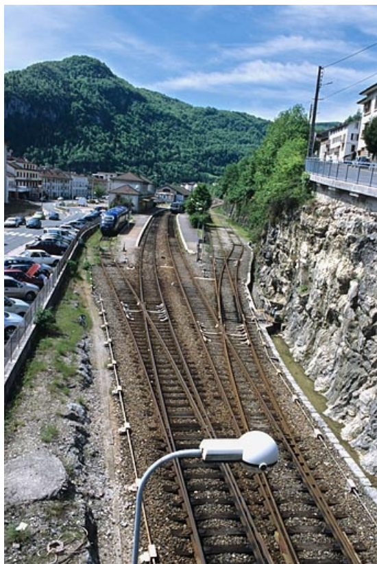
Vue d'ensemble depuis le pont routier, au nord. 39, Saint-Claude place de la Gare
