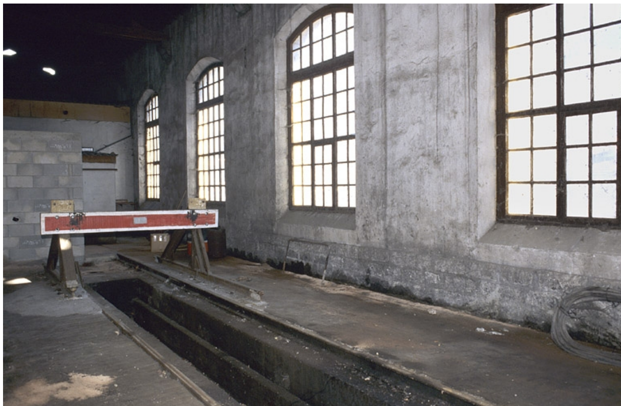
Remise ferroviaire : intérieur de la halle est.
