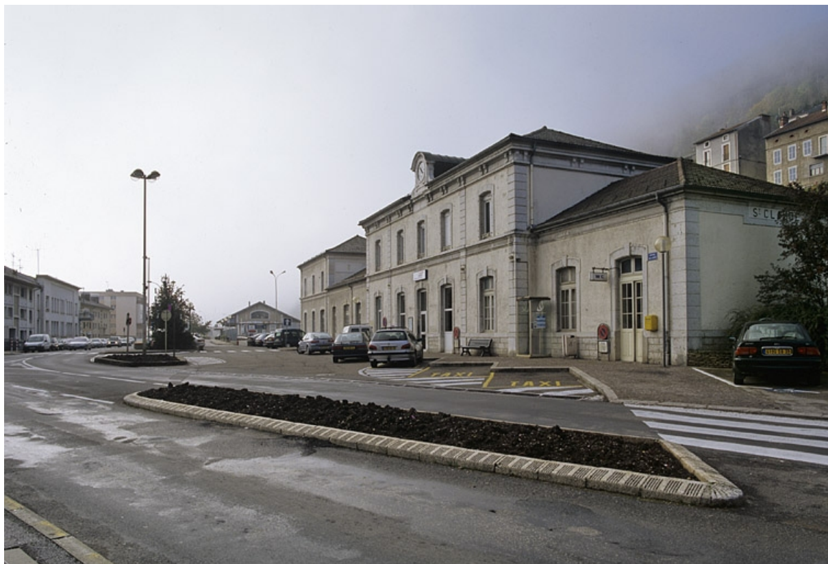
Vue d'ensemble depuis l'avenue de la Gare, au nord.
