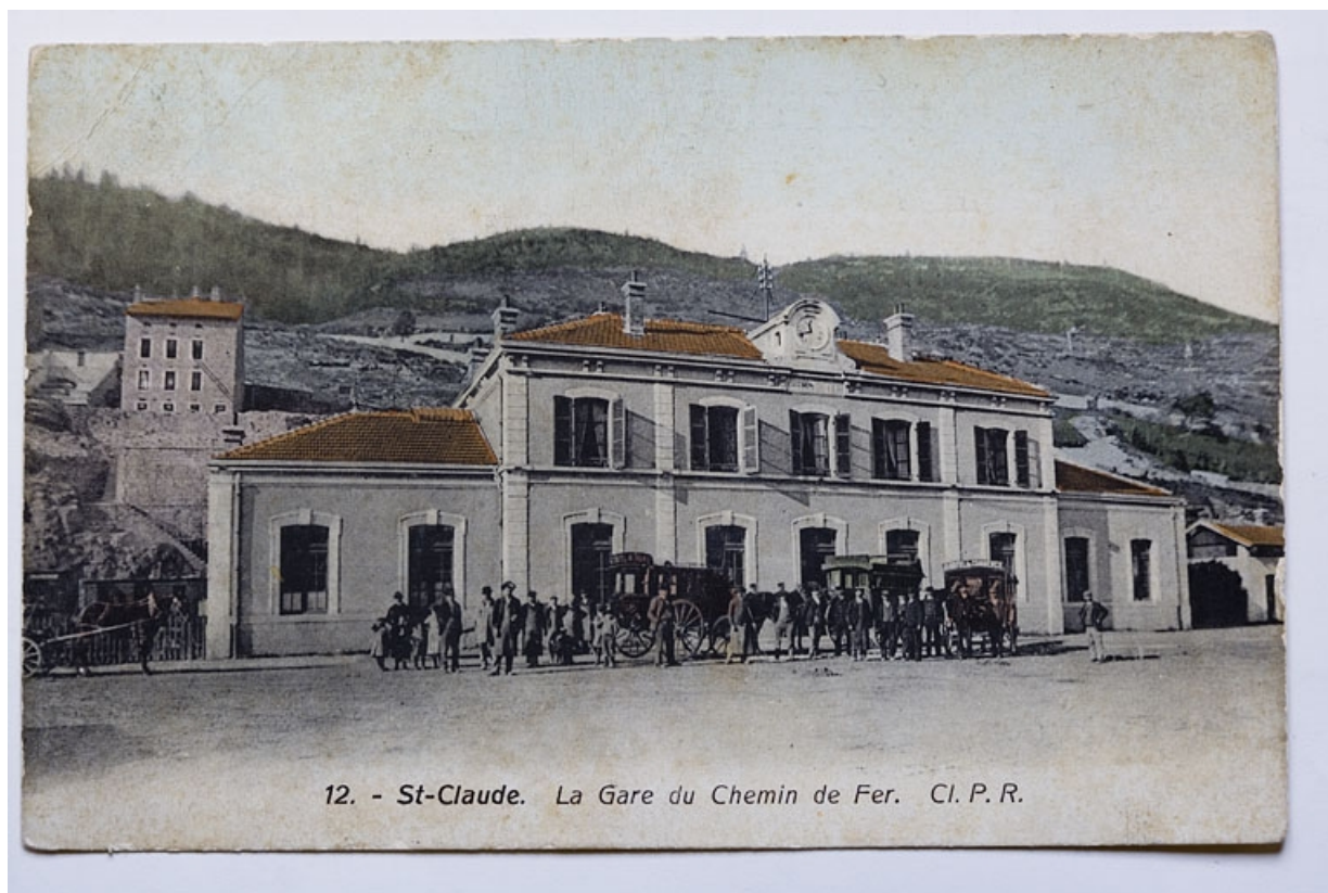
12. - St-Claude. La Gare du Chemin de Fer, limite 19e siècle 20e siècle.
