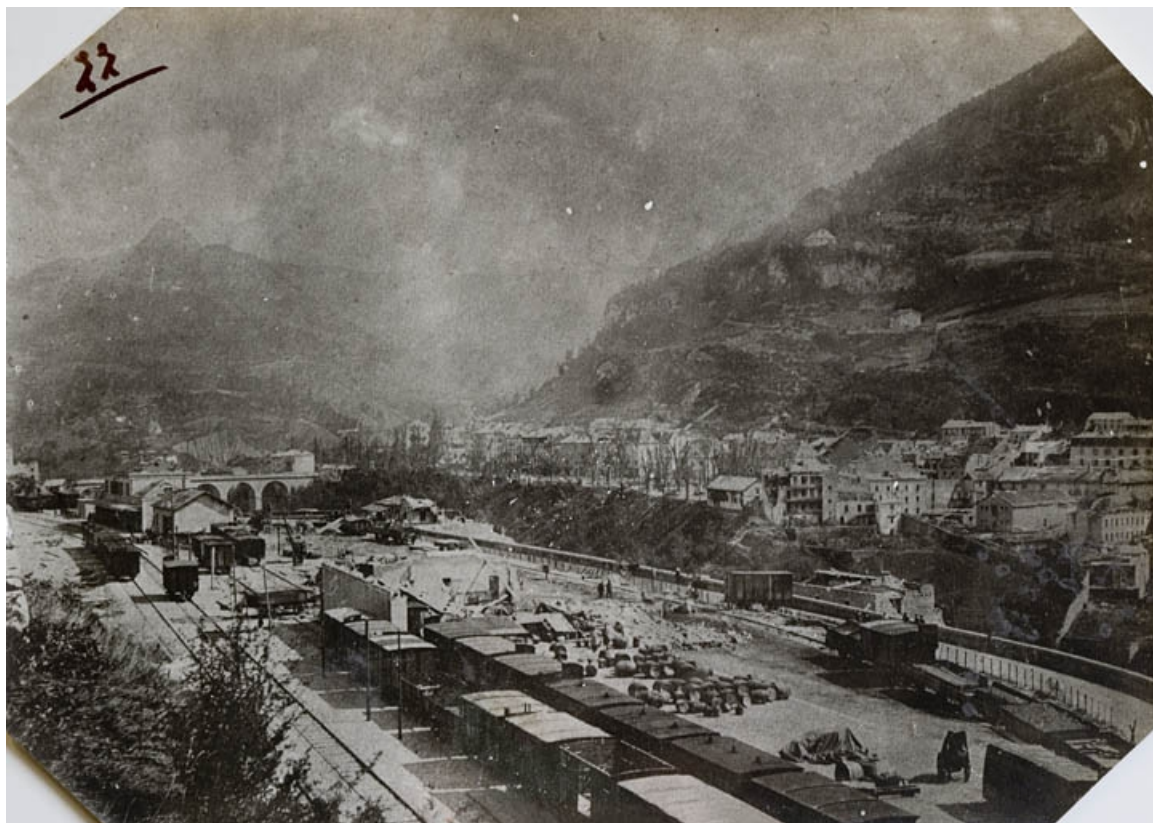
[La gare après le cyclone du 19 août 1890].
