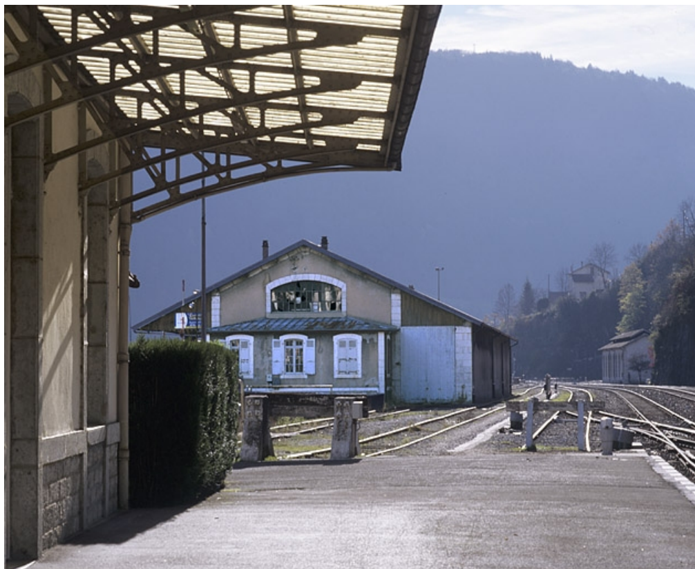
Entrepôt : vue d'ensemble depuis le quai des voyageurs, au nord. 39, Saint-Claude place de la Gare
