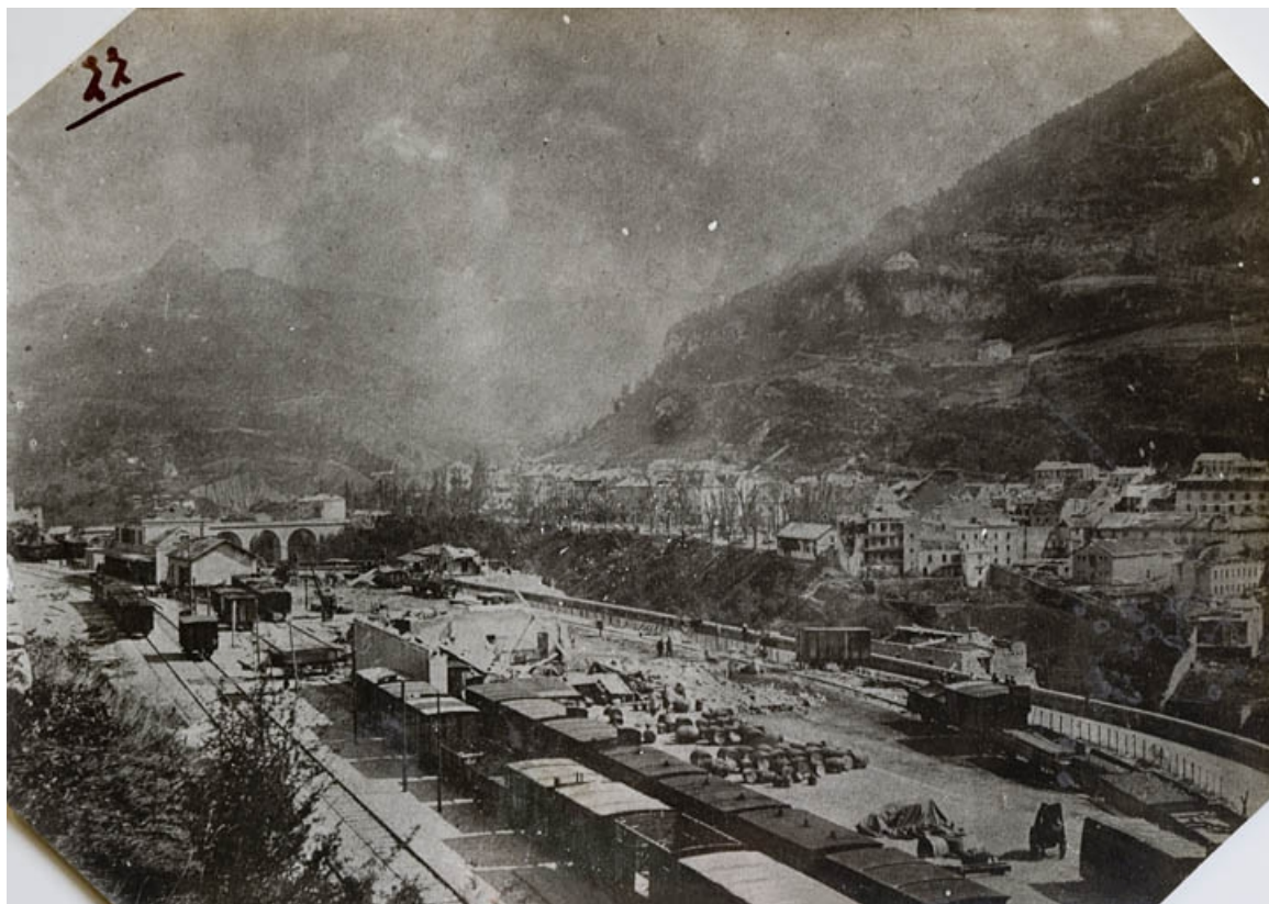
[La gare après le cyclone du 19 août 1890].
