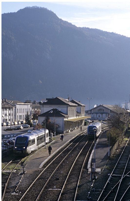
Vue d'ensemble rapprochée depuis le pont routier, au nord. 39, Saint-Claude place de la Gare
