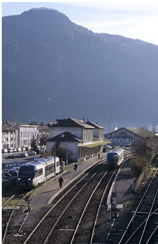
Vue d'ensemble rapprochée depuis le pont routier, au nord. 39, Saint-Claude place de la Gare
