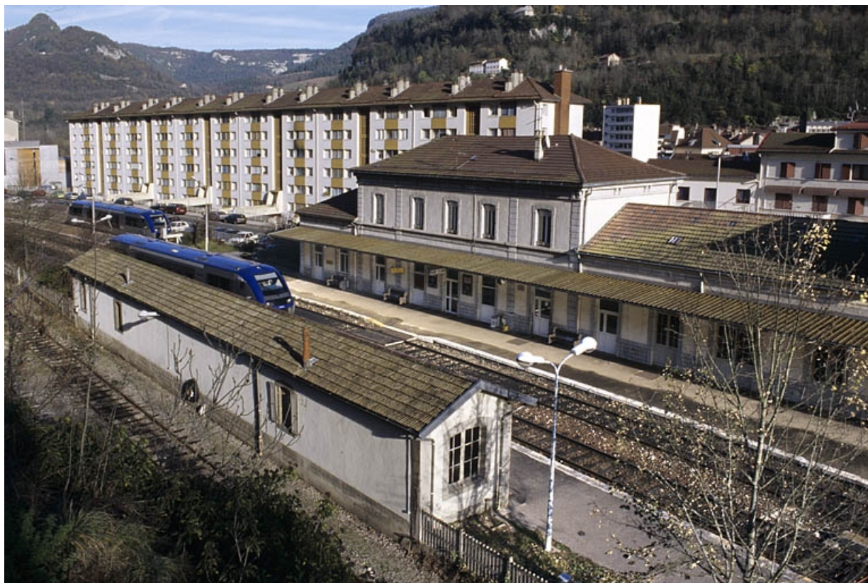
Abri-lampisterie : vue plongeante sur la façade postérieure, de trois quarts droite.
