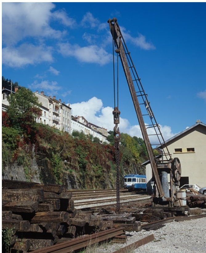
Grue de 6 tonnes, à l'extrémité sud de l'entrepôt.
