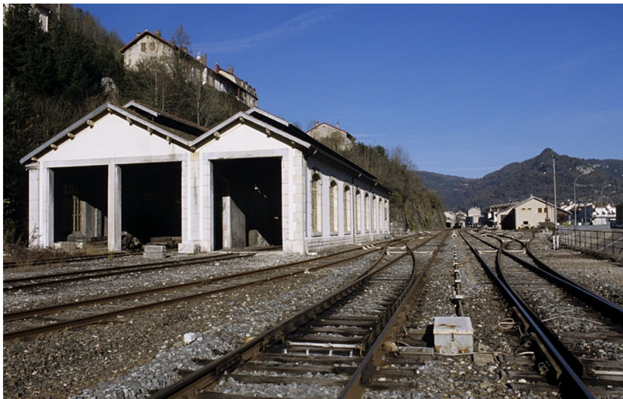
Remise ferroviaire : vue d'ensemble, depuis le sud.
