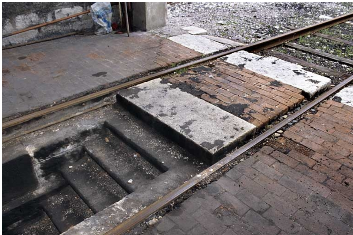
Remise ferroviaire : escalier d'accès à la fosse dans la halle est. 39, Saint-Claude place de la Gare
