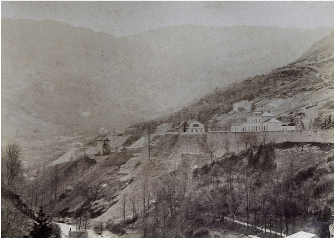
Souvenir de St Claude (Jura). La gare [vue d'ensemble depuis le nord-est], 4e quart 19e siècle. 39, Saint-Claude place de la Gare
