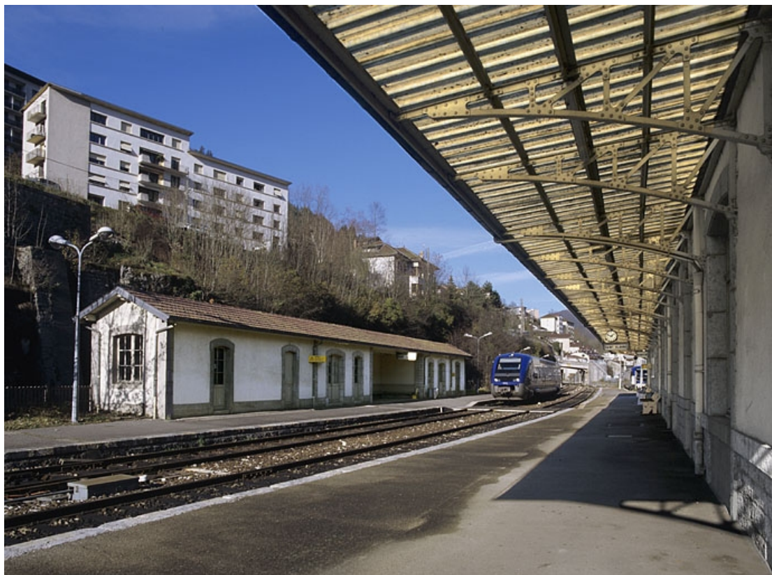
Abri-lampisterie : façade antérieure, de trois quarts gauche.
