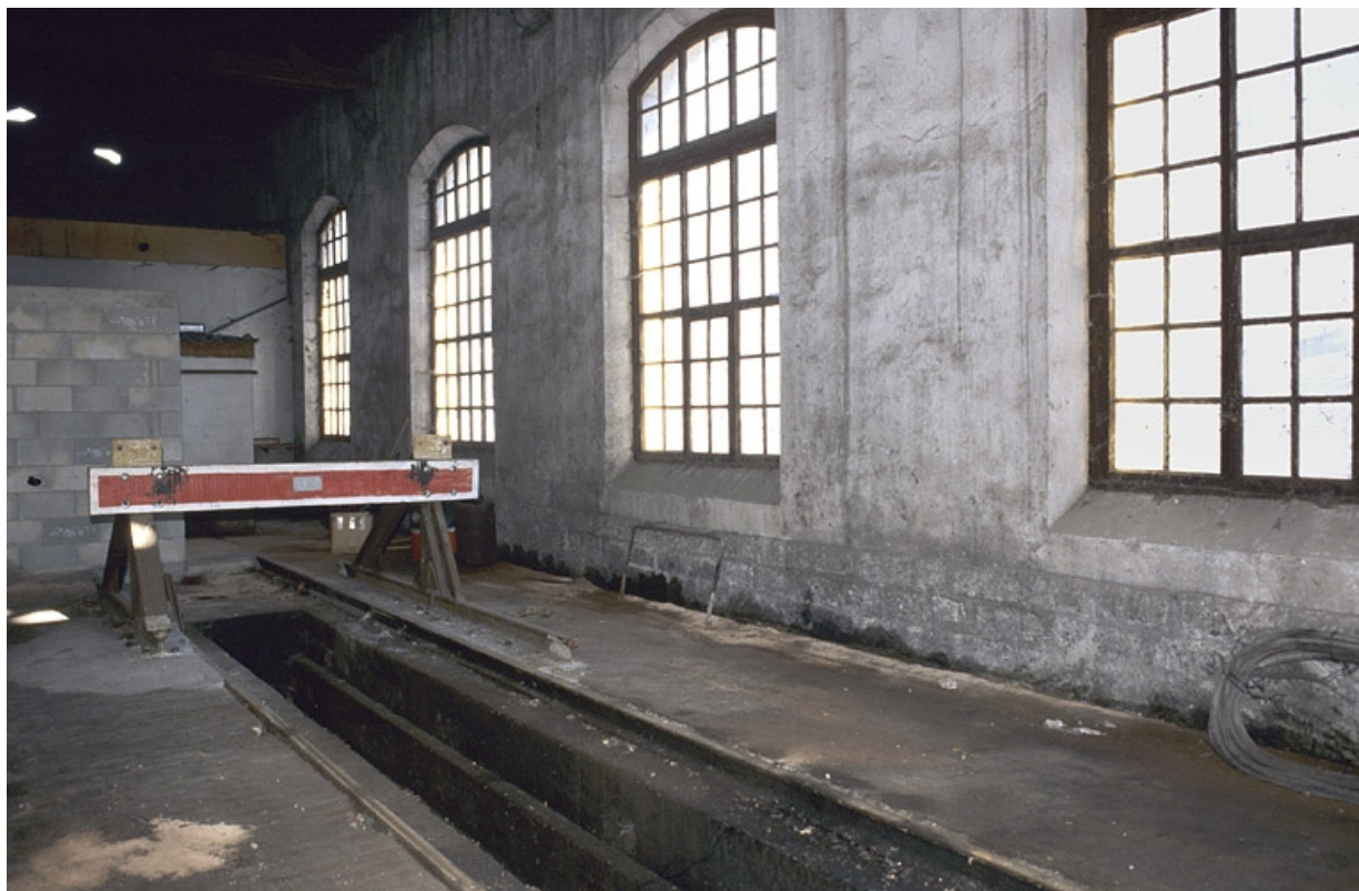
Remise ferroviaire : intérieur de la halle est.
