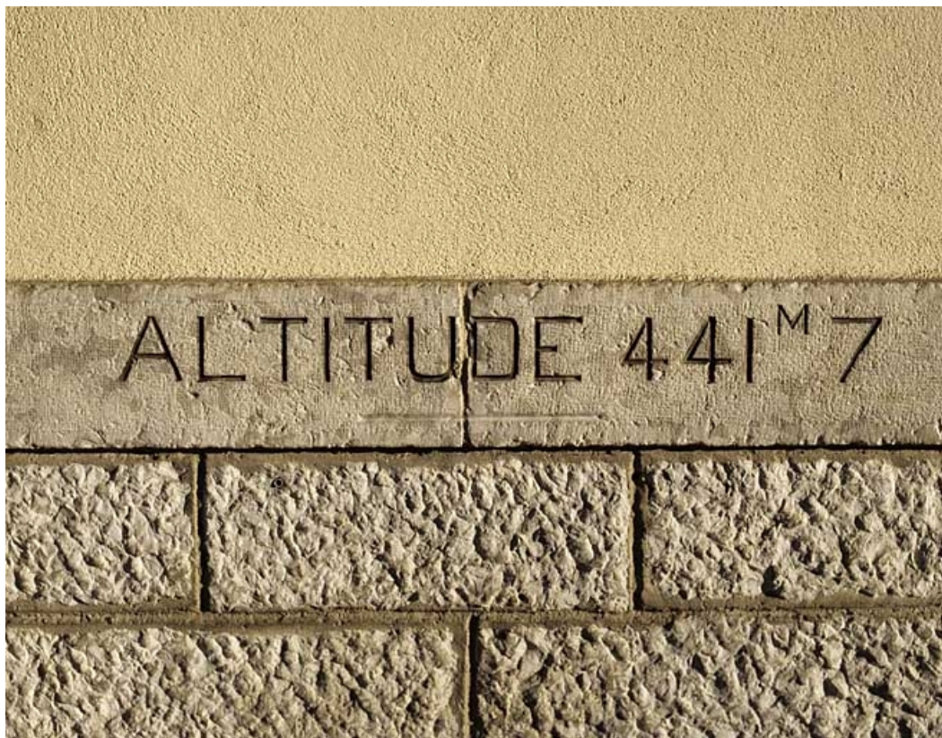
Bâtiment des voyageurs : inscription altimétrique.
