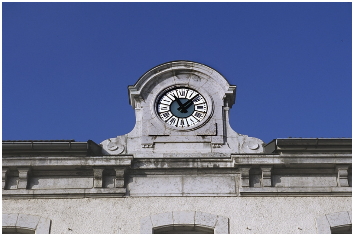
Bâtiment des voyageurs : horloge sur la façade antérieure, vue en contre-plongée.
