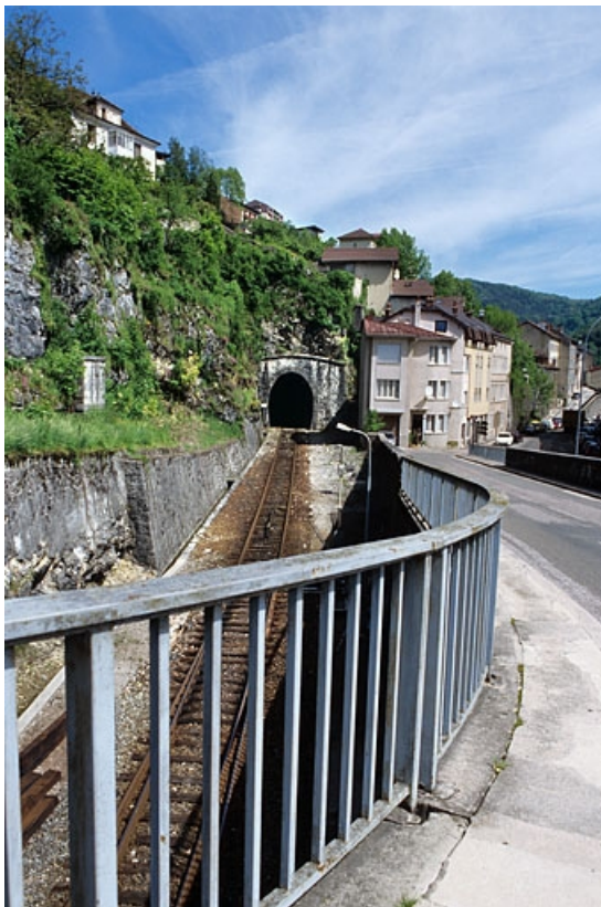
Rampe d'accès et son garde-corps, depuis le pont. À gauche, tunnel de Saint-Claude. 39, Saint-Claude rue du Travail
