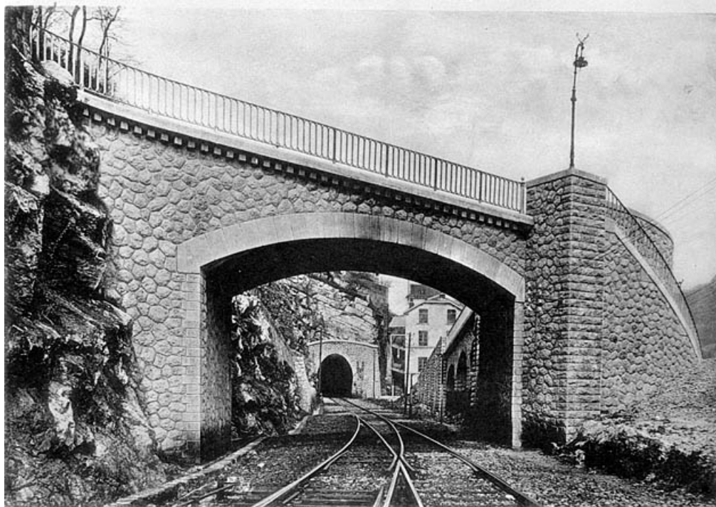
Passage supérieur voûté [...] Pt 238 H + 41 m, [1919].
