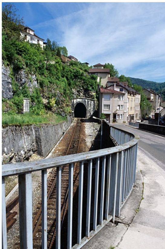
Rampe d'accès et son garde-corps, depuis le pont. À gauche, tunnel de Saint-Claude. 39, Saint-Claude rue du Travail
