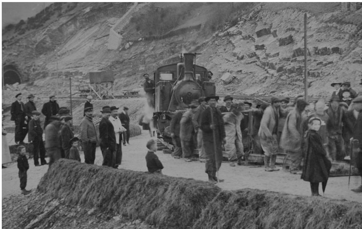
[Pose d'une voie provisoire côté Andelot-en-Montagne], 1912.
