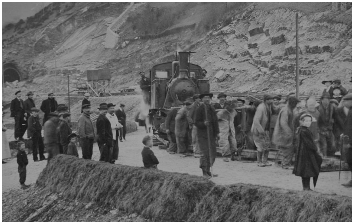
[Pose d'une voie provisoire côté Andelot-en-Montagne], 1912.
