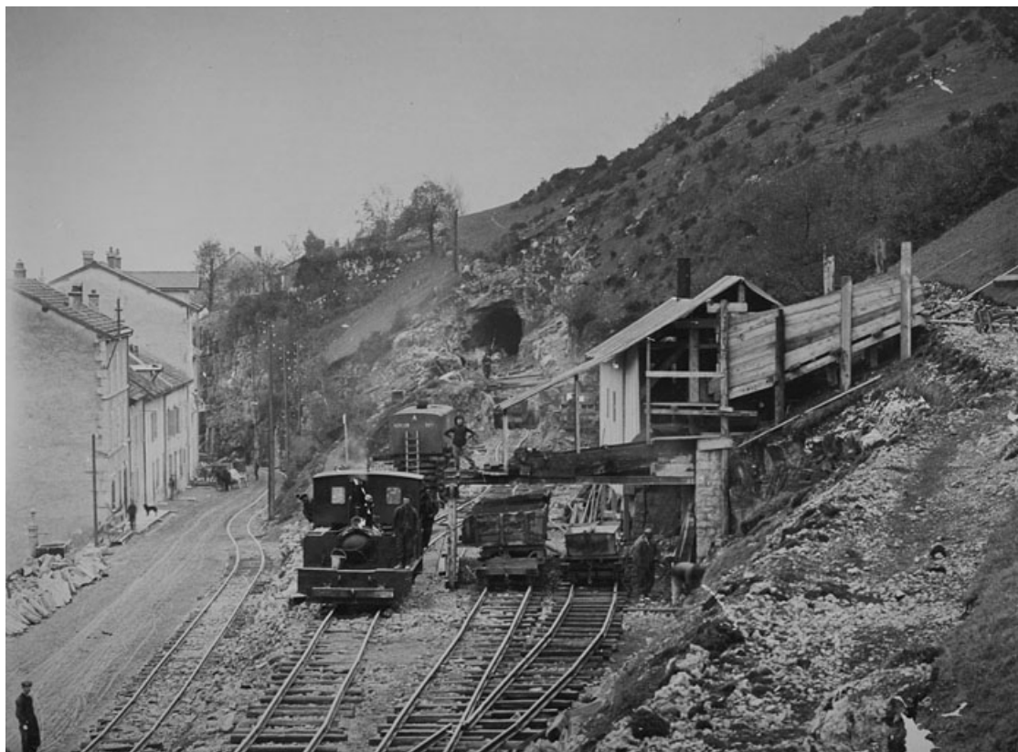
[Perçement du tunnel, côté Andelot-en-Montagne], entre août 1908 et avril 1911. 39, Saint-Claude rue Pasteur
