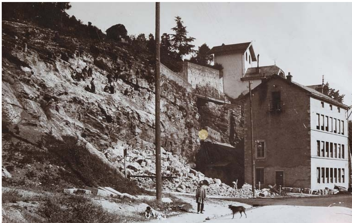
[Création de la plate-forme de la voie à la tête du tunnel côté La Cluse], entre août 1908 et avril 1911. 39, Saint-Claude rue Pasteur
