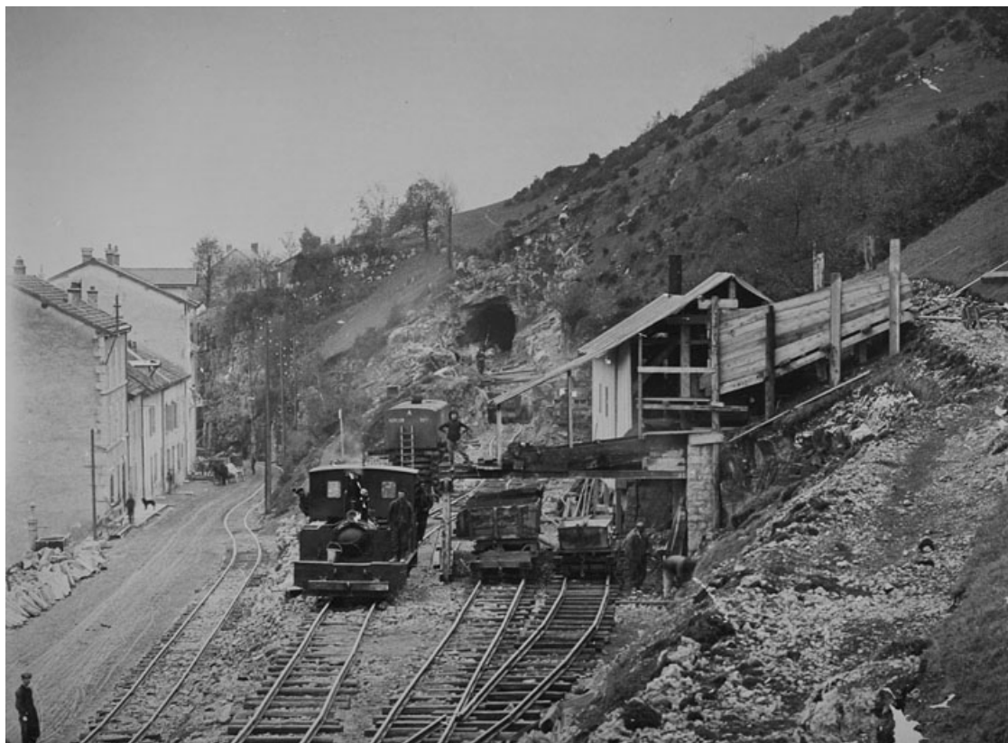
[Perçement du tunnel, côté Andelot-en-Montagne], entre août 1908 et avril 1911.
