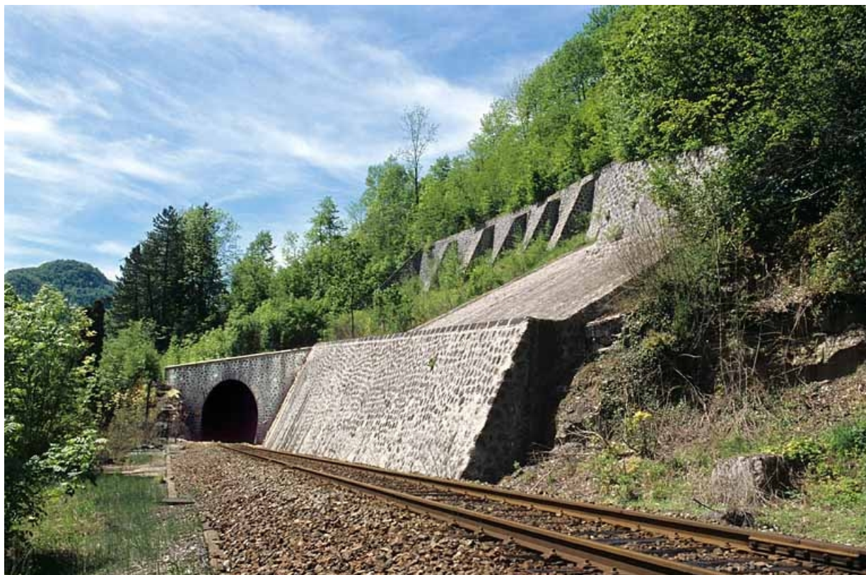
Vue d'ensemble, depuis le nord : murs de soutènement et tête côté Andelot-en-Montagne. 39, Saint-Claude rue Pasteur
