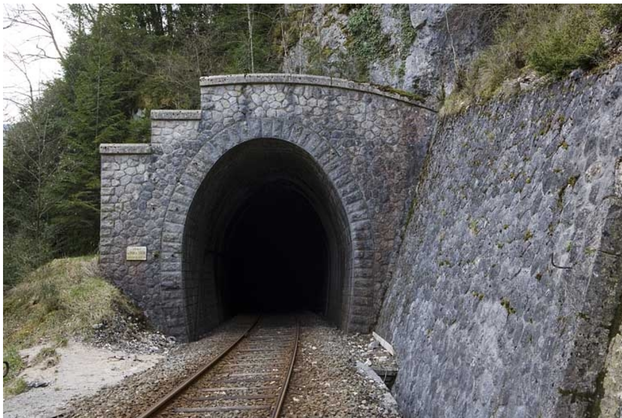
Tunnel : tête côté Andelot-en-Montagne (nord).
