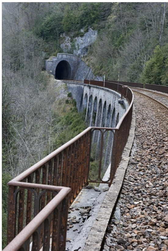
Vue d'ensemble, depuis l'extrémité du viaduc côté Andelot-en-Montagne (nord). 39, Saint-Claude, lieudit : sur les Saints
