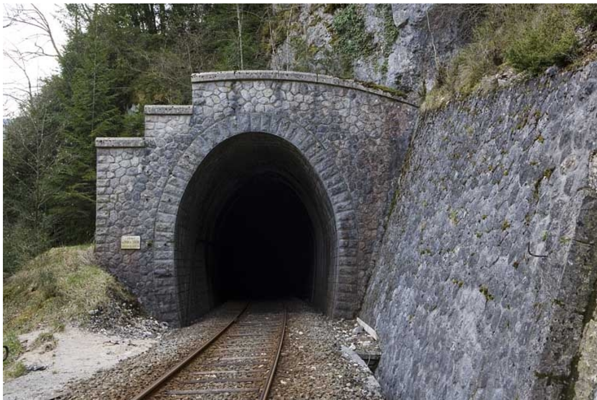
Tunnel : tête côté Andelot-en-Montagne (nord).
