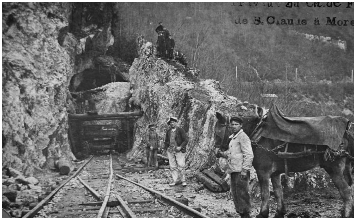
Travaux du Ch. de Fer de S. Claude à Morez [perçement du tunnel du Pain de Sucre, avec personnages et chantier côté La Cluse], 1909-1910.
