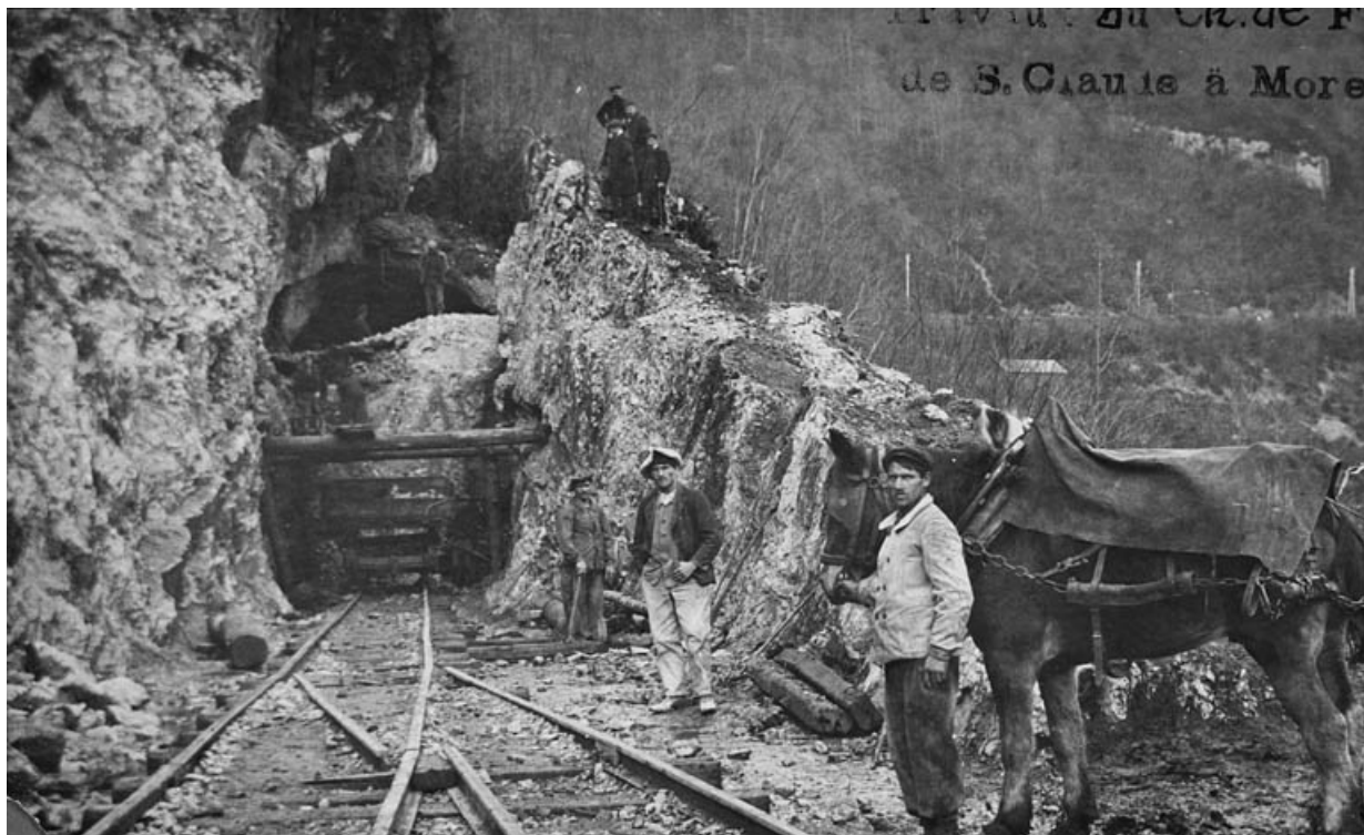
Travaux du Ch. de Fer de S. Claude à Morez [perçement du tunnel du Pain de Sucre, avec personnages et chantier côté La Cluse], 1909-1910.
