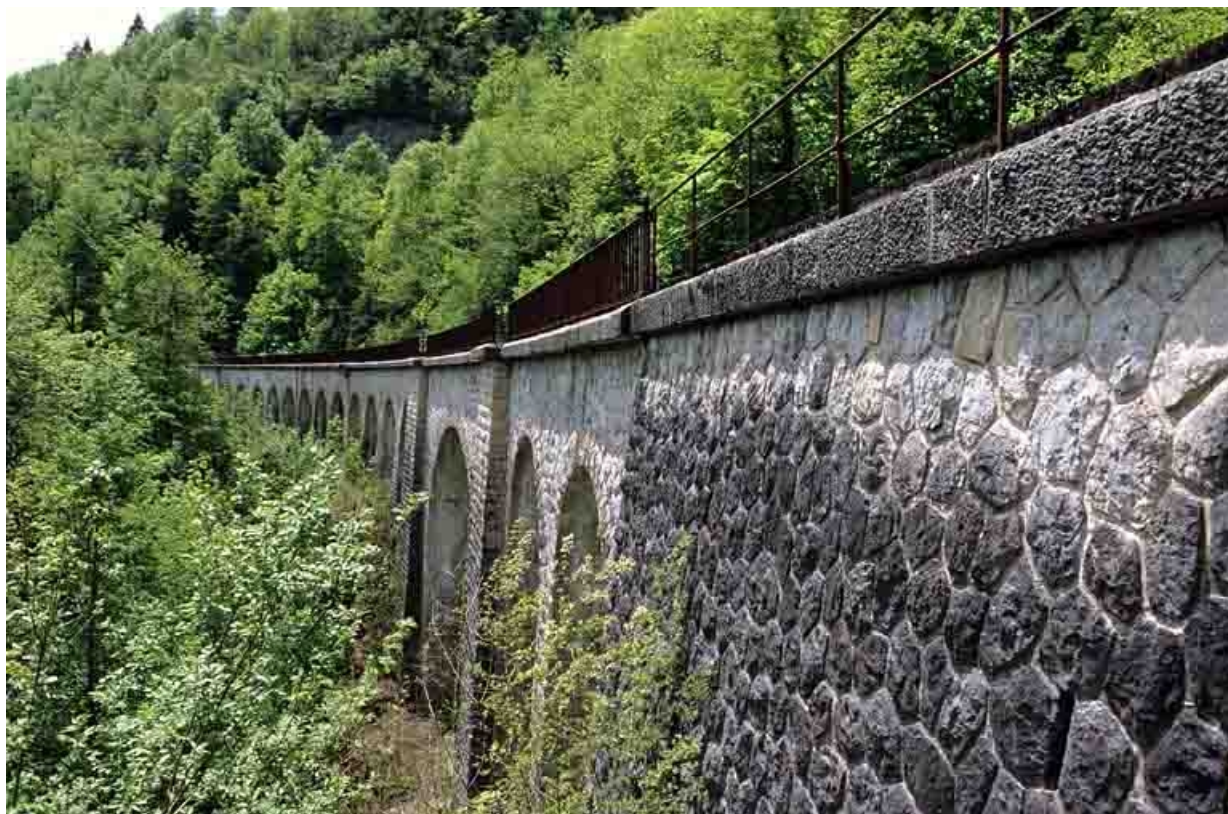
Viaduc : élévation aval vue en enfilade, depuis le côté Andelot-en-Montagne (nord).
