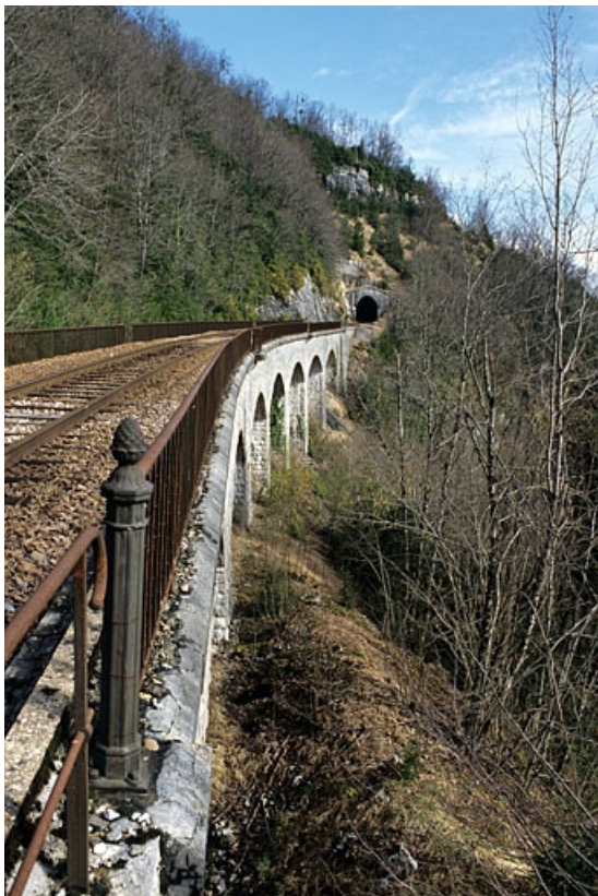
Viaduc de la Grande Roche et tunnel du Crapaud : vue d'ensemble, depuis le côté La Cluse (sud). 39, Saint-Claude, lieudit : sous la Roche
