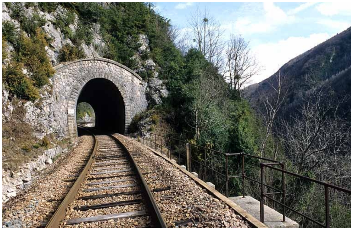
Tunnel du Champ de Bienne : tête côté La Cluse (sud). Mur de soutènement à gauche. 39, Saint-Claude, lieudit : sous la Roche
