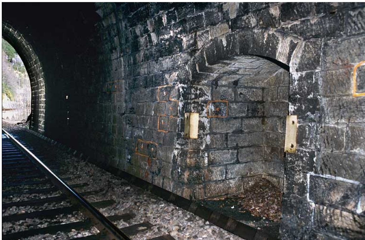
Tunnel du Champ de Bienne : refuge. 39, Saint-Claude, lieudit : sous la Roche
