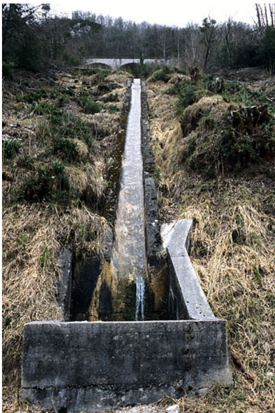
Viaduc de la Grande Roche : partie inférieure de l'aqueduc.
