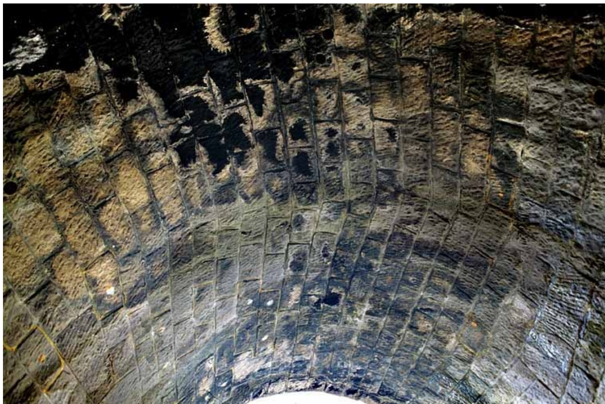
Tunnel du Champ de Bienne : détail de la voûte.
