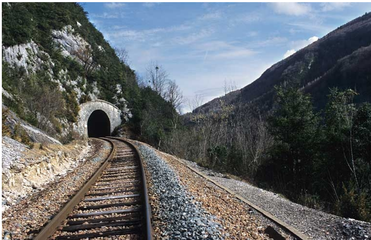
Tunnel du Champ de Bienne : vue d'ensemble, côté La Cluse (sud). 39, Saint-Claude, lieudit : sous la Roche
