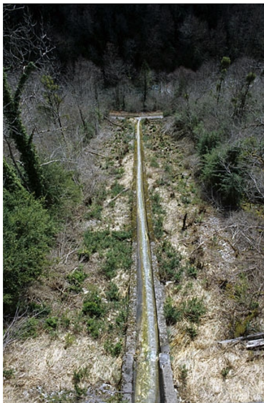
Viaduc de la Grande Roche : vue d'ensemble plongeante sur l'aqueduc.
