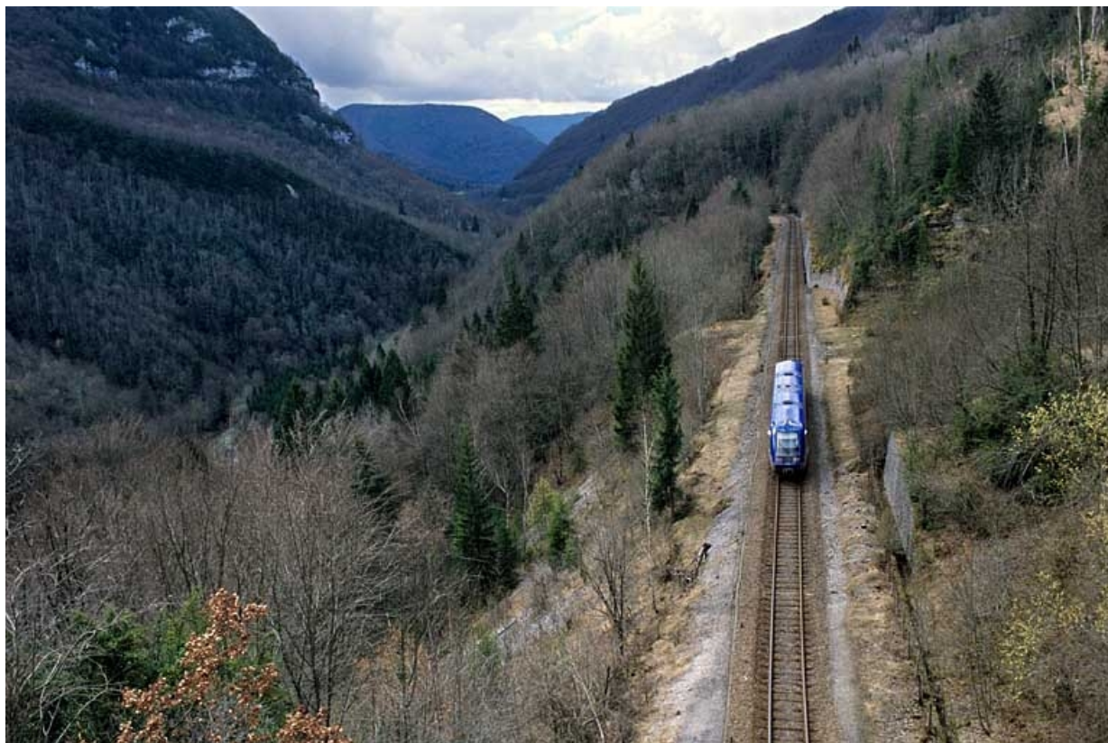
Voie ferrée à l'emplacement de l'ancienne station de Valfin, avec autorail X 73500, depuis le chemin surmontant la tête du tunnel côté La Cluse (sud).
