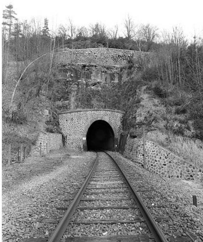
Tunnel : tête côté La Cluse (sud).
