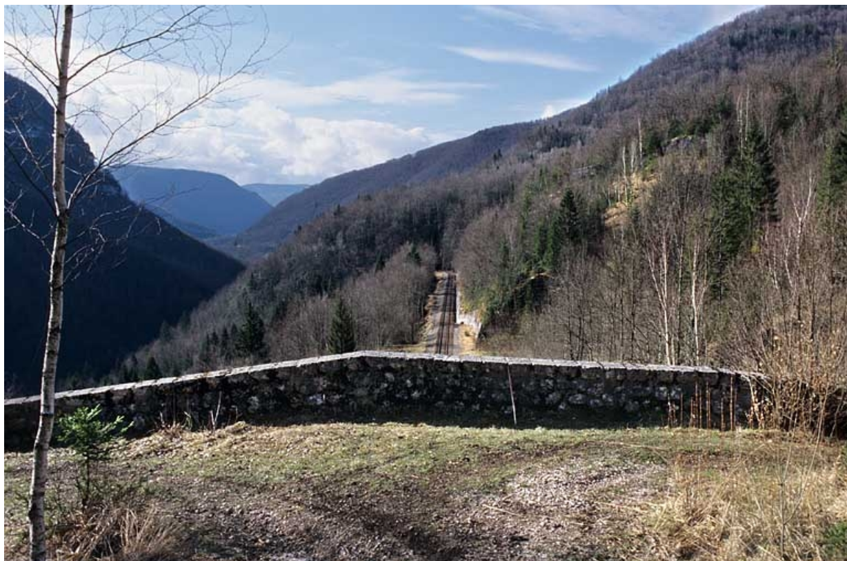
Tunnel : mur de protection de la tête côté La Cluse, depuis le chemin qui la surmonte, avec vue sur la vallée de la Bienne. 39, Saint-Claude chemin de la Gare, lieudit : Valfin-lès-Saint-Claude
