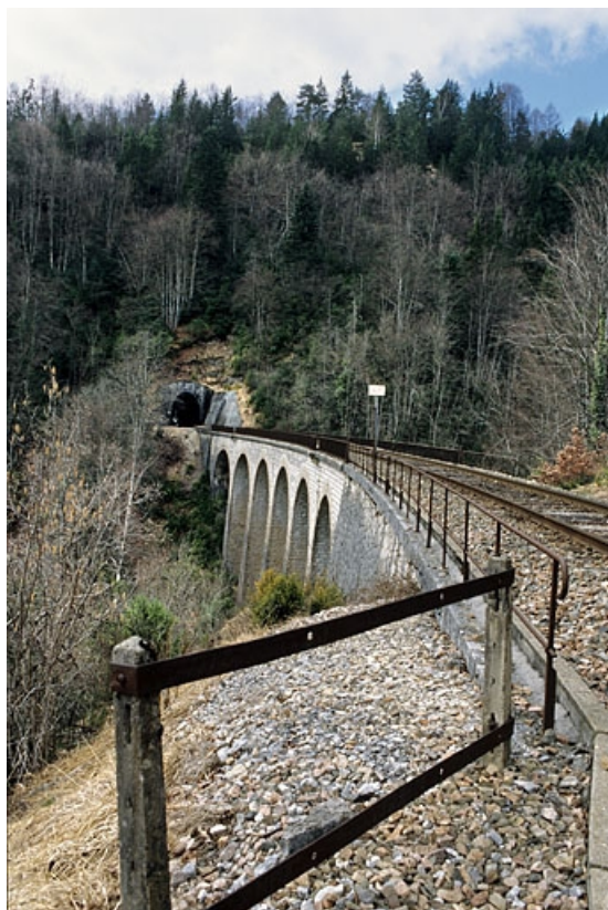
Vue d'ensemble, depuis le côté Andelot-en-Montagne (est).
