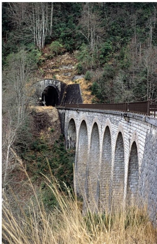
Viaduc : élévation aval, vue en enfilade depuis le côté Andelot-en-Montagne. 39, Saint-Claude chemin de la Gare, lieudit : Valfin-lès-Saint-Claude
