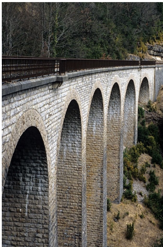
Viaduc : piles de l'élévation aval, vues en enfilade depuis le côté La Cluse.
