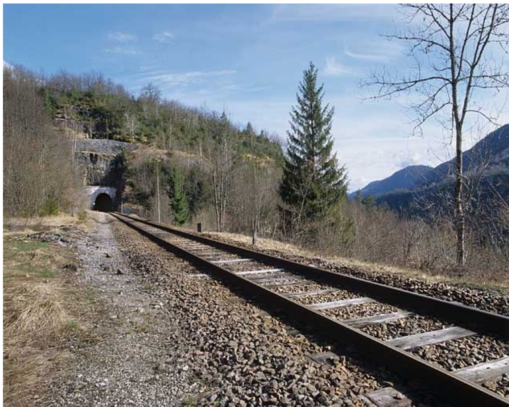
Vue d'ensemble, depuis le côté La Cluse (sud). À gauche, emplacement de l'ancienne station de Valfin. 39, Saint-Claude chemin de la Gare, lieudit : Valfin-lès-Saint-Claude
