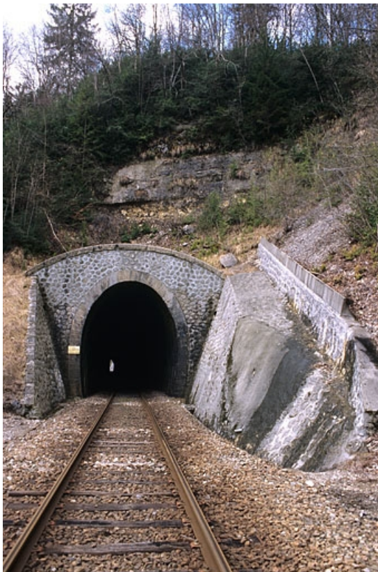
Tunnel des Frettes : tête côté Andelot-en-Montagne (nord). 39, La Rixouse, lieudit : les Cotats
