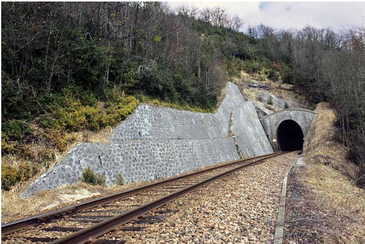
Tunnel des Frettes : vue d'ensemble côté La Cluse (sud).
